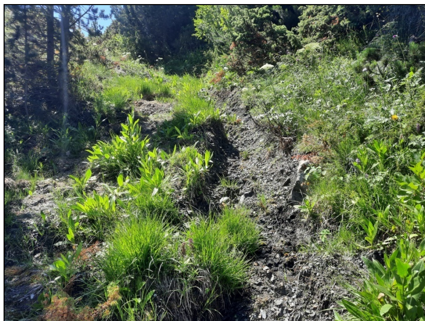
ZH 02073010: Afectació per l'obertura d'una rasa drenant
