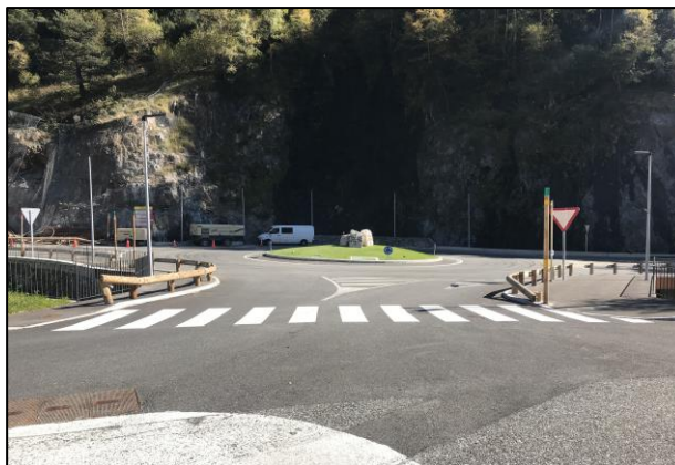
Vista de la nova rotonda d'accés a les Salines
