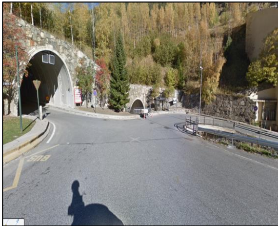
Zona de control Entrada del túnel
