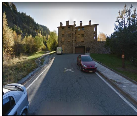
Zona de control Edifici Velvet
