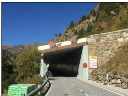
Galeries de seguretat
