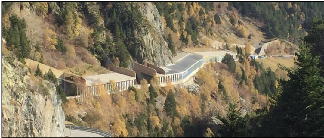
Vista panoràmica de la zona de galeries
