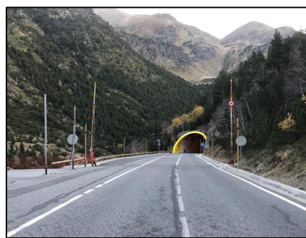
Boca nord del túnel d'Arcalís
