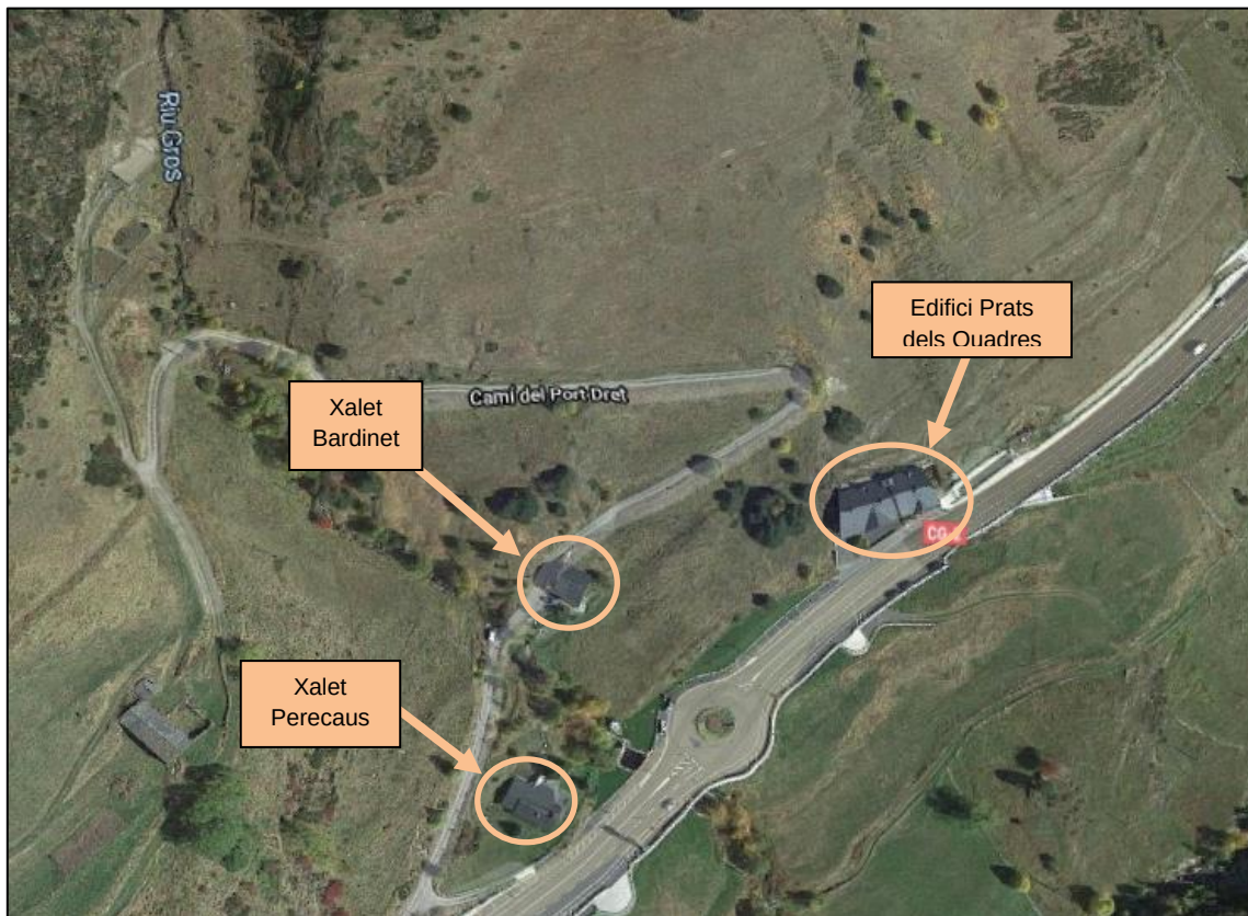
Vista general dels habitatges afectats
