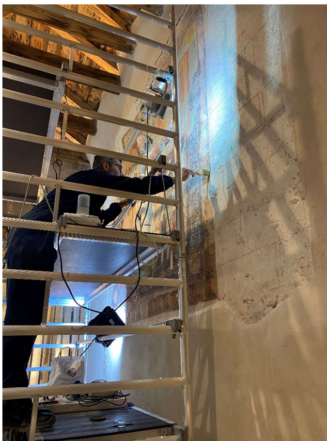
Neteja mecànica del mural amb aspirador i paletina abans d'aplicar-hi la capa de protecció final.
