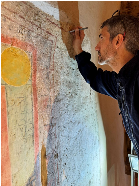
Fotos de detall del procés d'eliminació de les restes de les dos capes de pintura a la calç blanca que hi havia per sobre de l'original.
