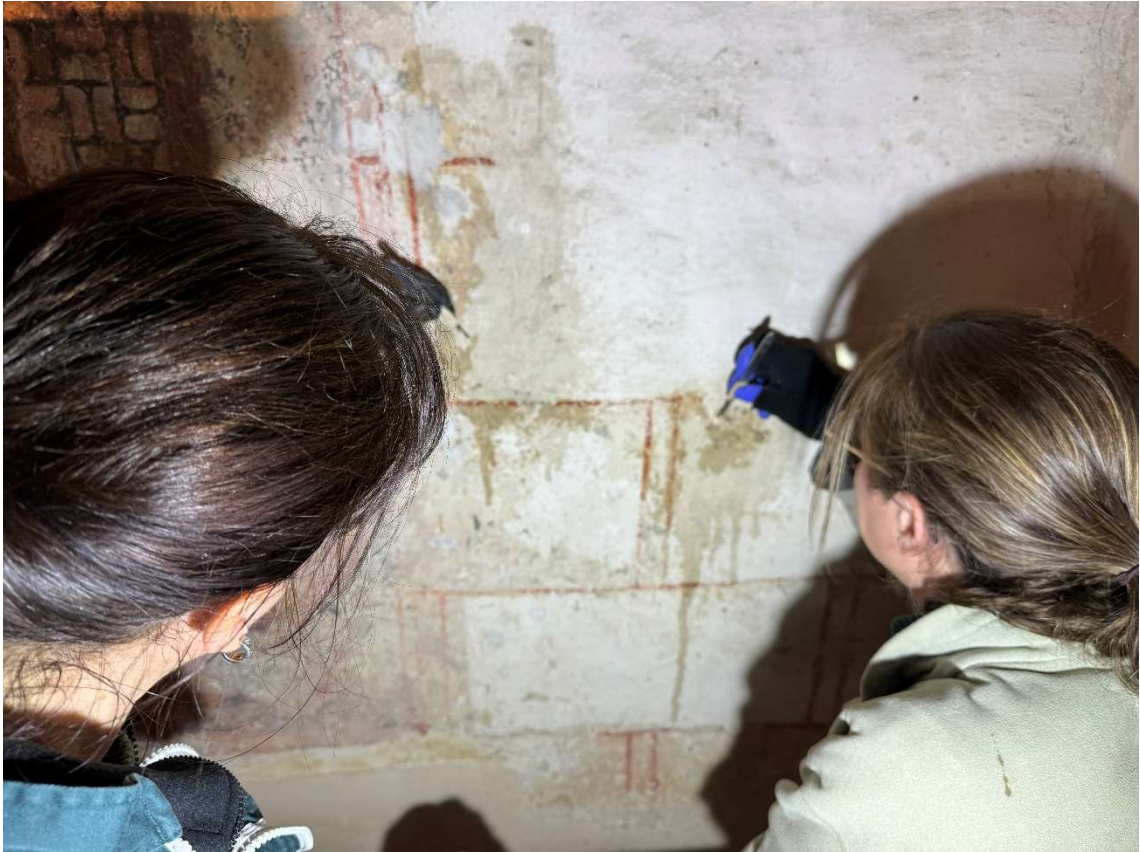
Fotos de detall del procés d'eliminació de les restes de les dos capes de pintura a la calç blanca que hi havia per sobre de l'original.
