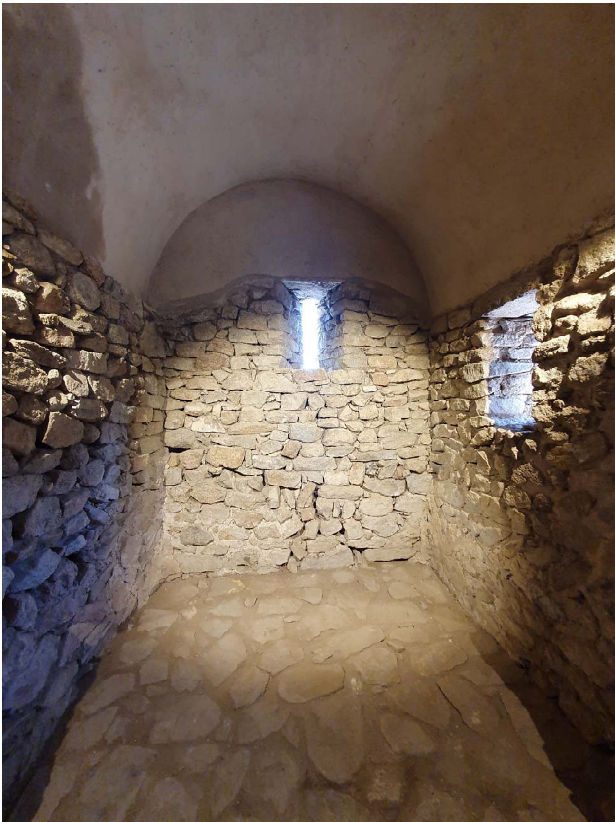
Fotografia 18. Detall de l'interior del presbiteri amb el seu paviment recol·locat i anivellat
