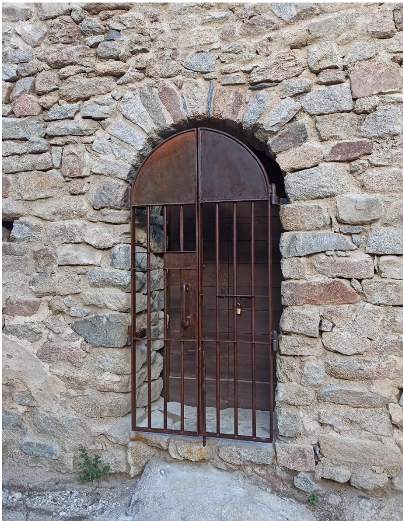
Fig. 11 – Detall de la nova reixa exterior i de la porta de fusta interior reparada.
