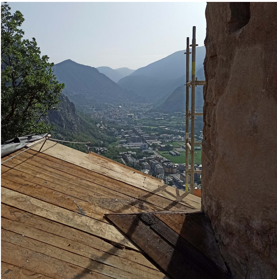
Fotografia 62. Vista de de l'empostissat de la coberta de fusta mantinguda
