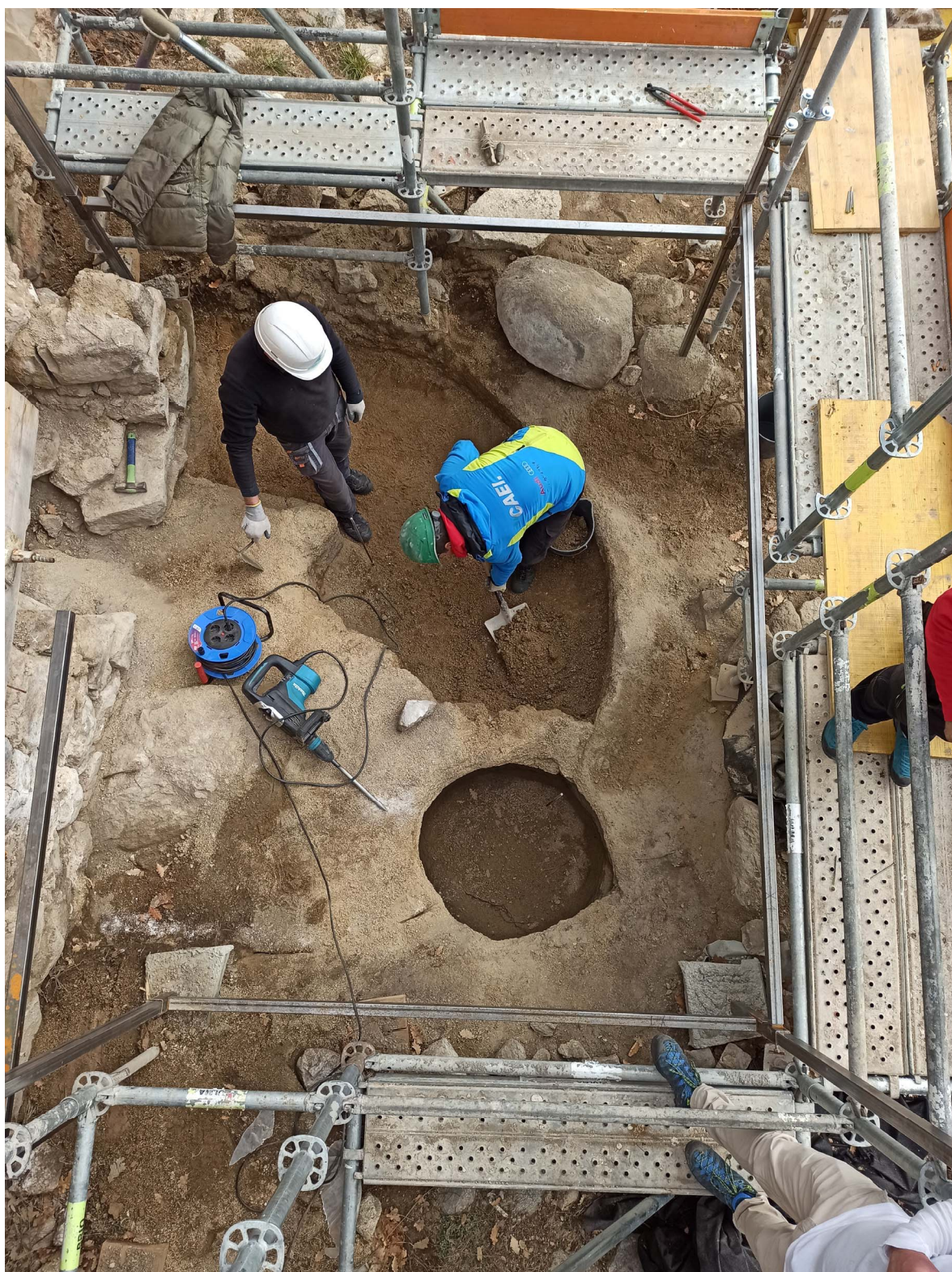
Fotografia 12. Imatge que mostra l'inici dels treballs d'excavació de la nova fonamentació per al campanar
