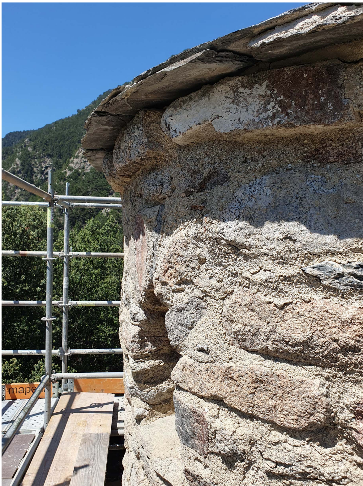
Fotografia 47. Detall del ràfec acabat de la coberta del campanar
