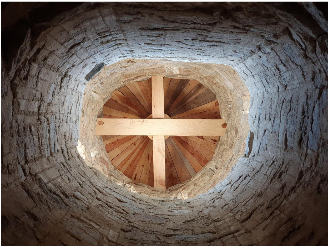
Fig. 20 - Aspecte de l'interior del campanar reconstruït, i de l'estructura de fusta del cobriment amb el seu empostissat de fusta.
