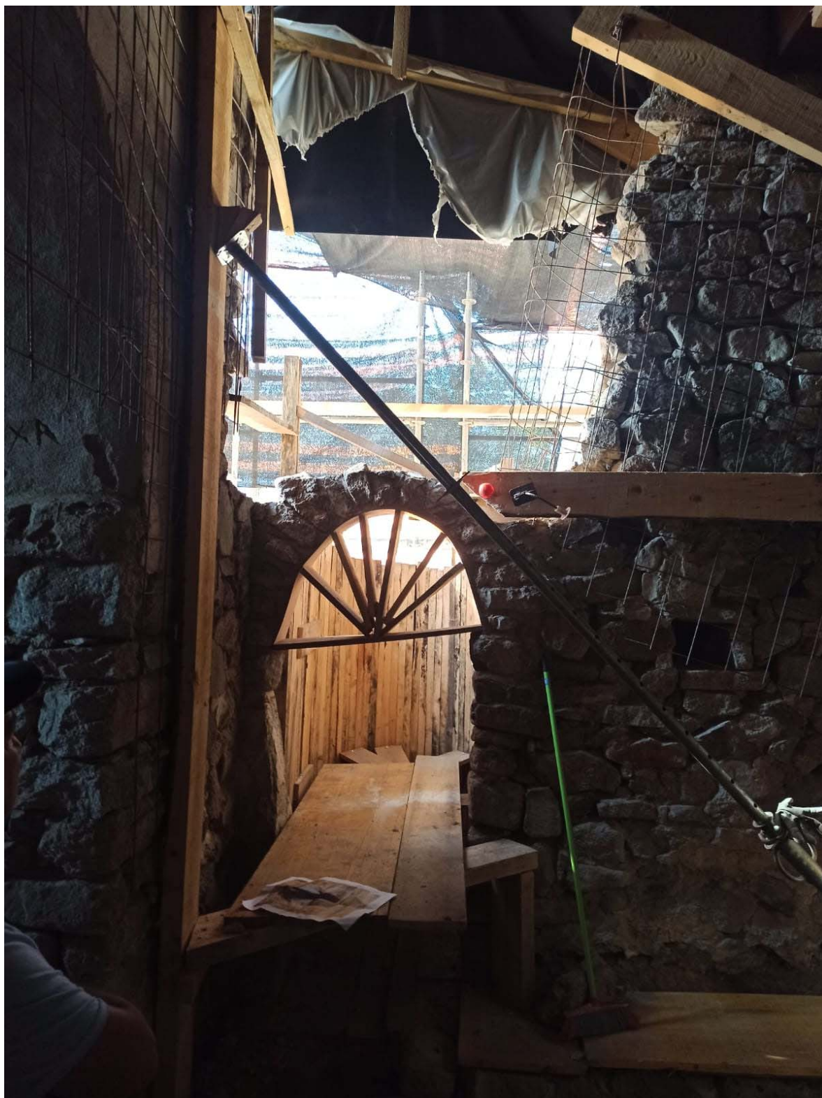
Fotografia 26. Imatge d'un estat més avançat de la reconstrucció de la mateixa porta
