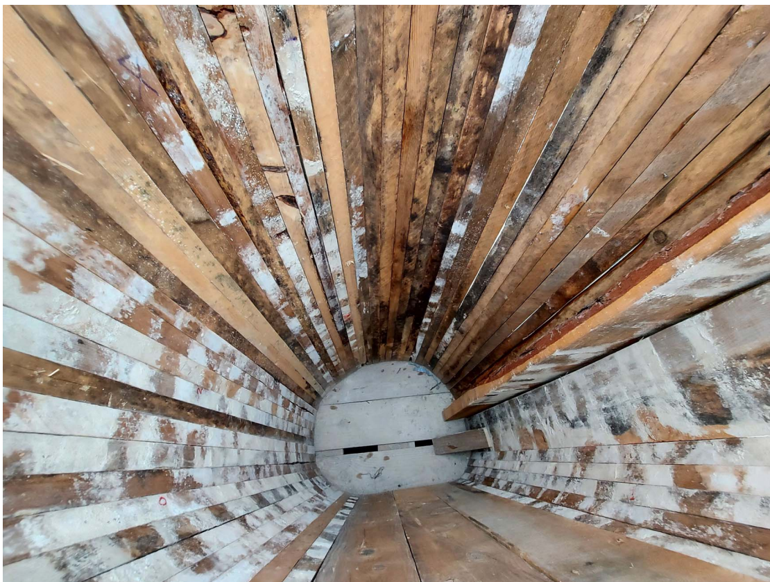
Fotografia 19. Vista cenital de l'interior de l'encofrat utilitzat per definir la cara interior del campanar
