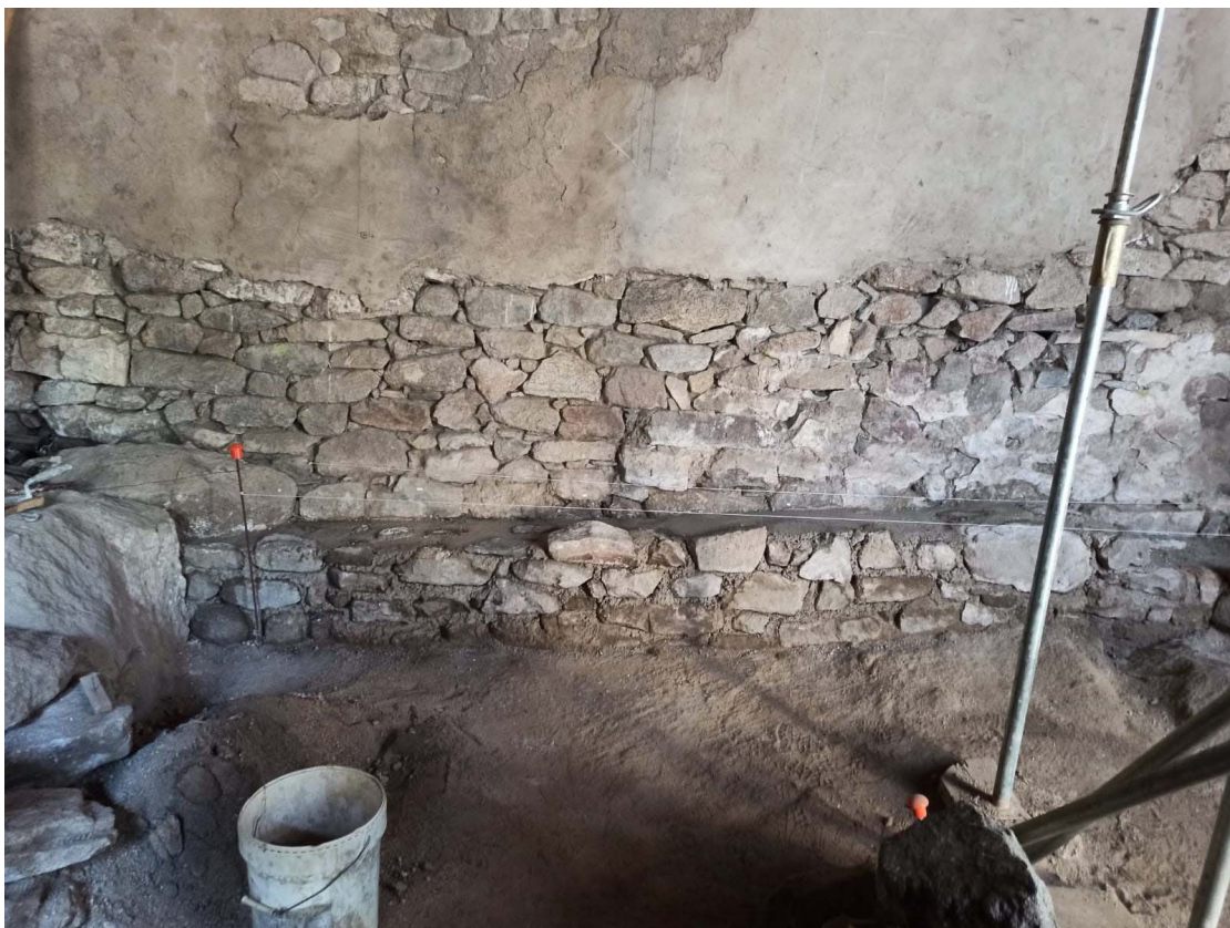
Fotografia 57. Imatge que mostra els treballs de reconstrucció de la bancada perimetral a l'interior de la nau
