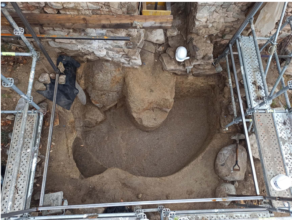
Fotografia 14. Aspecte de la rasa de fonamentació del campanar un cop finalitzada
