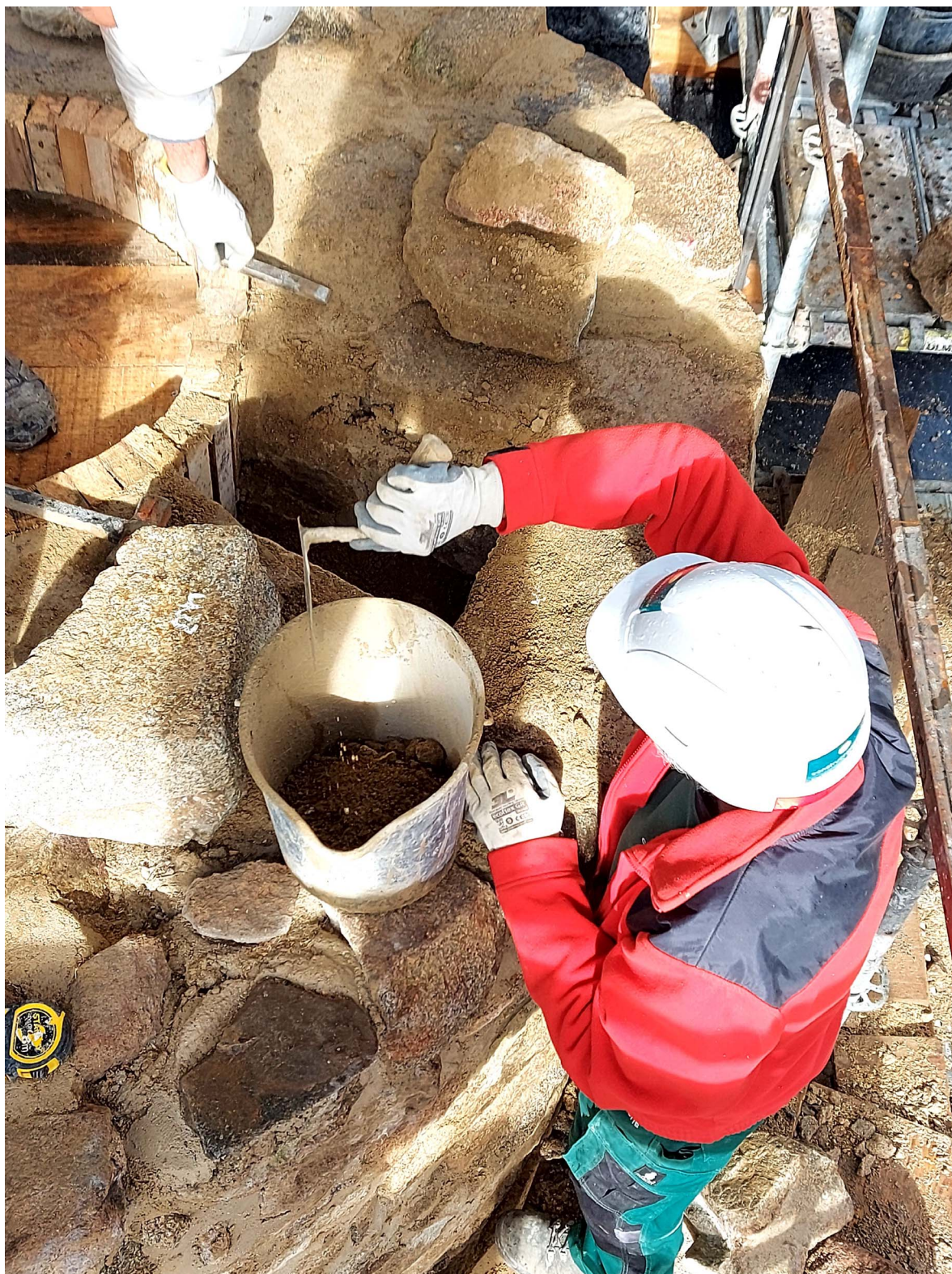
Fotografia 21. Imatge del meticulós procés de col·locació de les pedres en la seva posició original
