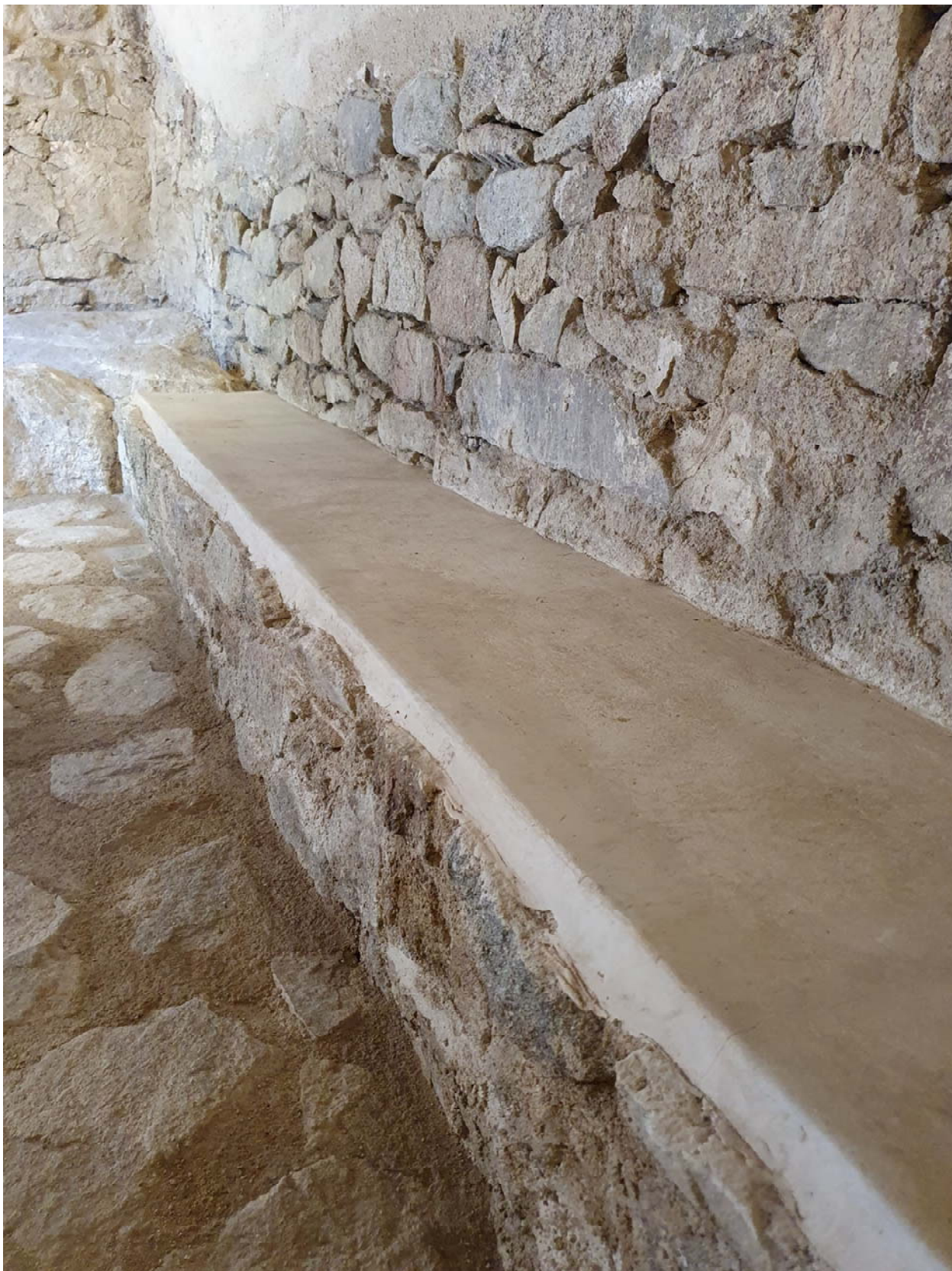
Fotografia 16. Detall del banc de fàbrica de maçoneria perimetral restituït i del seu remat superior fet amb morter de calç
