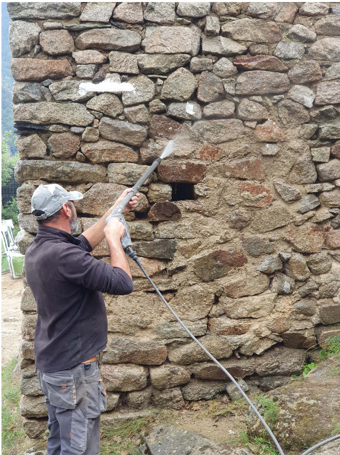
Fotografia 68. Prova d'acabat amb aigua a pressió dels rejuntats amb morter fets al parament exterior del presbiteri
