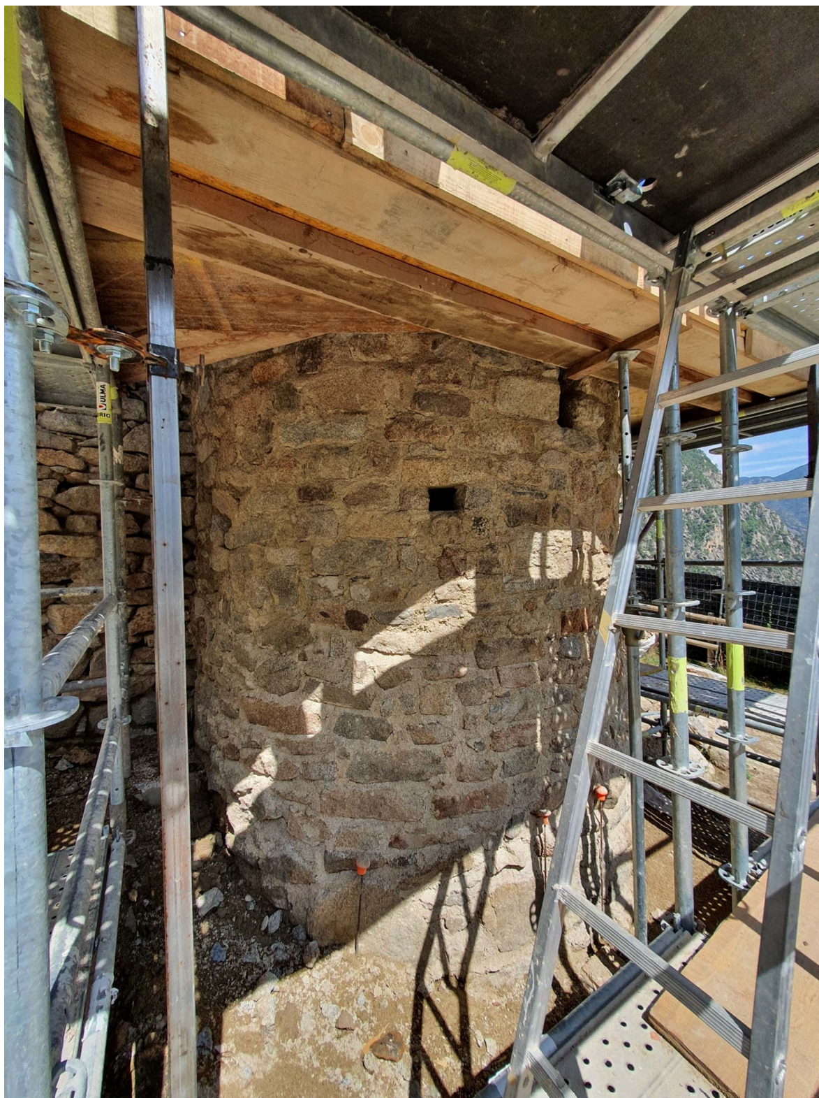
Fotografia 27. Detall de el campanar reconstruït fins aproximadament mitja alçada
