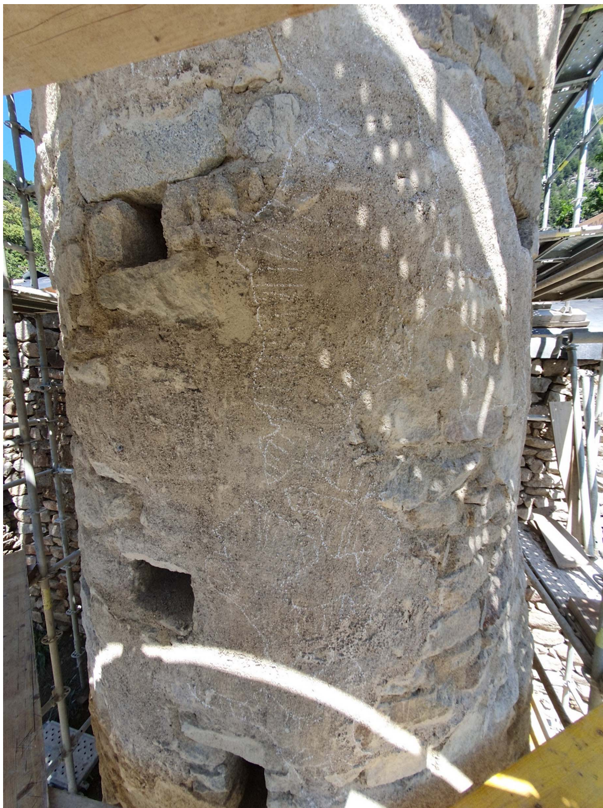
Fotografia 56. Replanteig sobre la capa base del revestiment de les zones on es volia aplicar la segona capa d'acabat amb morter de calç aèria
