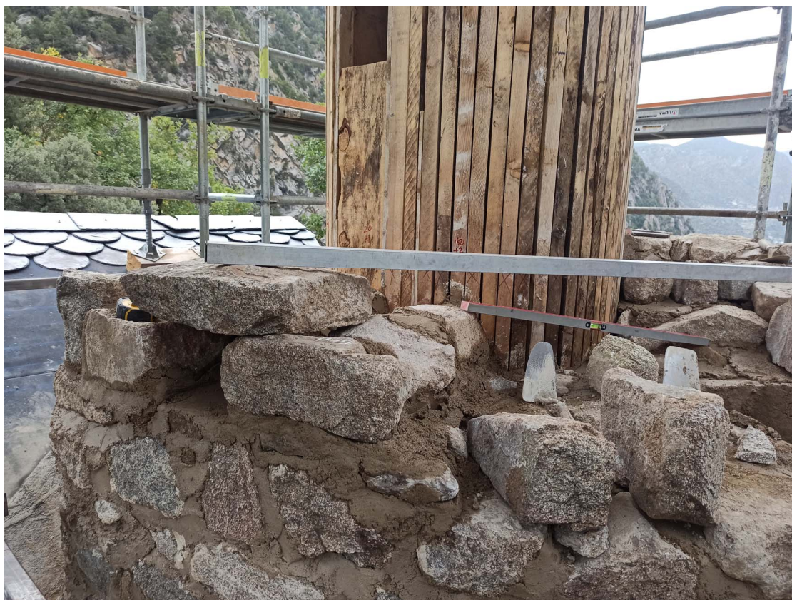
Fotografia 38. Vista des d'un angle diferent de la mateixa fase de l'obra
