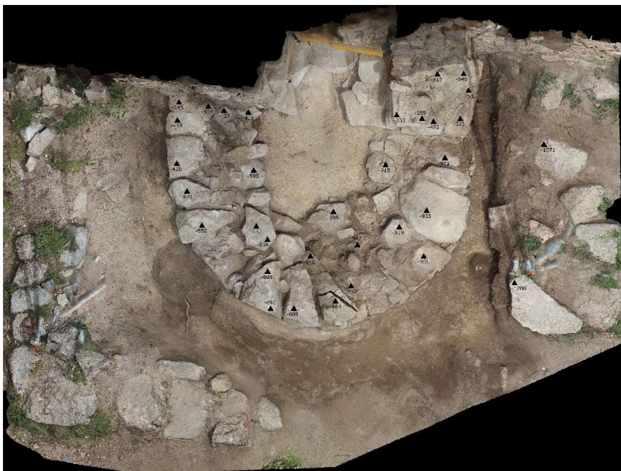
Fig. 2 - Imatge generada a partir del model 3D de les restes de la base del campanar fet per facilitar-ne la reconstrucció després del seu necessari desmuntatge.
