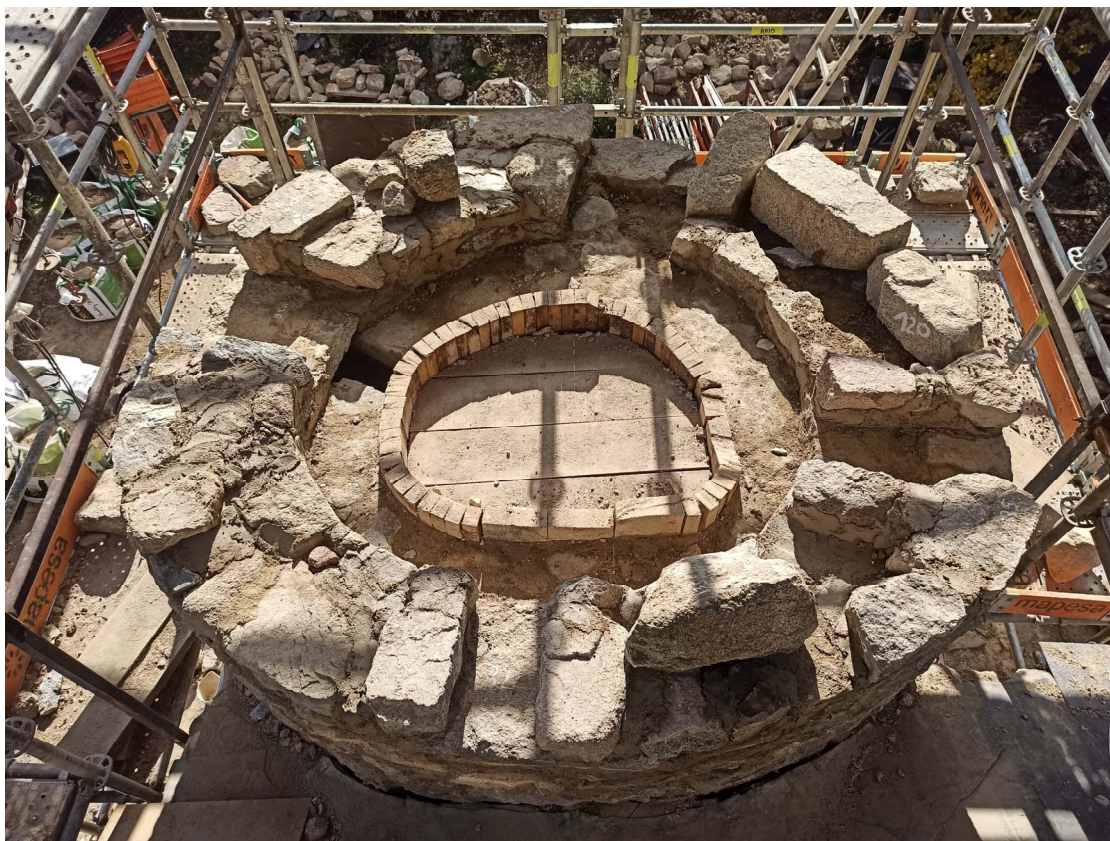
Fotografia 37. Imatge que mostra la reducció del gruix del mur un cop assolit el nivell inferior de les finestres
