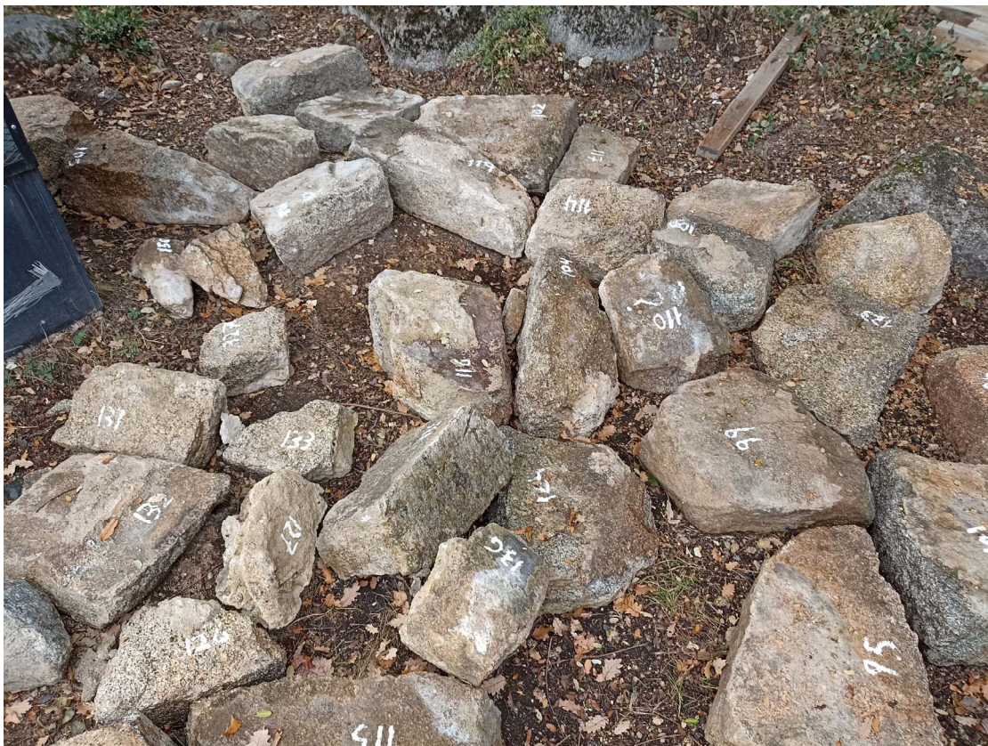
Fotografia 1. Part del conjunt de pedres identificades i numerades pendent de ser col·locades
