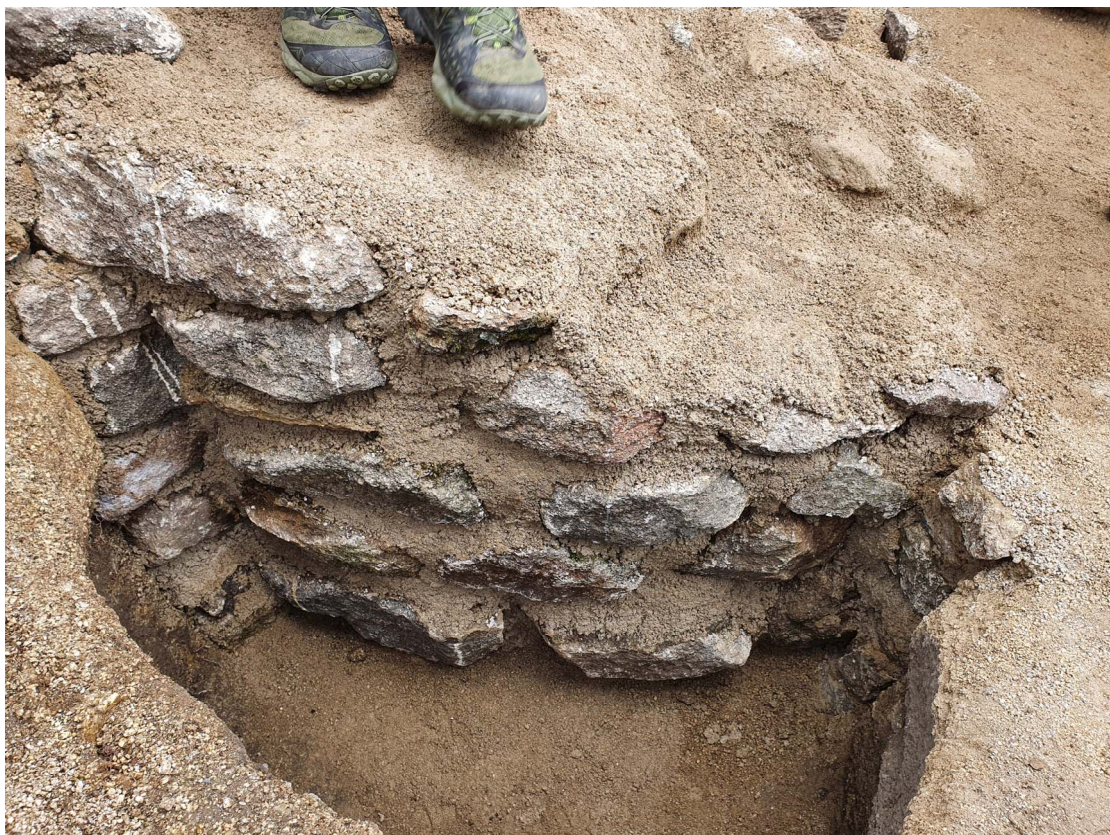
Fotografia 16. Detall de la nova fonamentació del campanar en l'encontre amb una de les dues sitges
