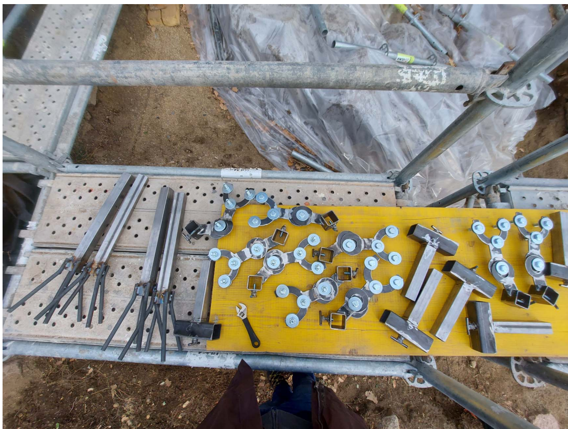
Fotografia 7. Detall de les peces especials que conformen el sistema de referència solidari a la bastida
