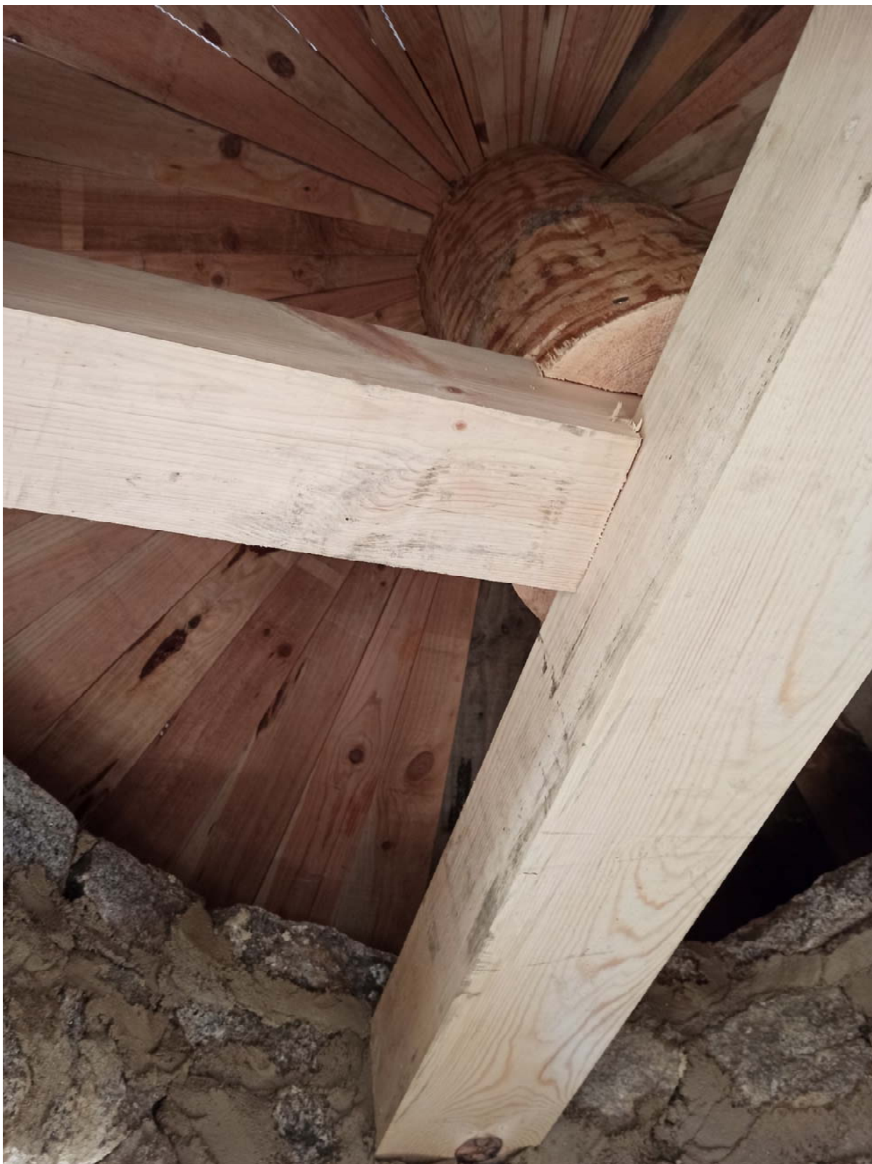
Fotografia 22. Detall de l'estructura i empostissat de fusta de la coberta del campanar
