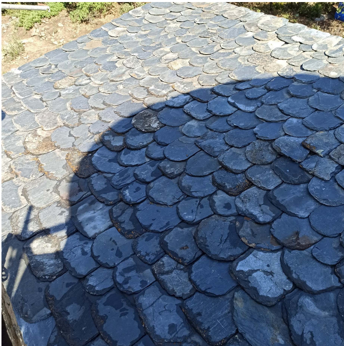
Fotografia 66. Vista del cobriment del vessant sud de la coberta un cop finalitzat
