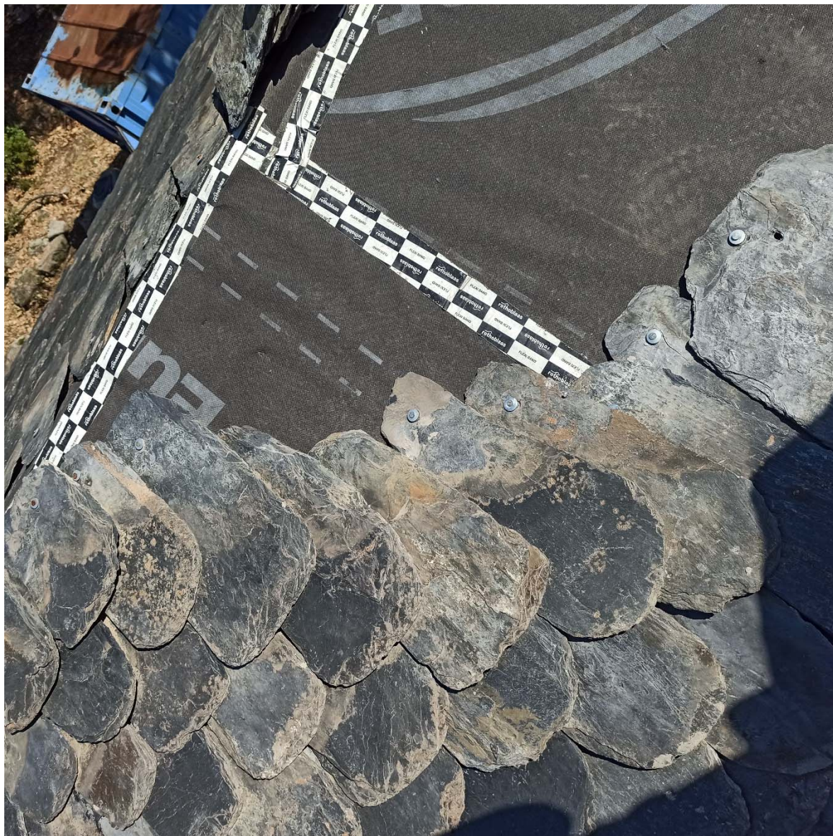
Fotografia 65. Detall d'aquest procés de renovació del cobriment de lloses de pissarra de la coberta
