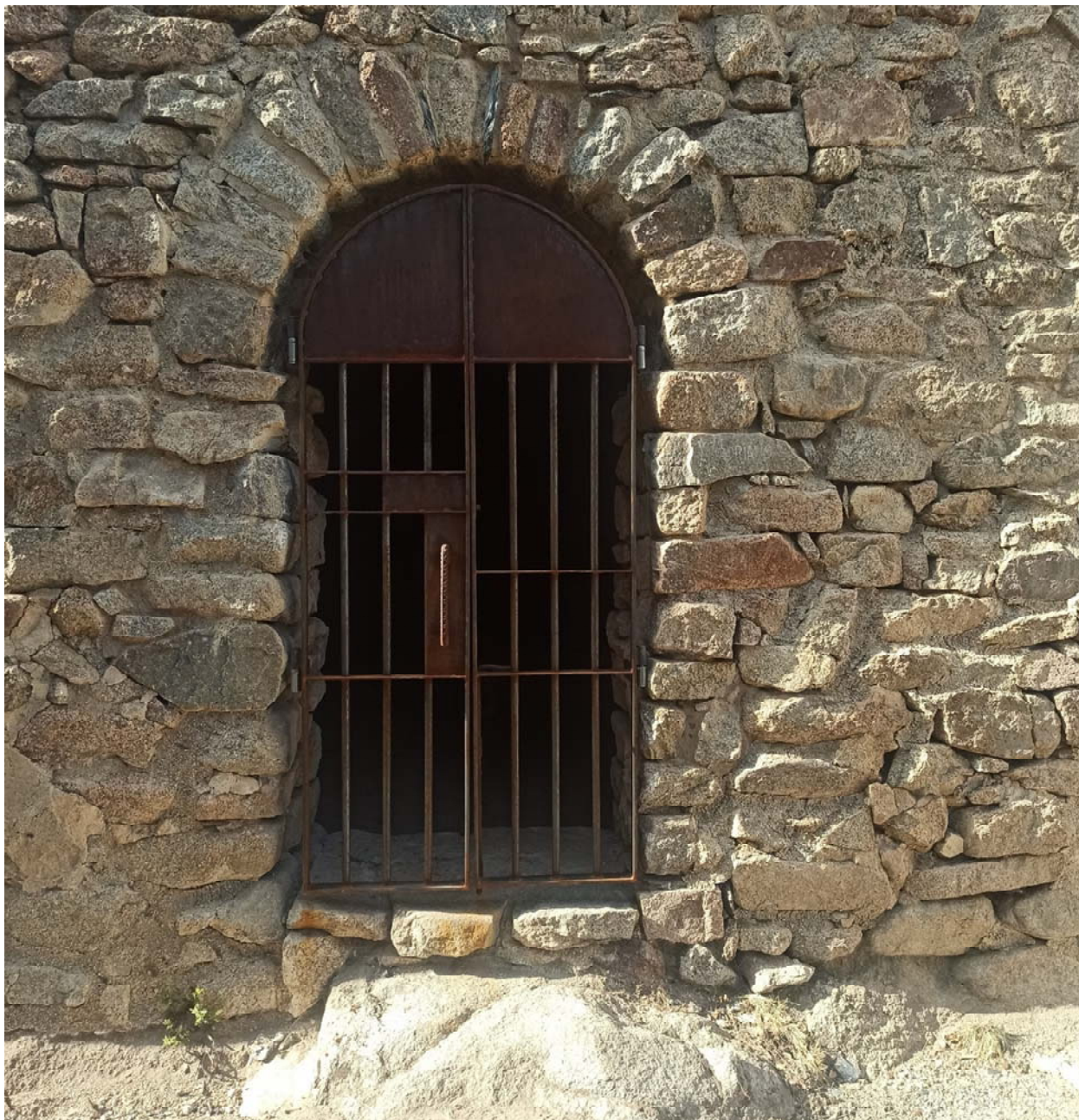
Fotografia 11. Aspecte de la nova reixa instal·lada en la porta d'accés a l'església
