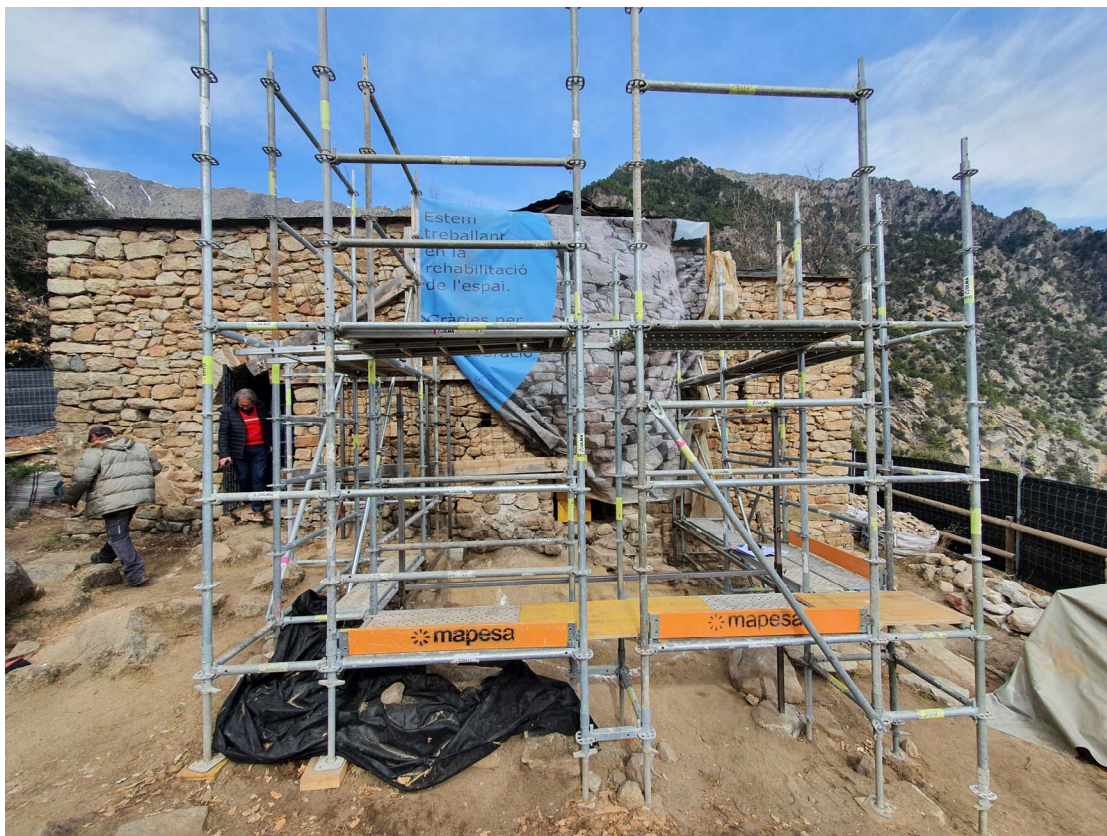
Fotografia 6. Imatge de l'àmbit del campanar amb la bastida i el sistema de referències ja instal·lat
