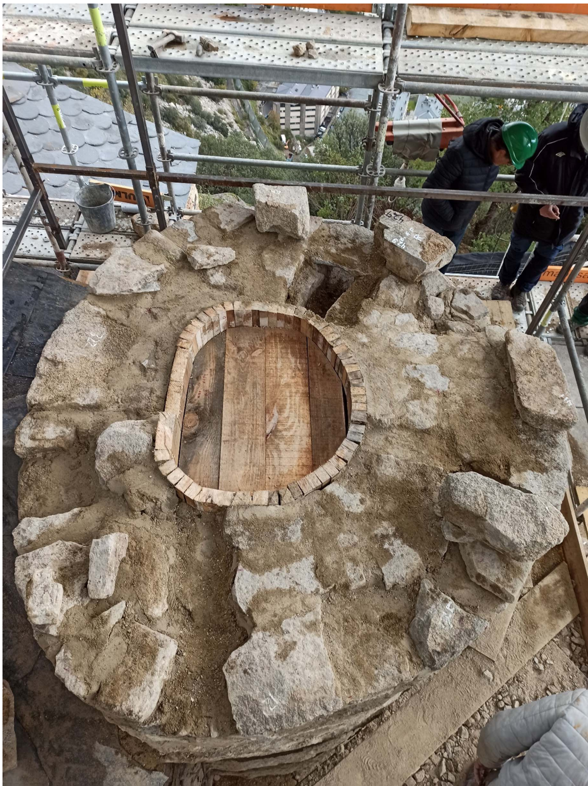
Fotografia 36. Nivell del campanar reconstruït corresponent a la base de les finestres superiors
