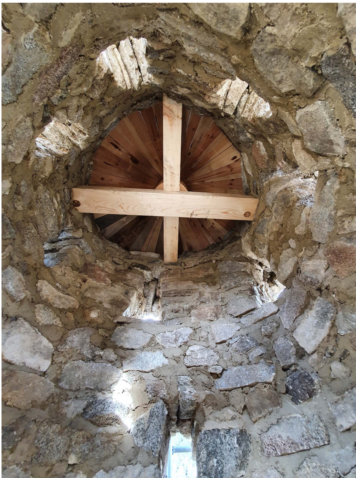
Fotografia 43. Detall interior de la par de les obertures i estructura de coberta de la part alta del campanar
