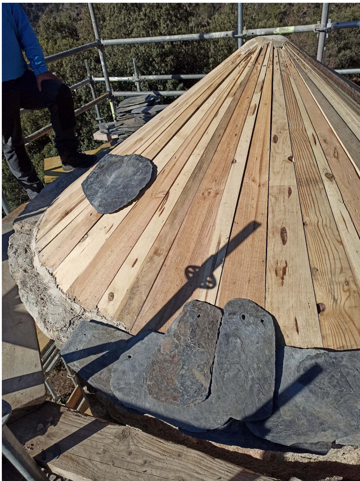
Fotografia 45. Detall de l'empostissat de coberta amb el replanteig previ per a la recol·locació de les lloses
