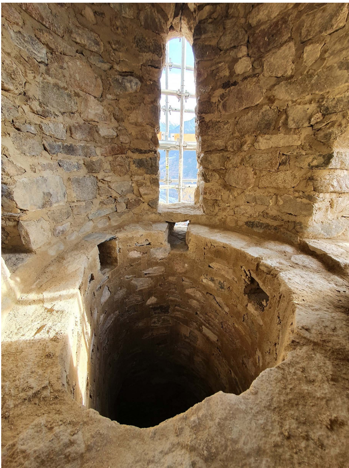
Fotografia 50. Aspecte de l'interior del campanar a l'alçada de les finestres del que hauria estat el cos de campanes
