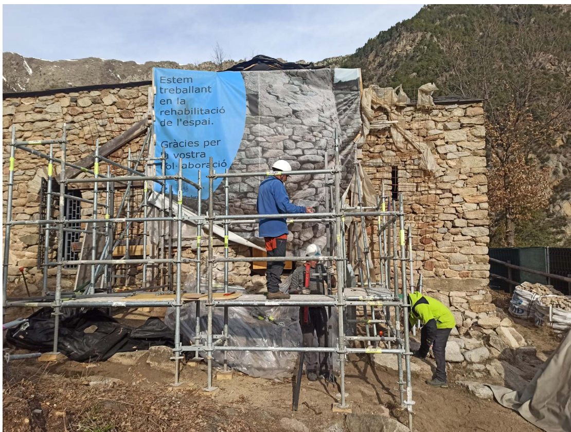
Fotografia 3. Muntatge de la bastida a l'entorn de les restes de la base del campanar conservades
