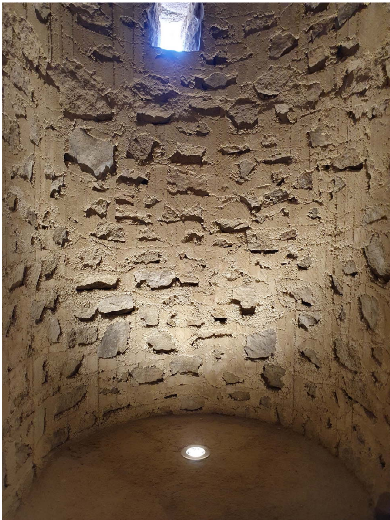
Fotografia 19. Detall de la textura donada al mur interior del campanar per diferenciar-la de la fàbrica històrica original
