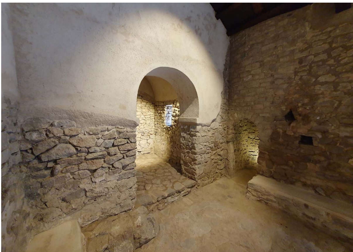
Fotografia 15. Detall de l'arc triomfal del presbiteri i, a la dreta, porta d'accés reconstruïda a l'interior del campanar
