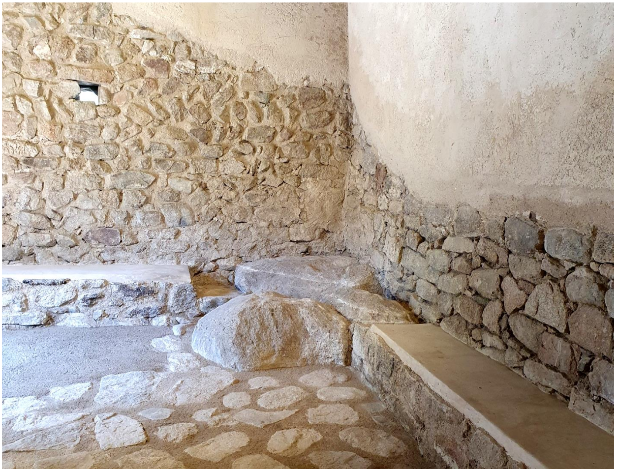
Fig. 10 - Imatge que mostra l'aspecte final de la reconstrucció dels bancs, així com dels acabats dels paraments verticals i el terra, a l'interior de l'església.
