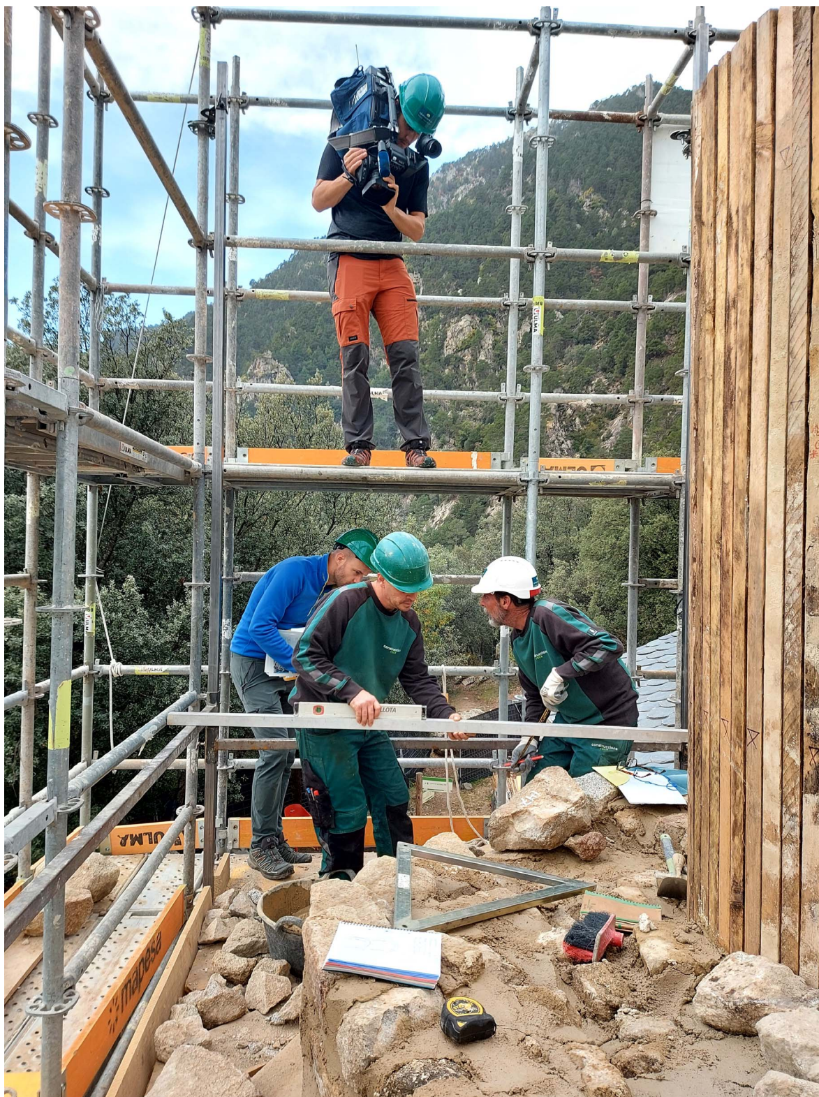
Fotografia 31. Treballs de recol·locació referenciada de pedres, documentada gràficament per un reporter
