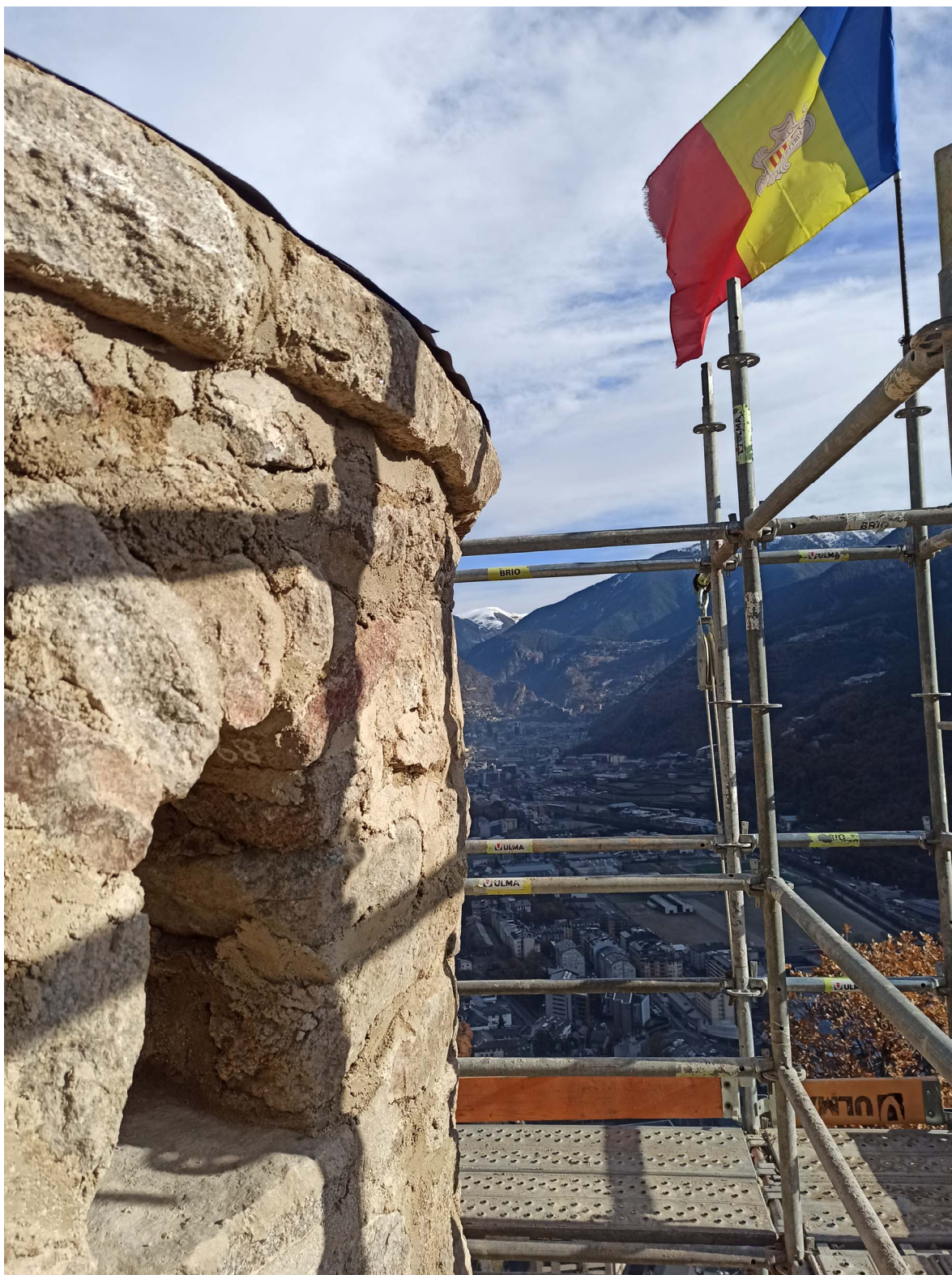
Fotografia 42. Detall de la cornisa incorporada en la reconstrucció que reproduïx la que tenia l'edifici original
