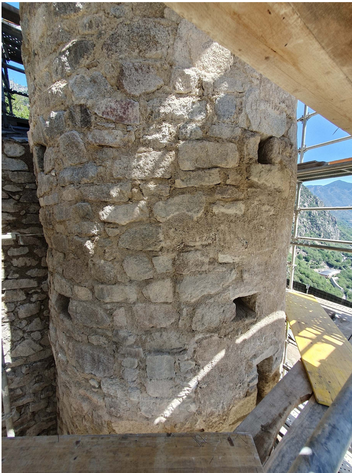
Fotografia 54. Proves de restitució de la base (primera capa) del revestiment parcial de morter de calç del campanar
