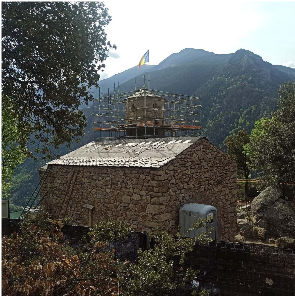
Fotografia 64. Imatge, del nou cobriment de la coberta, amb lloses rústiques irregulars, en fase d'execució
