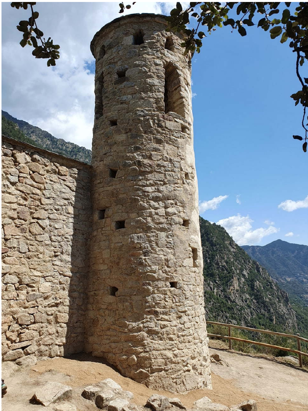
Fotografia 3. Detall de la cara de ponent del campanar reconstruït
