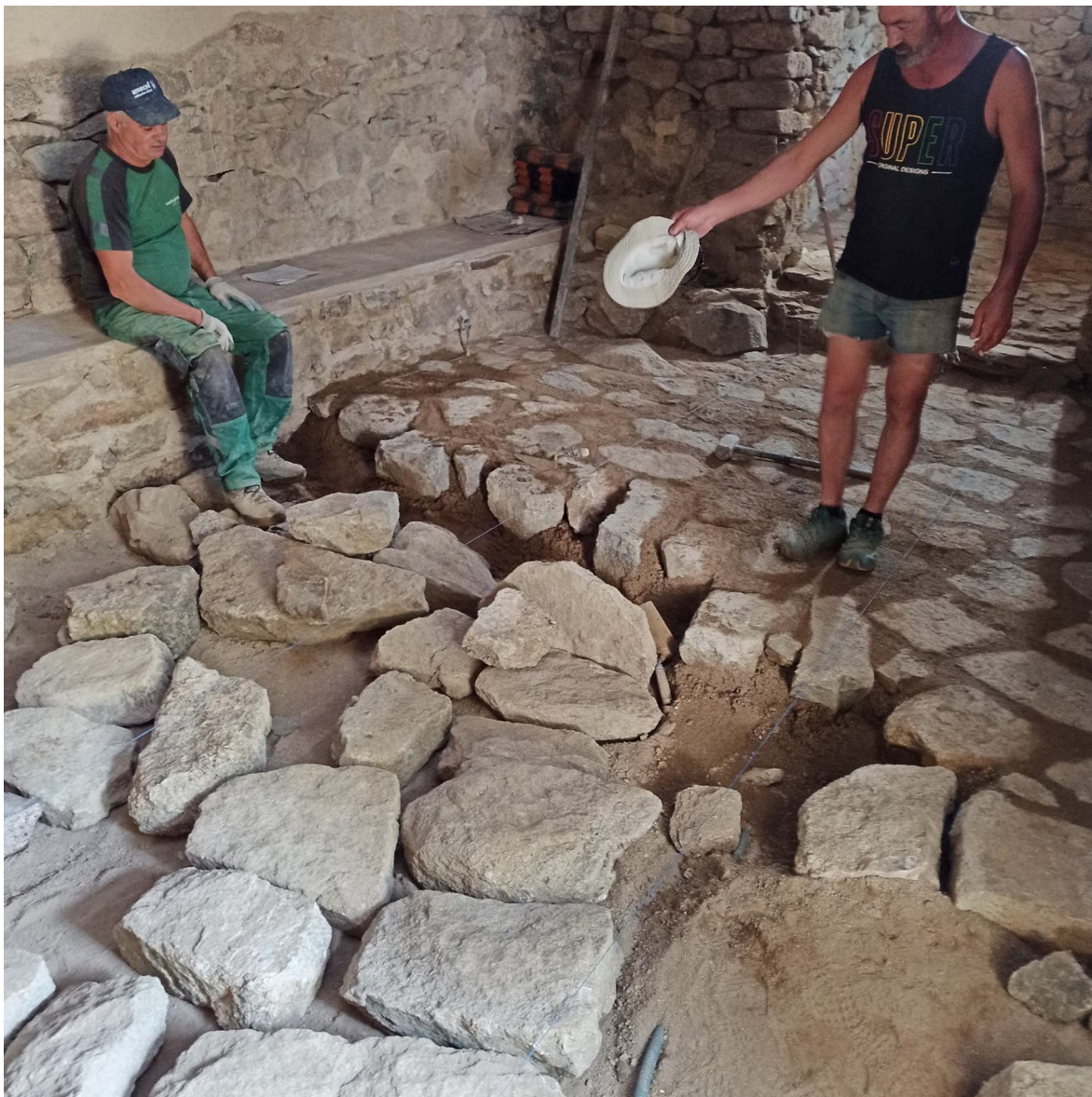
Fotografia 59. Vista dels treballs de recol·locació del paviment de la nau de l'església
