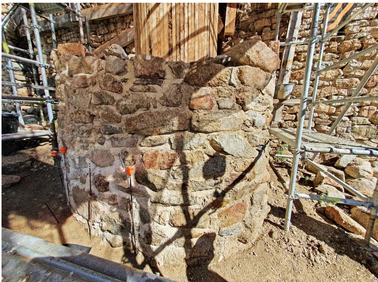
Fig. 6 - Imatge de l'arrencada de la base del nou campanar on s'aprecien els junts lleugerament refosos respecte al pla exterior de la pedra.
