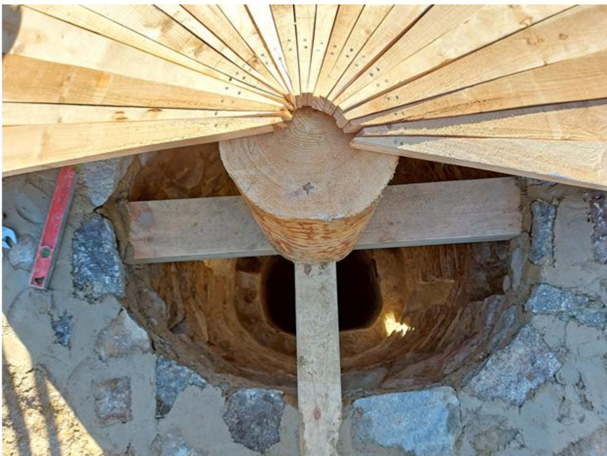
Fig. 7 - Imatge de l'estructura de fusta de la coberta del campanar amb les dues bigues de sola creuades i el peu dret cilíndric sobre el qual hi ha clavades les taules en forma de cuny de la tessela.
