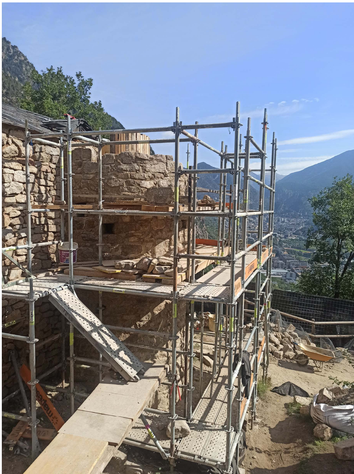
Fotografia 34. Vista del conjunt en aquella fase dels treballs
