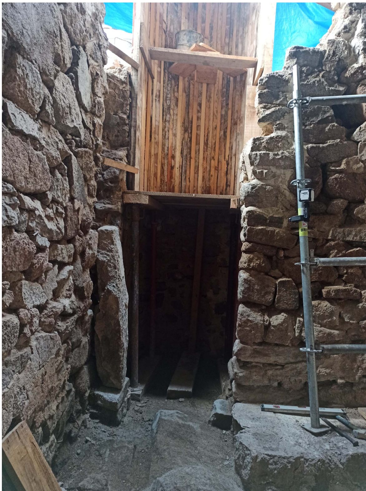
Fotografia 25. Vista des de l'interior de l'església amb els brancals de la porta del campanar conformats de nou
