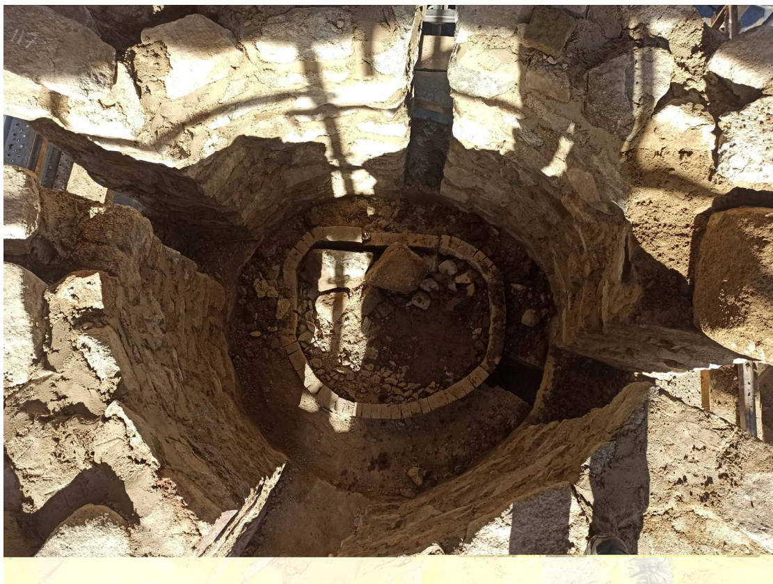
Fotografia 39. Imatge cenital del campanar amb les finestres ja parcialment conformades
