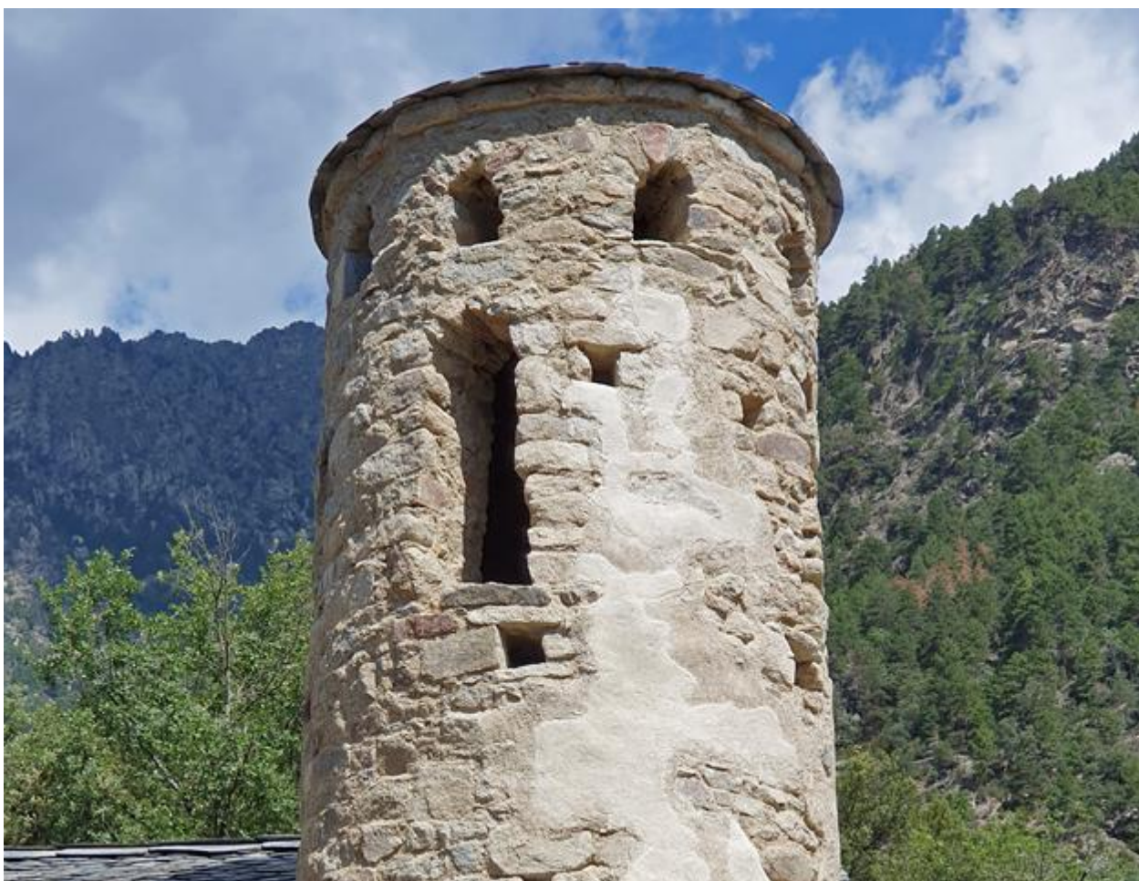
Fig. 8 - Aspecte de la part superior del campanar reconstruït amb l'acabat de les dues capes de revestiment de morter de calç.
