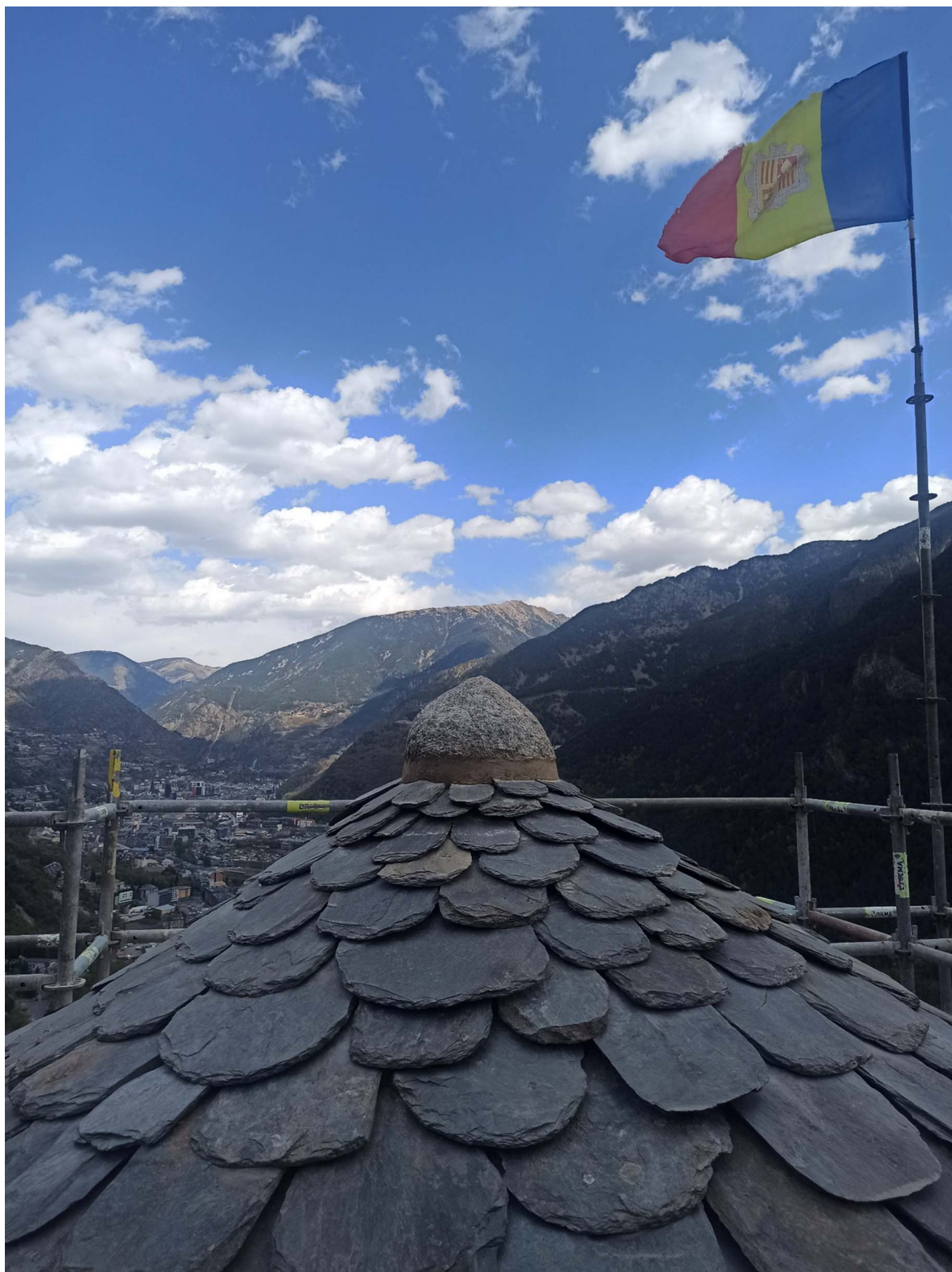
Fotografia 53. Detall del remat superior de la coberta del campanar
