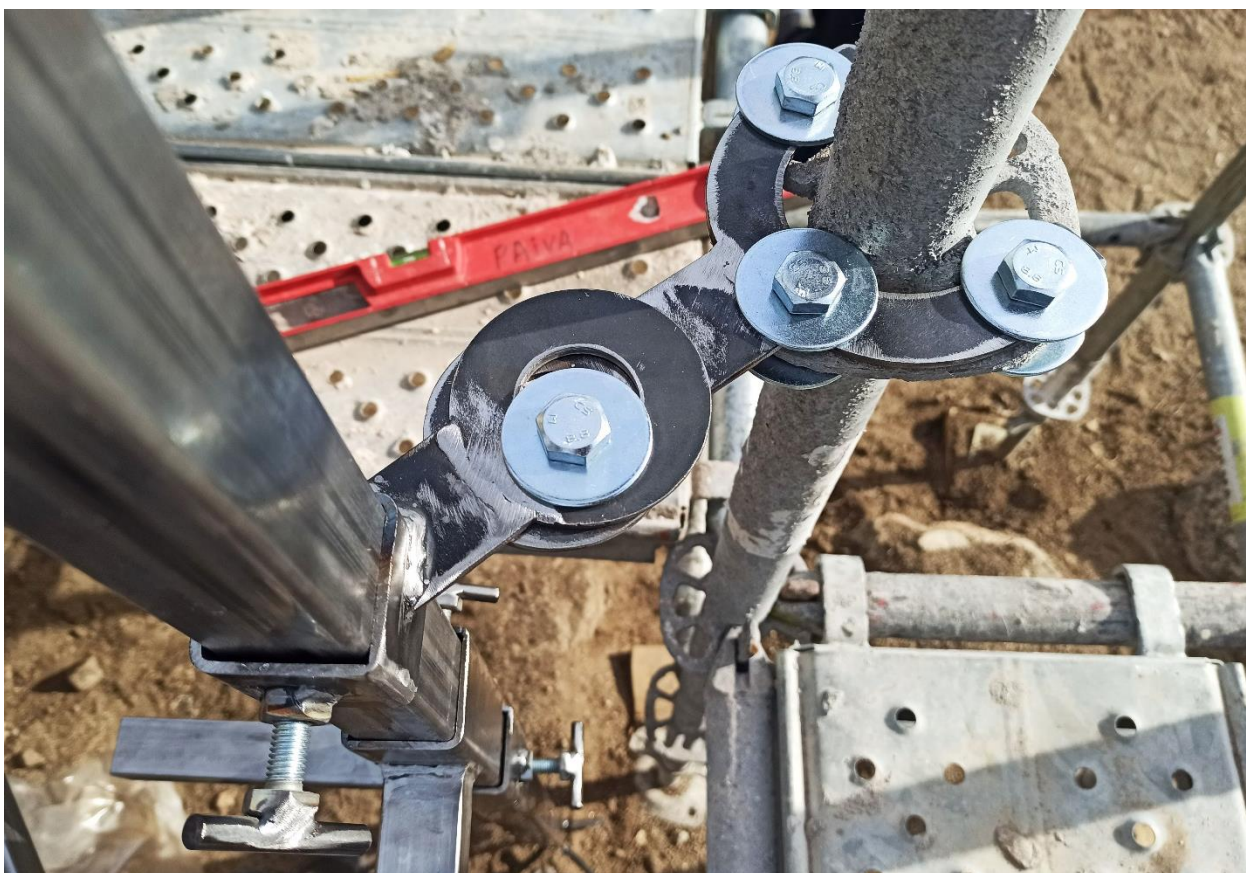
Fig. 1 - Imatge dels colissos de regulació del sistema de referència adossat a la bastida d'obra. A la dreta es pot observar la roseta de la bastida on es fixen; a l'esquerra, un regle guia vertical, i al centre de la part inferior, un regle guia horitzontal.
