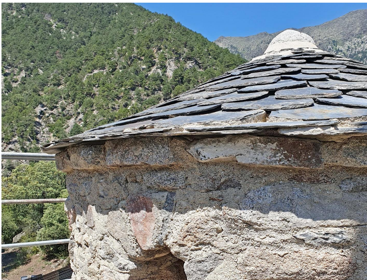
Fig. 4 - Detall de la cornisa recuperada com a coronament superior del mur del campanar després de la seva detecció en fotografies històriques.
