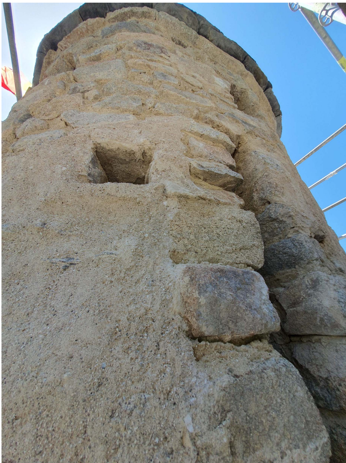
Fotografia 55. Detall d'aquesta primera capa del revestiment aplicada sobre part del mur
