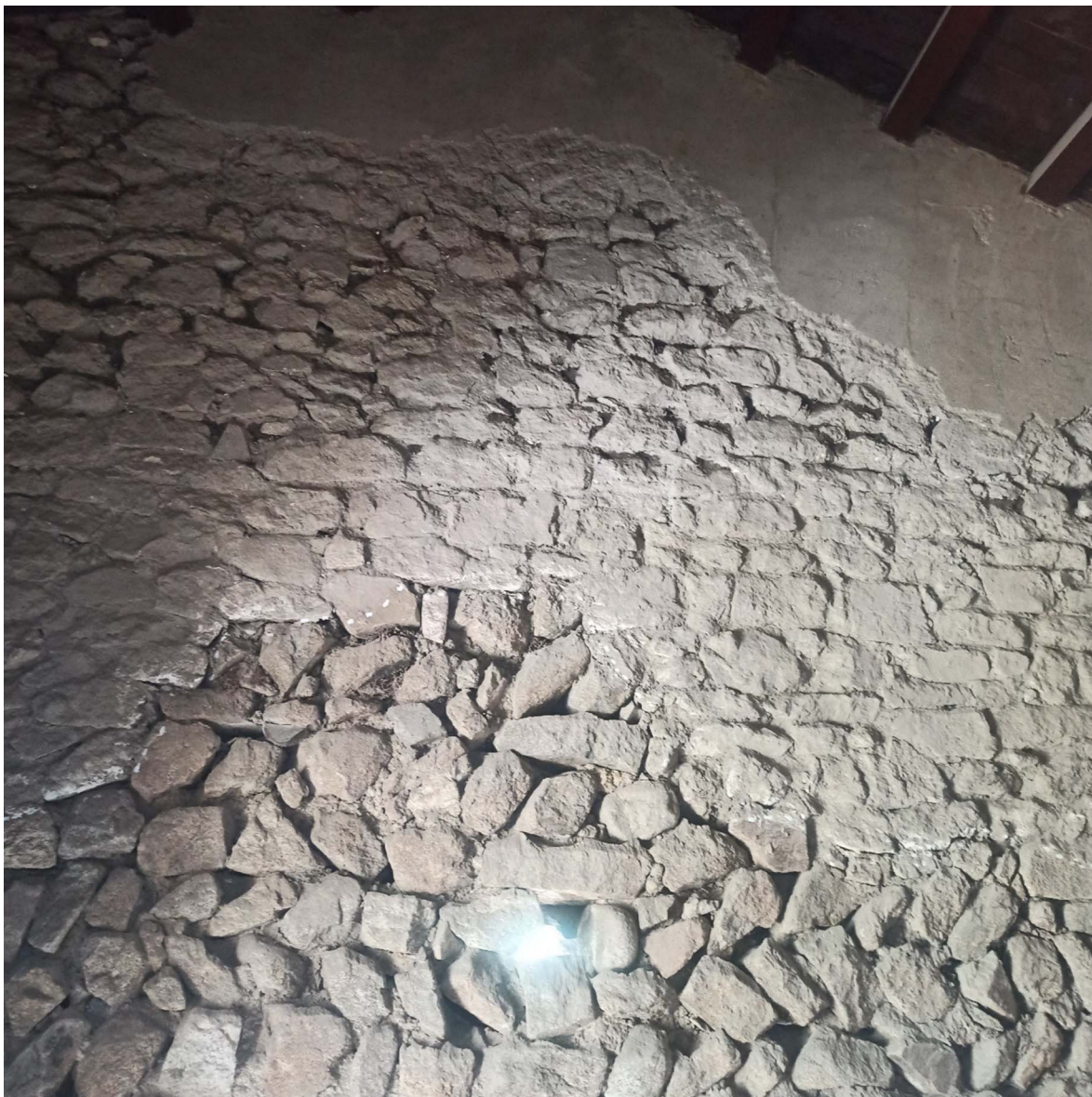
Fotografia 61. Diferencia de la textura entre el parament interior original i el de la reconstrucció dels anys vuitanta, un cop repicat el revestiment de morter degradat existent per a la seva substitució
