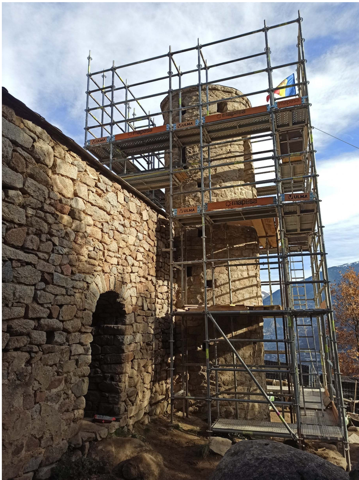
Fotografia 41. Aspecte del campanar reconstruït ja en la seva totalitat
