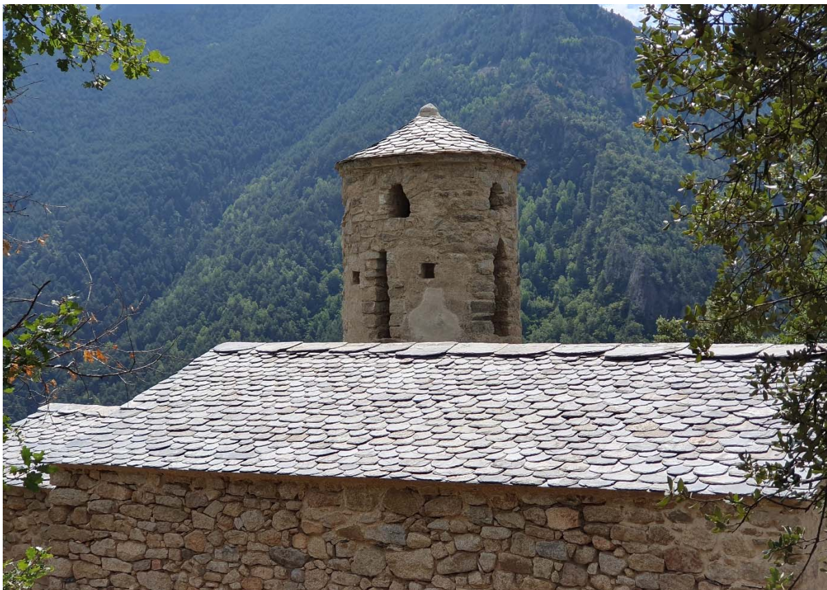
Fotografia 9. Detall de la cara posterior de la nova coberta de lloses irregulars de l'església
