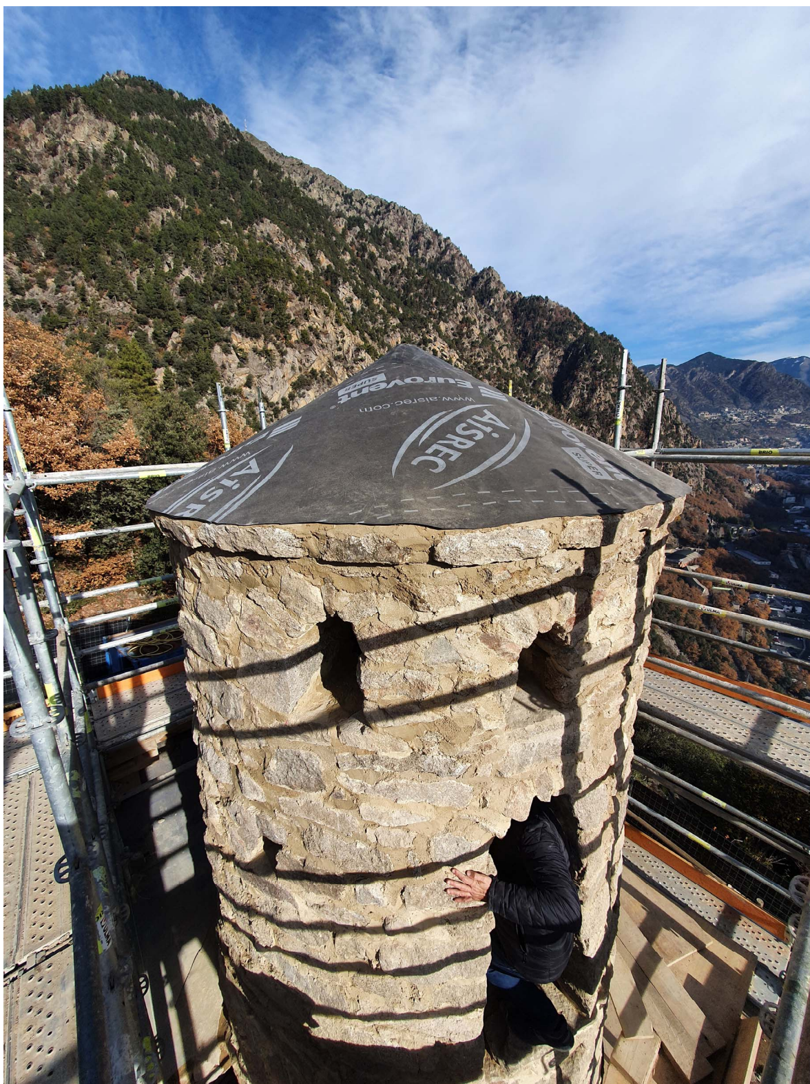
Fotografia 46. Protecció de l'empostissat de la coberta del campanar amb làmina impermeable transpirable
