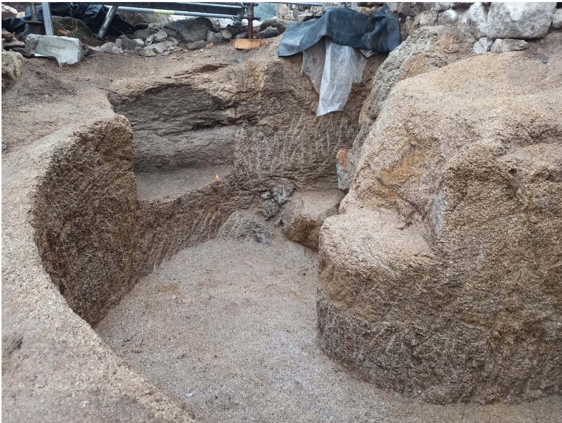
Fotografia 13. Vista parcial d'una fase avançada de l'excavació de la nova fonamentació
