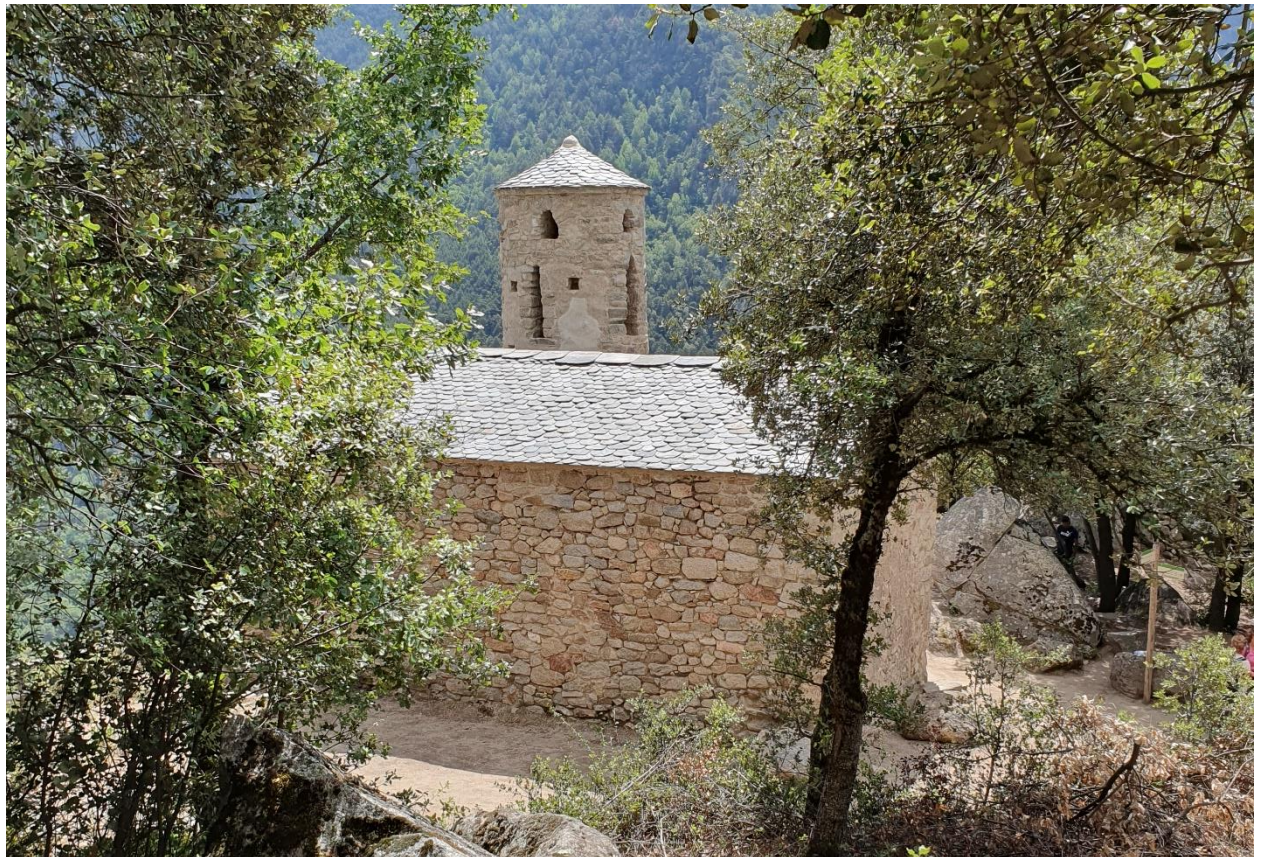
Fig. 18 - Aspecte de l'església, amb el seu cobriment substituït, i del campanar reconstruït des de la seva part posterior.
