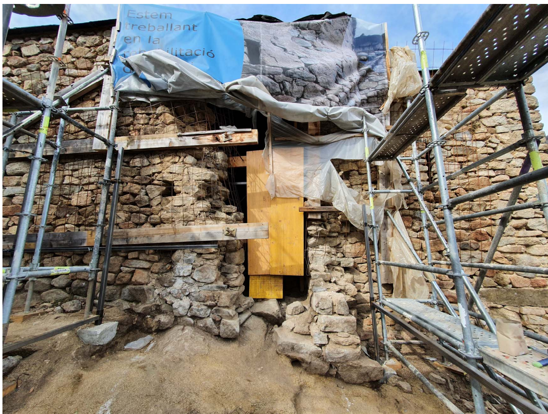
Fotografia 4. Vista del mateix àmbit un cop desmuntades les restes de la base del campanar
