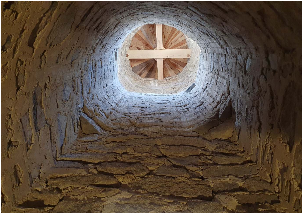
Fotografia 21. Imatge nadiral de l'interior del campanar reconstruït
