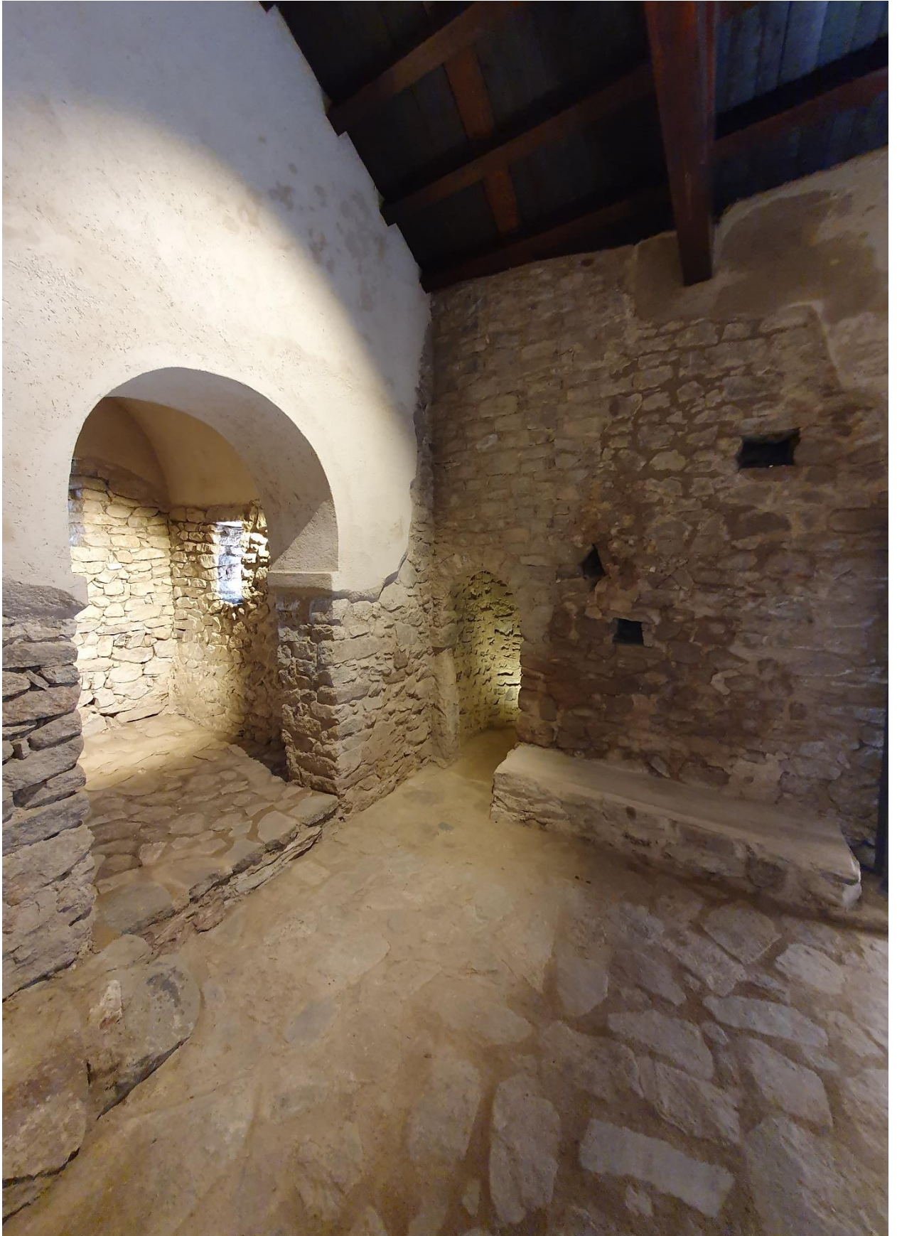
Fig. 19 - Imatge de l'interior de l'església amb l'adequació finalitzada. Es pot apreciar la reparació feta de la part afectada per l'ensorrament del campanar, la restitució dels paviments i dels bancs perimetrals, així com la subtil il·luminació ambiental instal·lada.
