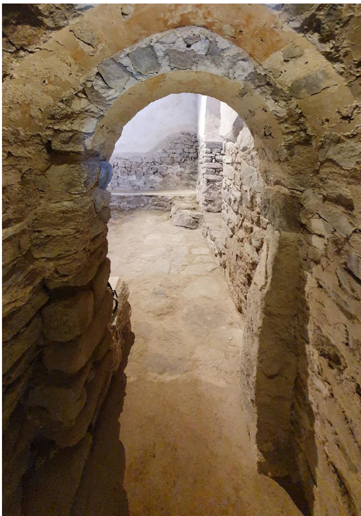
Fig. 9 - Detall de la porta d'accés al campanar i el seu capialt, vist des de l'interior de la torre. A la dreta s'observa el brancal monolític original recuperat localitzat durant les tasques de desenrunament.
