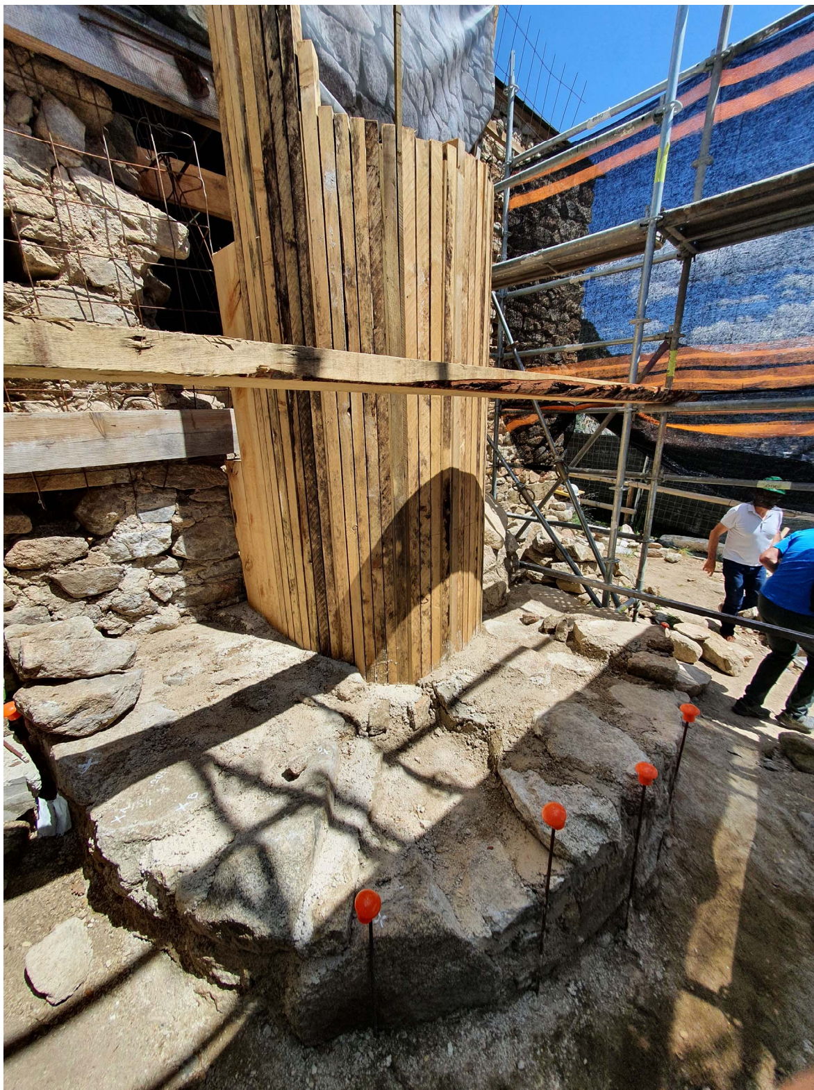
Fotografia 18. Detall de la mateixa fase dels treballs
