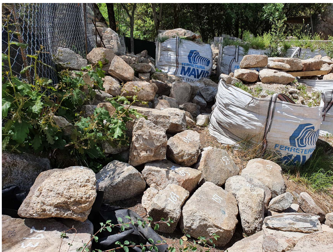
Fotografia 20. Aspecte de l'aplegament de pedres identificades i numerades, classificades per a la seva posterior col·locació
