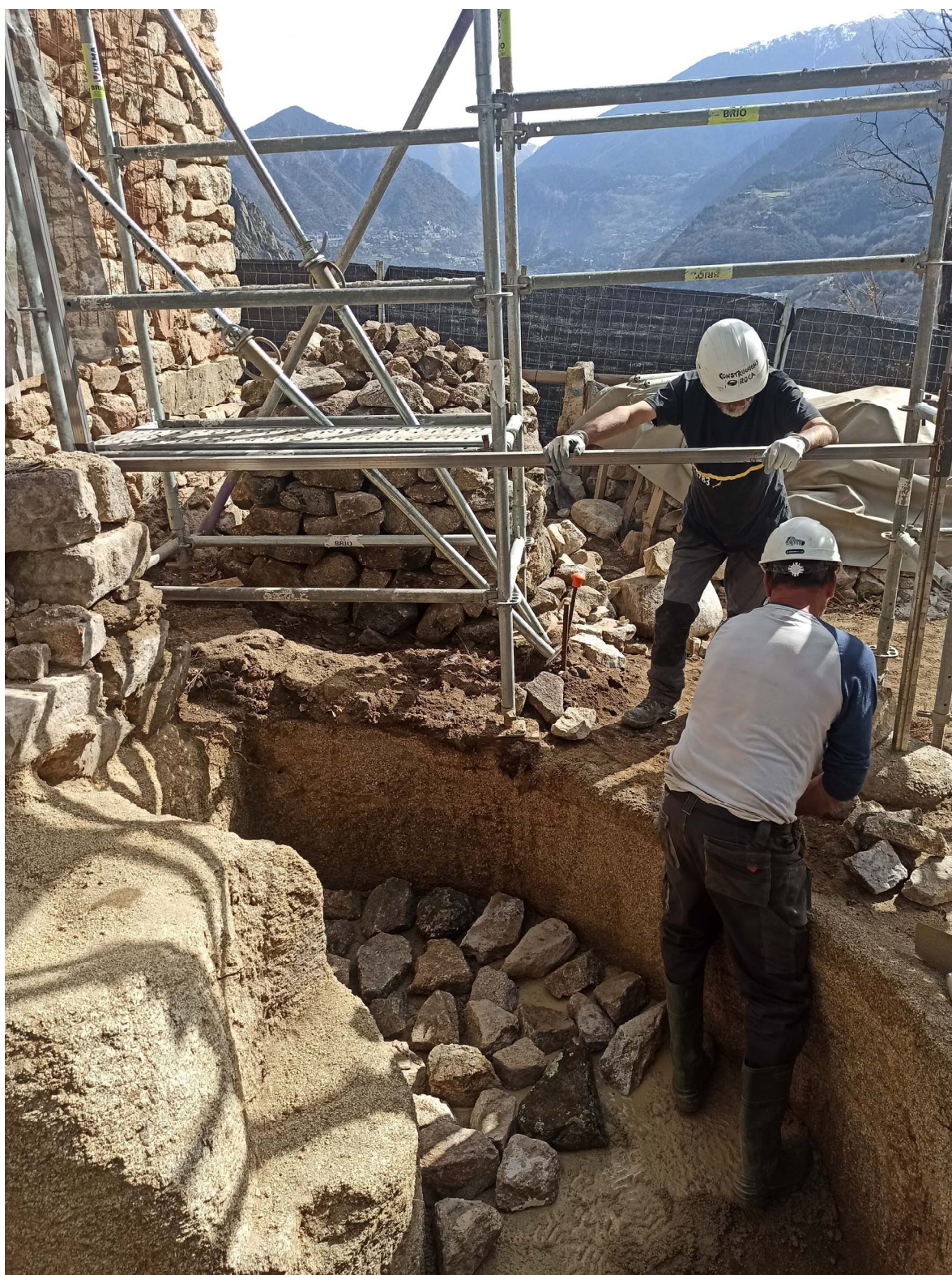
Fotografia 15. Inici de la execució de la nova fonamentació amb fàbrica de maçoneria de pedra i morter de calç
