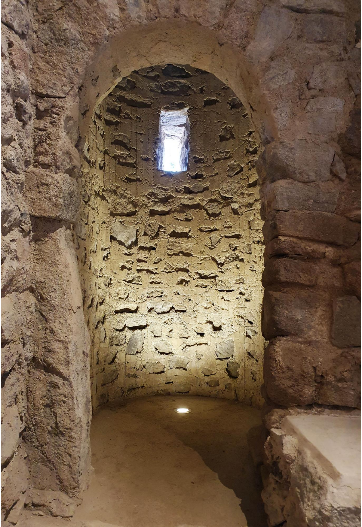
Fig. 21 - Vista de l'interior del campanar a través de la porta reconstruïda. La textura donada al parament, diferent de l'original, vol deixar constància de l'ensorrament i la reconstrucció del campanar, per tal de permetre'n una lectura que eviti que pugui ser entès com un fals històric.
