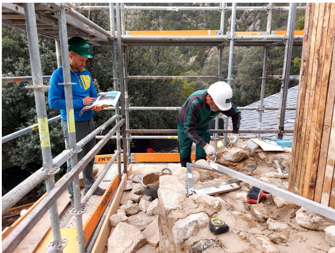
Fotografia 29. Treballs de reconstrucció del campanar superada ja l'alçada de la coberta de l'església
