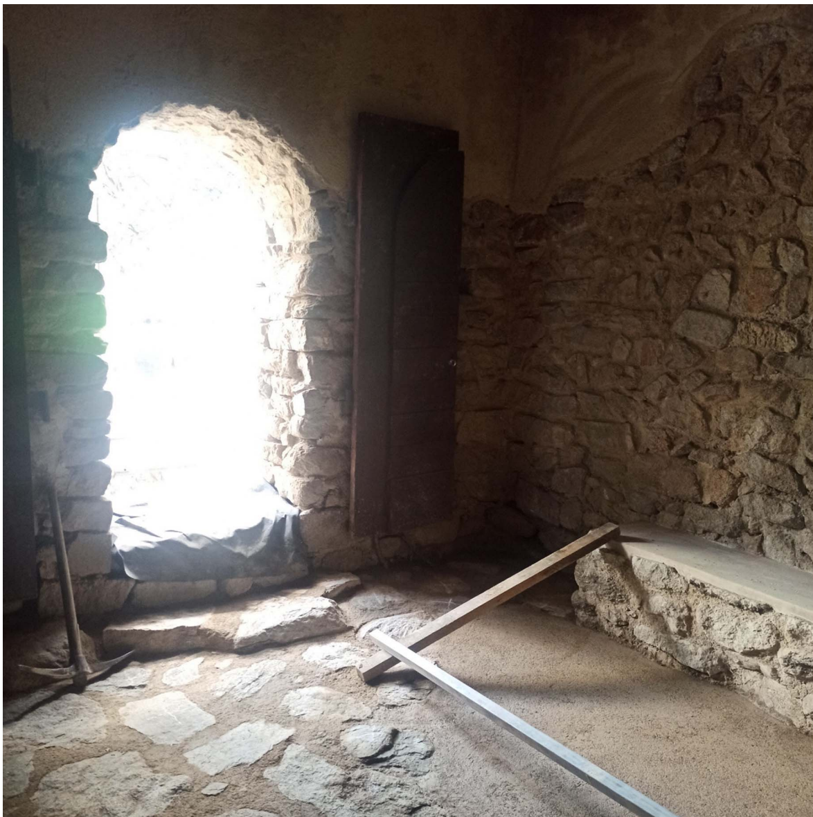
Fotografia 60. Imatge que mostra l'acabat de les llacunes del paviment amb una simple solera de formigó de calç
