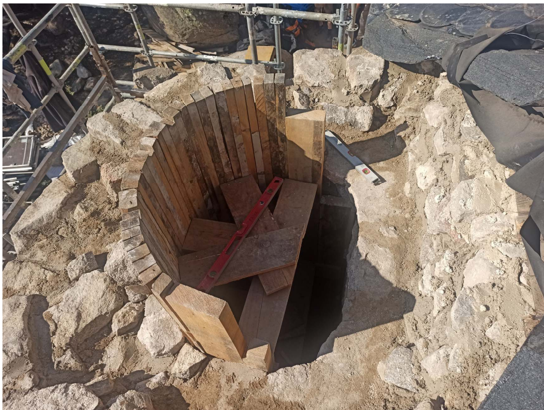
Fotografia 32. Aspecte del campanar reconstruït fins a una alçada propera a la de les finestres superiors
