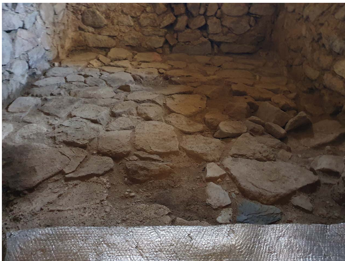
Fotografia 58. Vista de l'estat previ del paviment del presbiteri abans de la seva recol·locació i anivellament
