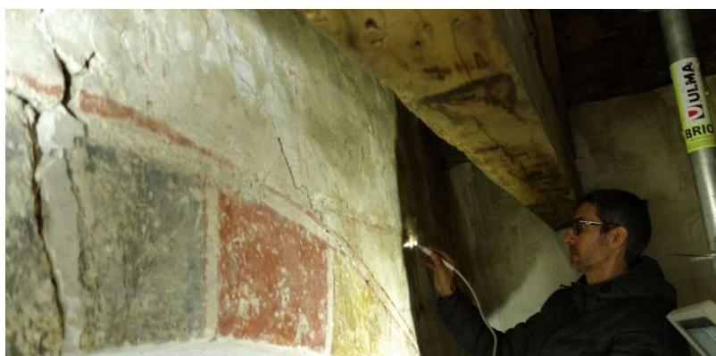
Detall del treball amb el llapis d'ultrasons per enretirar les dos capes superficials de pintura a la calç.
