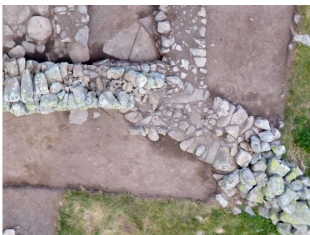
F. 171. Pleta original, ben construïda i adossada a l'angle nord-est.
