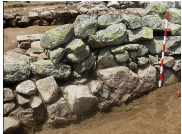
F. 54. Tècnica constructiva: parament exterior façana est.
