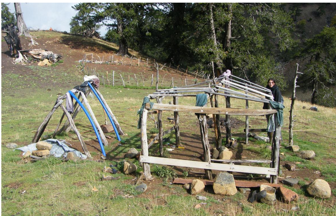
Figura 4.52. Estructures d'hàbitat realitzades en fusta, a la regió de Grevena (Serralada Pindos, Grècia). L'ús de pedres s'observa per a la delimitació de l'estructura (i probablement per subjectar la coberta) i el suport dels pals. Fotografia de l'autor.
