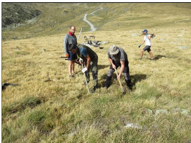
F5. Inici de la intervenció, començant a retirar la capa vegetal.
