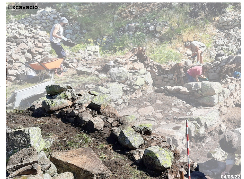
Intervenció de conservació i valorització. Sector de tractament de mineral (MR10)
