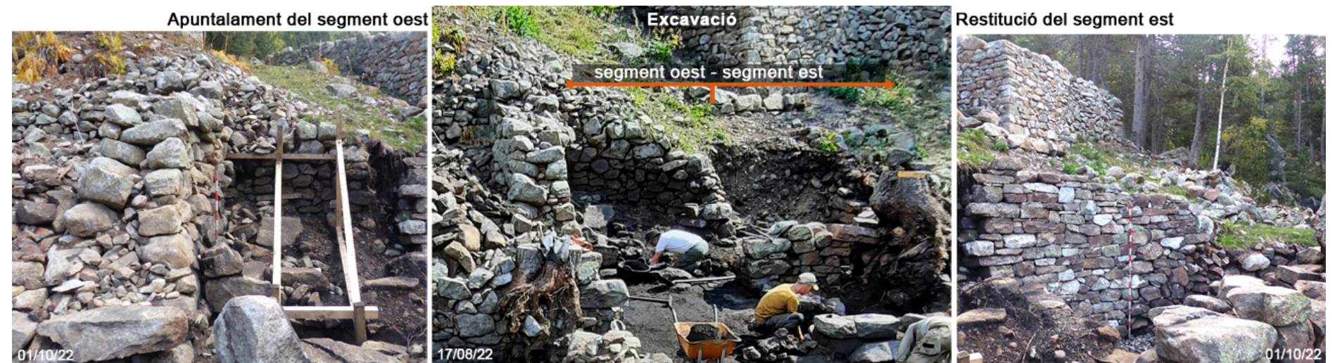
Intervenció d'urgència en el mur nord de la farga (MR08)
