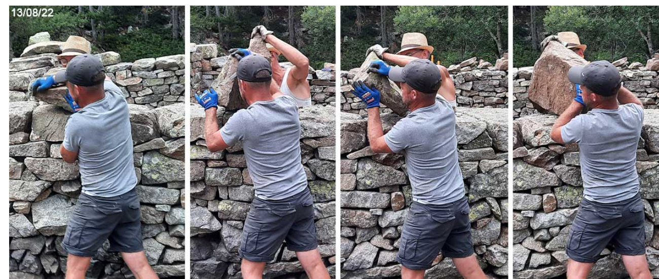
Posicionament d'un bloc de coronament (MR56)
