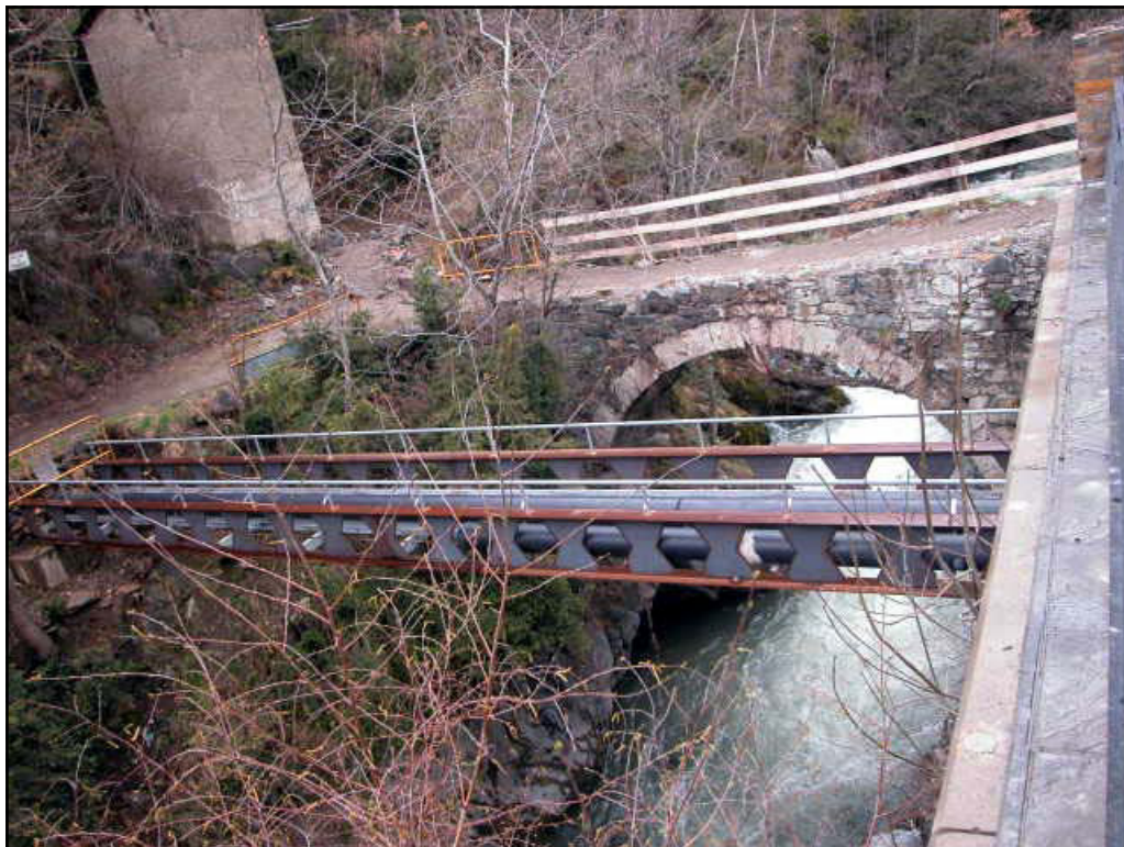
Vista de la situació del Pont Pla en referència a la canalització aèria
