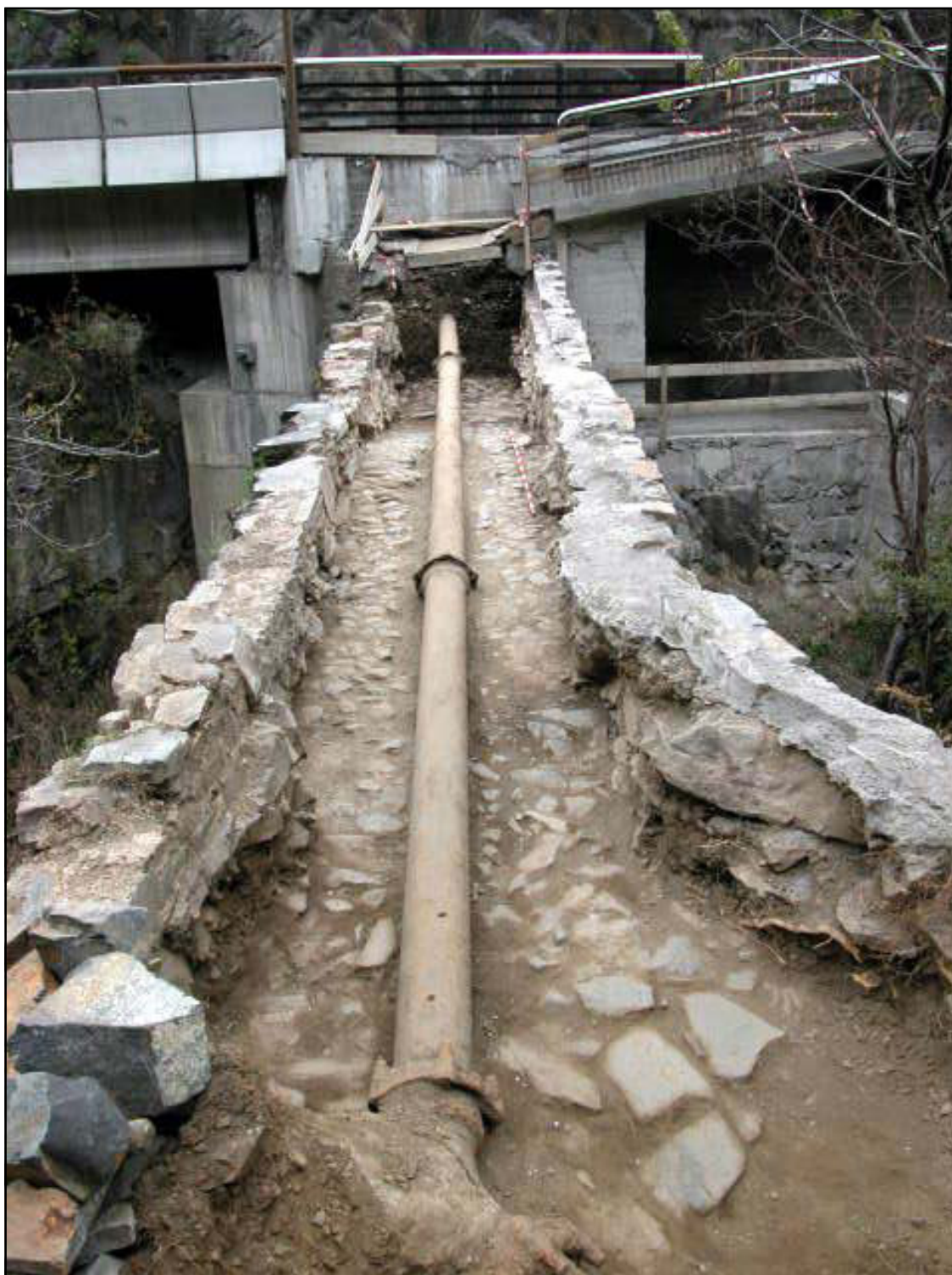
Vista general del pont excavat des del camí ral
