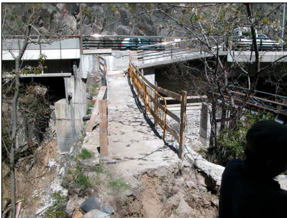
Vista del pont en el moment d'iniciar la intervenció des del camí ral
