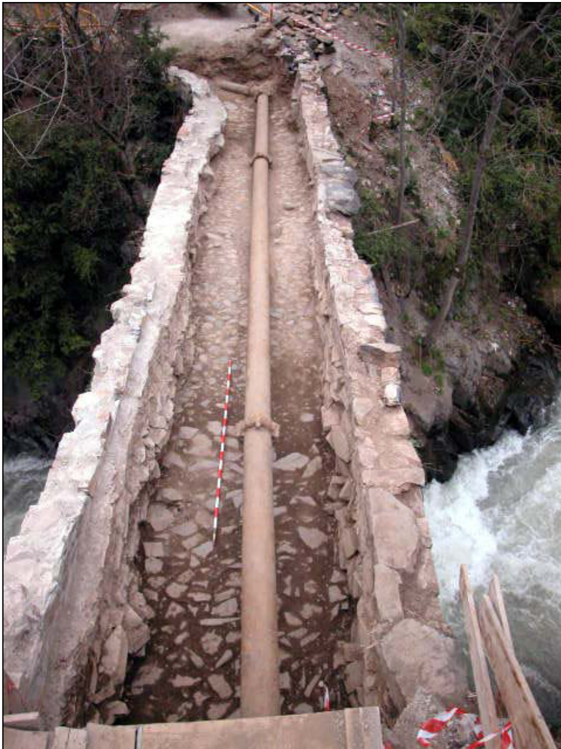
Vista del pont excavat des de la carretera CG.3
