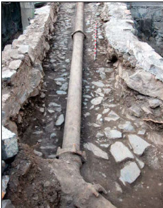
Vista del paviment i de la canalització durant la excavació. S'observa la rasa efectuada al paviment per tal de col·locar el tub
