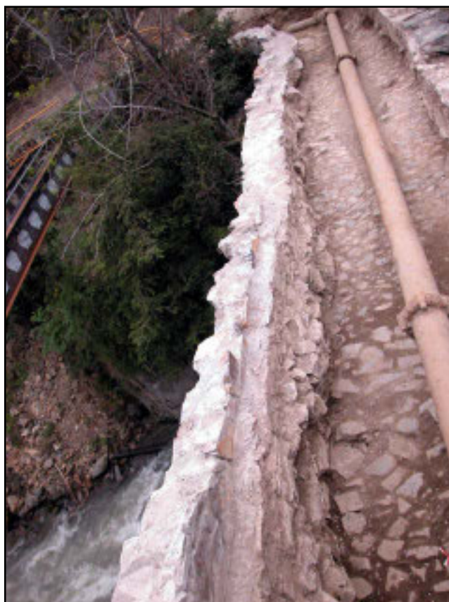
Vista del parament intern de l'ampit UE 8
