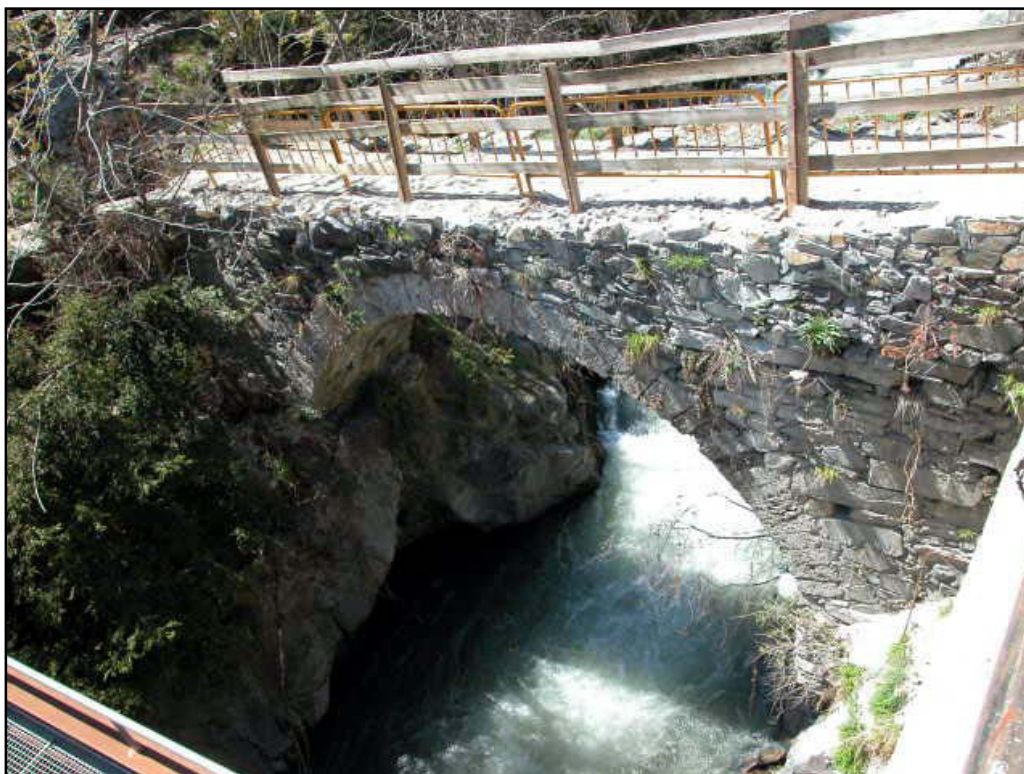
Vista del parament sud del pont. S'observa la diferència entre els ampits amortitzats i la resta de l'estructura
