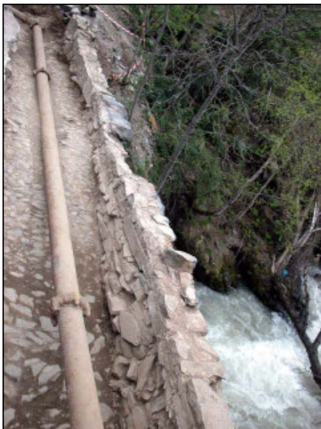
Vista del parament intern de l'ampit UE 7
