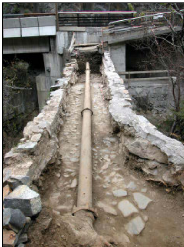
Vistes de la caixa del pont una vegada excavada. Des de la carretera i des del camí ral. A la segona exposició s'observa l'alçada real entre la rampa de baixada al pont i el paviment d'aquest
