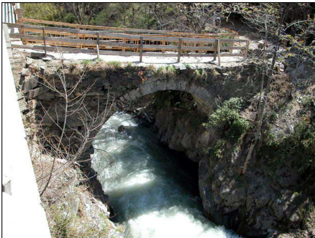
Vista del parament nord del pont. S'observa la diferència entre els ampits amortitzats i la resta de l'estructura
