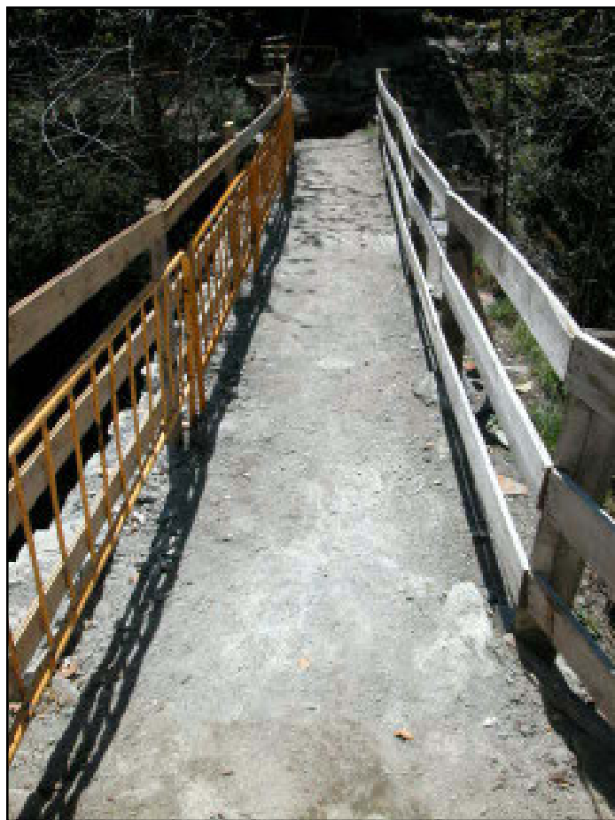
Vista del pont al començar la intervenció, des de la carretera
