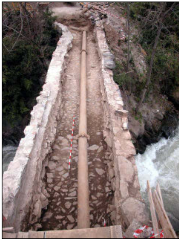
Vistes de la caixa del pont una vegada excavada. Des de la carretera i des del camí ral. A la segona exposició s'observa l'alçada real entre la rampa de baixada al pont i el paviment d'aquest
