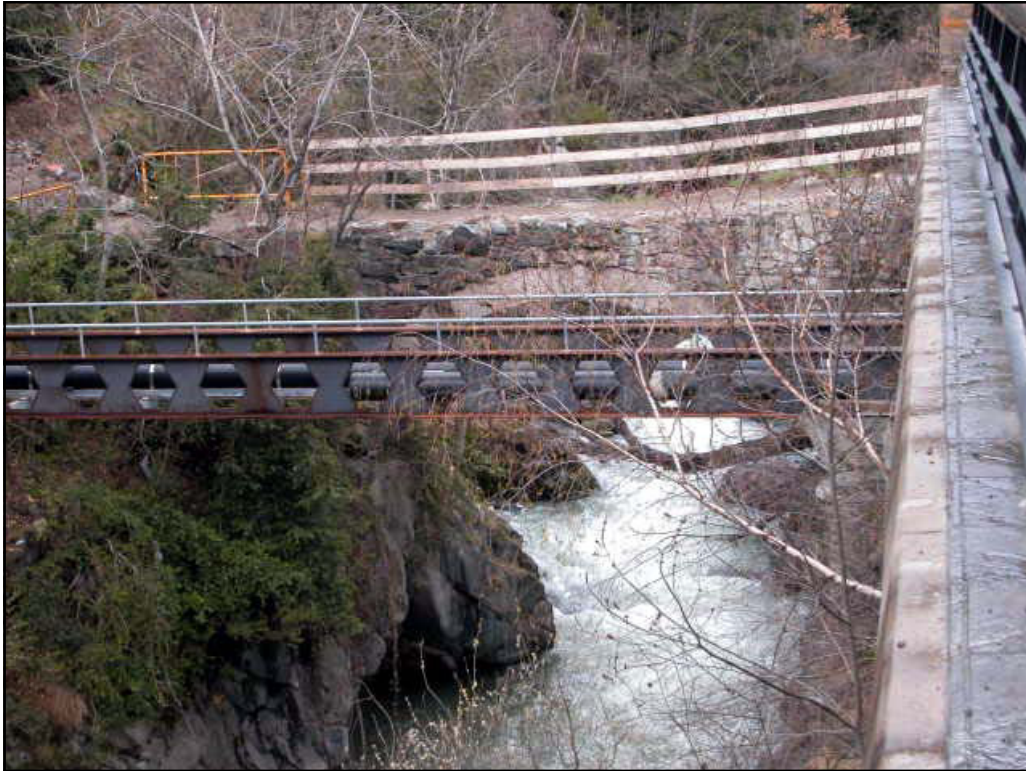
Vista del Pont Pla des de la Carretera General 3. S'observa com la canalització aèria destorba totalment la visualització del monument
