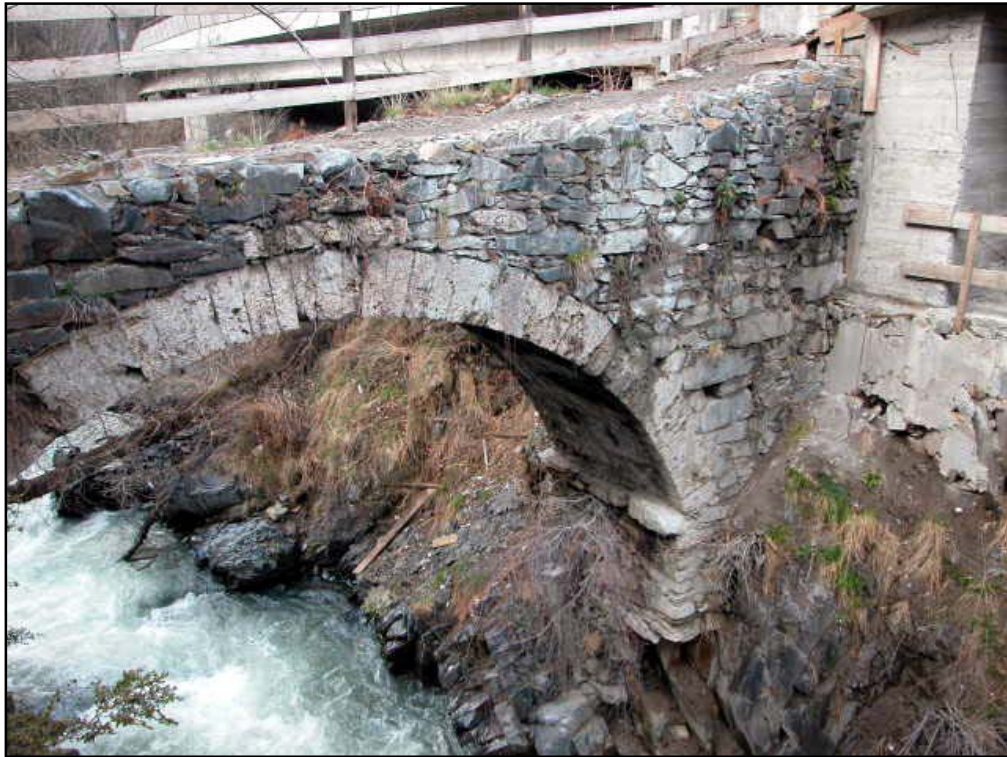
Vista del fonament est des de la banda sud. S'observa com recolza directament sobre la penya
