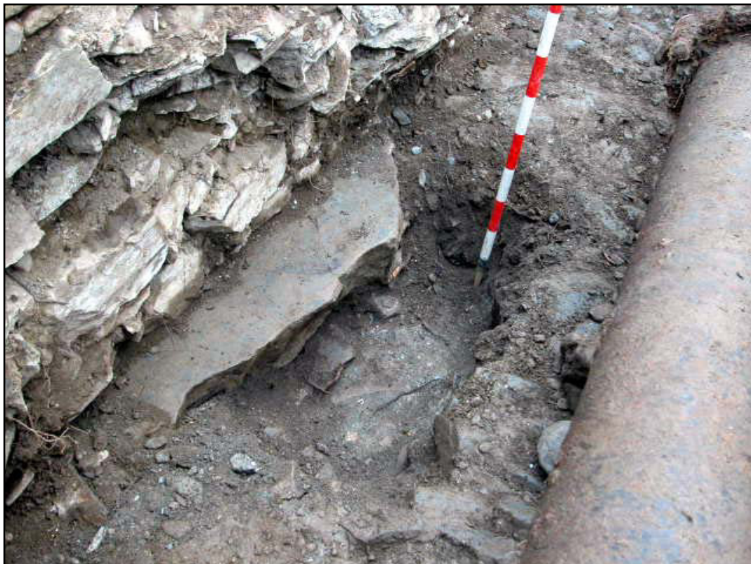
Vista de la cala i dels blocs de pedra que formen l'estructura del pont (UE 11)
