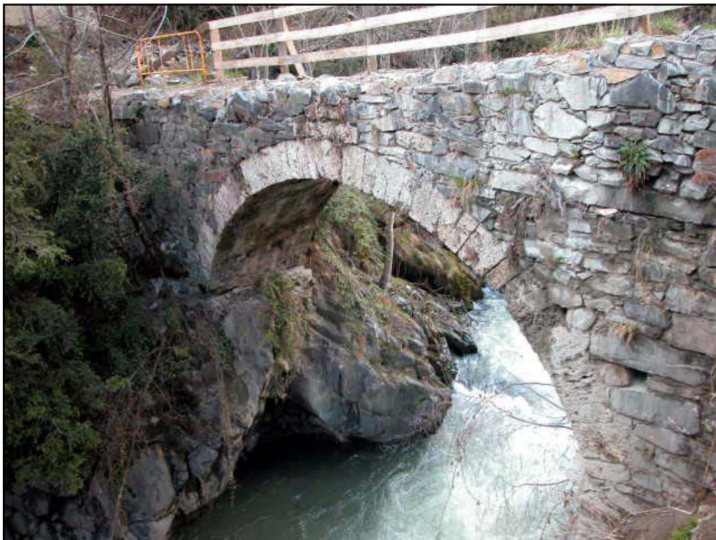
Vista del fonament oest des de la banda sud. S'observa com es recolza directament sobre la penya
