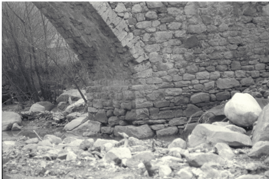
Figura 3. Fotografia on s'observen en detall els treballs de canalització del riu a l'estrep oest del pont de la Margineda.
