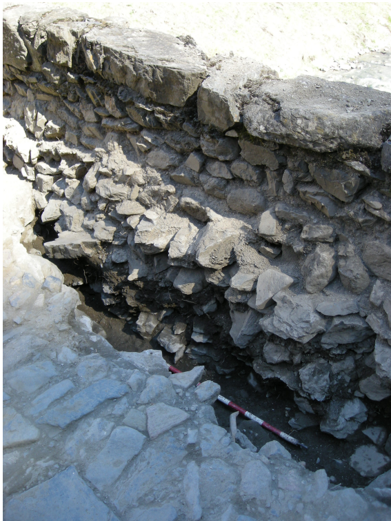
Figura 12. Detall de la fonamentació de la nova barana del pont que destruirà part de l'enllosat original.
