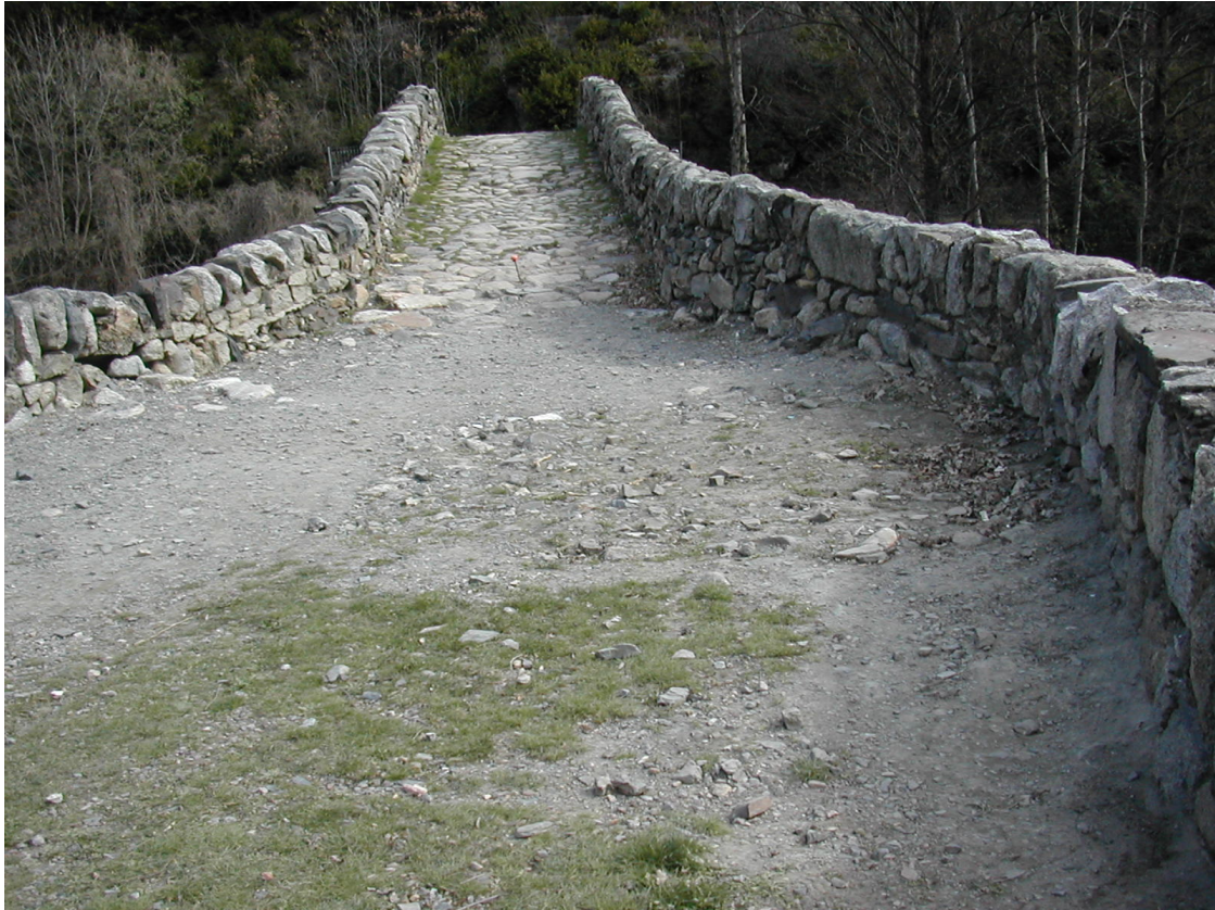
Figura 16. Vista des de l'extrem oest del pont del sector 2 abans dels treballs d'excavació.
