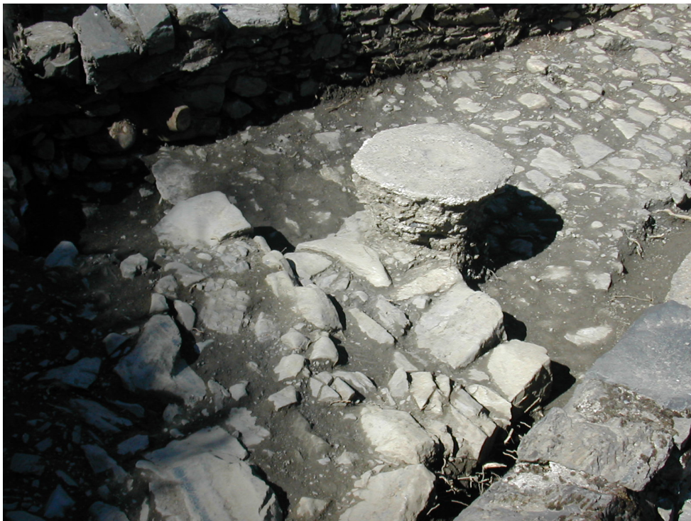
Figura 10. Fotografia detall del paviment PV2 (a baix) per sobre del paviment original.
