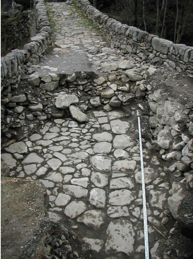
Figura 18. Detall del paviment original del pont documentat al sector 2.
