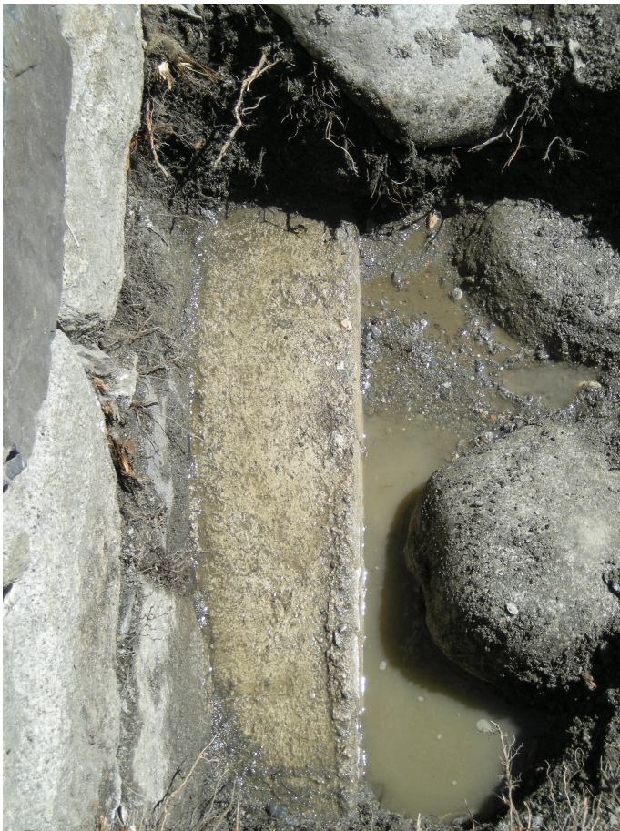
Figura 23. Detall de la safata de morter a l'estrep del pont.
