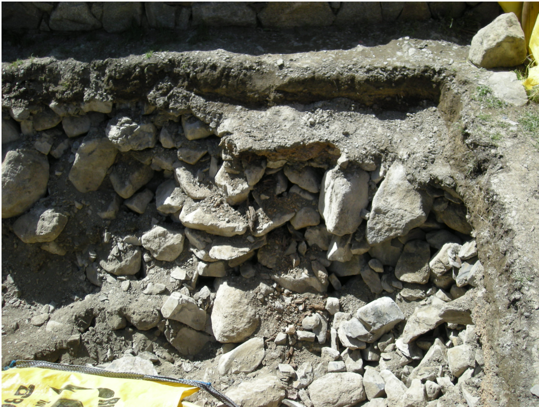
Figura 14. Detall del rebliment de pedres per sota del nivell actual, cobrint el paviment original.
