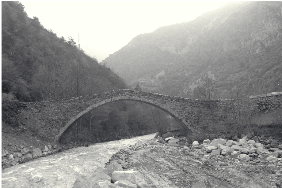
Figura 2. Fotografia on es detallen els treballs de canalització del llit del riu, afectant una bona part del sector nord.
