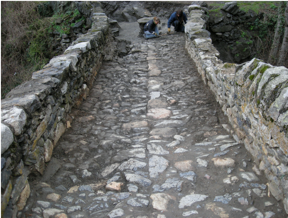
Figura 11. Detall dels treballs de descobriment i neteja del paviment original del pont.
