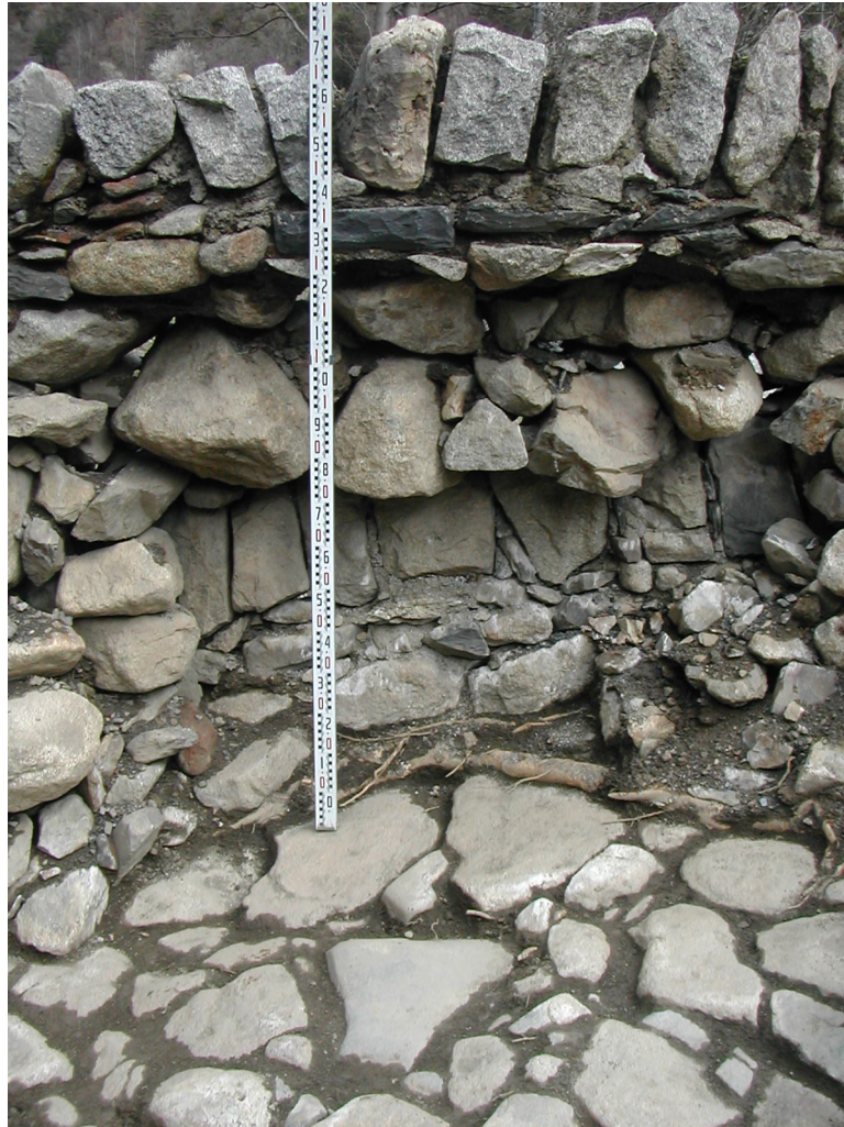
Figura 15. Detall de l'alçat interior corresponent a les diverses fases De la barana nord del pont. A baix, el paviment original.
