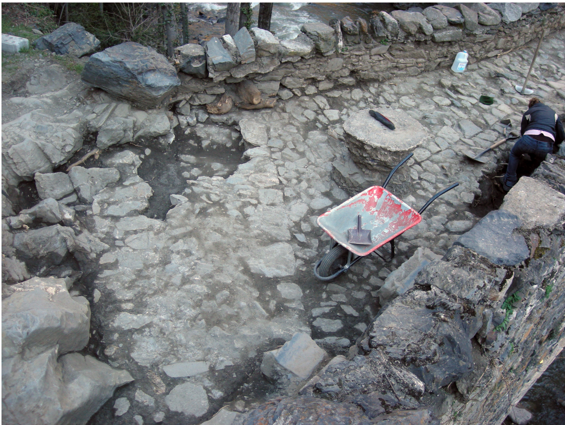
Figura 13. Detall dels treballs de descobriment del paviment original. Al sector central es pot observar el canvi en la disposició i orientació del mateix, marcant a l'esquerra de la imatge el tram associat a la pavimentació del camí de l'obaga.
