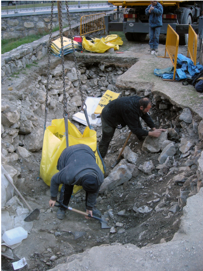
Figura 6. Fotografia on s'observa el mètode d'extracció del rebliment documentat al sector 2 del pont.
