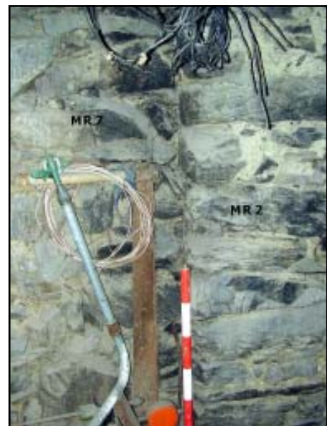
Vista de la cala B1-I. S'aprecia la relació entre MR 7 i MR 2
