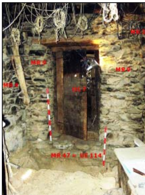
Vista de la cala B4-I. S'observen els fets constructius MR 3, MR 4, OC 7, MR 9 i MR 47
