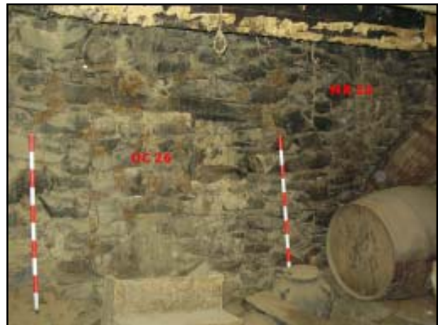
Vista de la cala B7-I. S'observen els fets constructius MR 24 i OC 26
