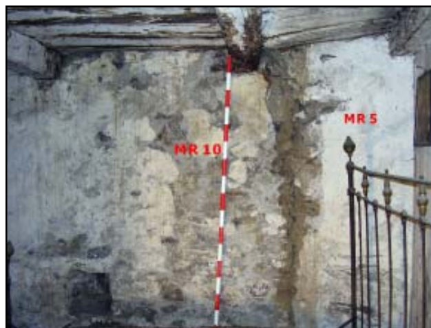
Vista de la cala P3-II. S'observa com MR 10 recolza en MR 5
