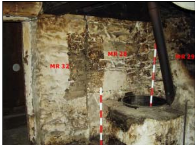
Vista de la cala P1-I. S'observa com els fets constructius MR 29 i MR 32 recolzen en MR 28
