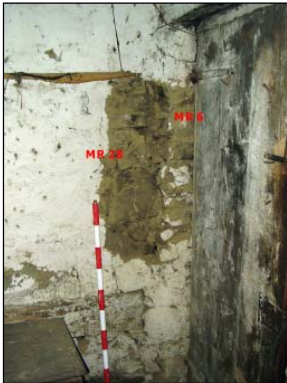
Vista de la cala B7-I- S'observa que els murs MR 6 i MR 28 són solidaris
