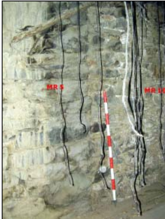
Vista de la cala B5-I. A la part central de la imatge s'observa com MR 10 recolza en MR 5
