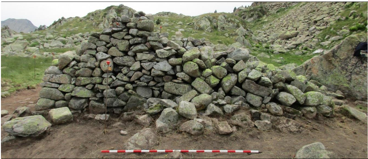
Estat final de la façana nord de l'Edifici 4, mantenint l'enderroc de l'angle i remuntant part de la façana.
