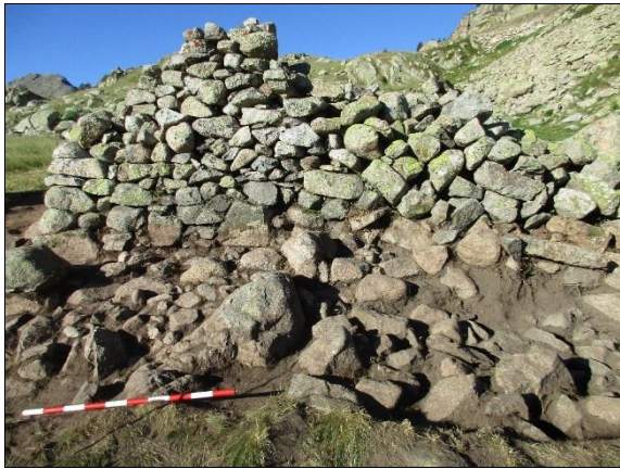
Enderroc de l'edifici a l'exterior nord (UE 23)
