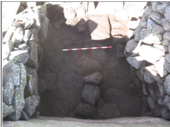
FOT. 43: Edifici 4, interior un cop retirada la UE 15.
