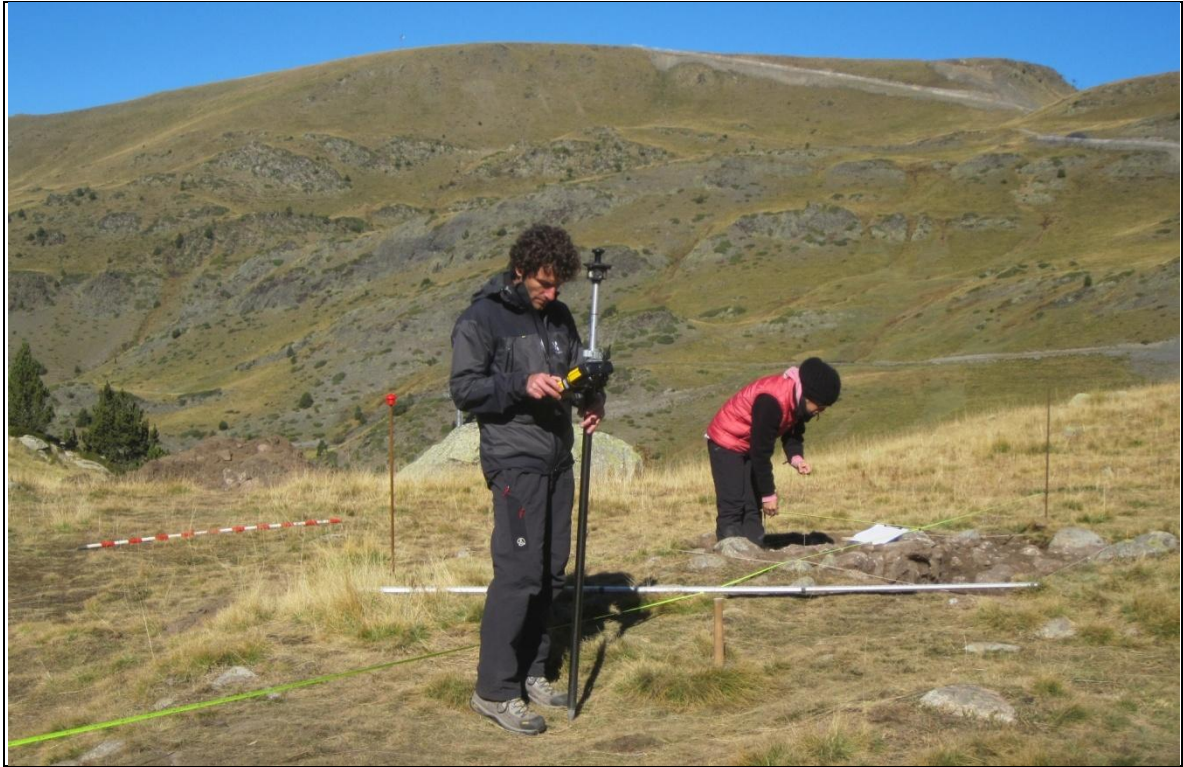
Treballs de documentació planimètrica i d'aixecament topogràfic
