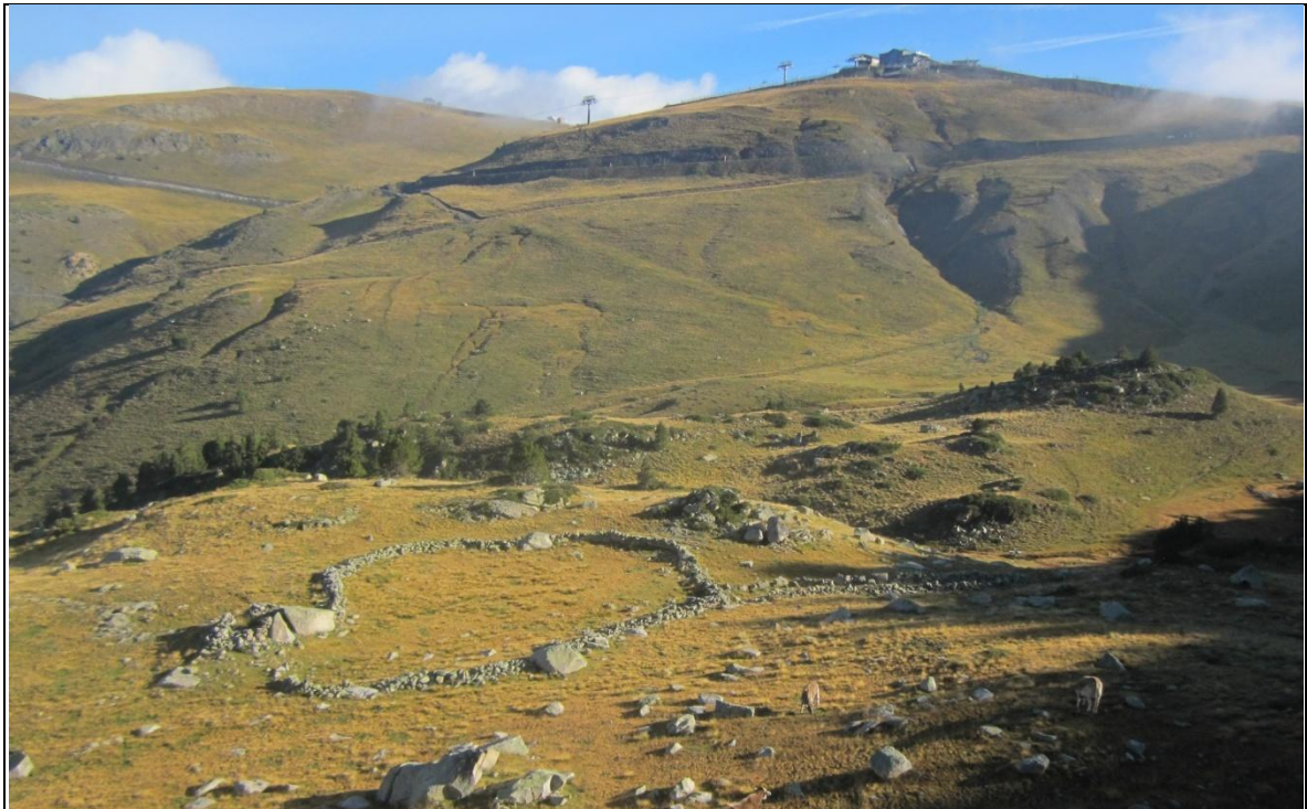
Vista general de l'orri abans d'iniciar la intervenció, des del sud. Al fons a la dreta, Enradort i parada del Funicamp.
