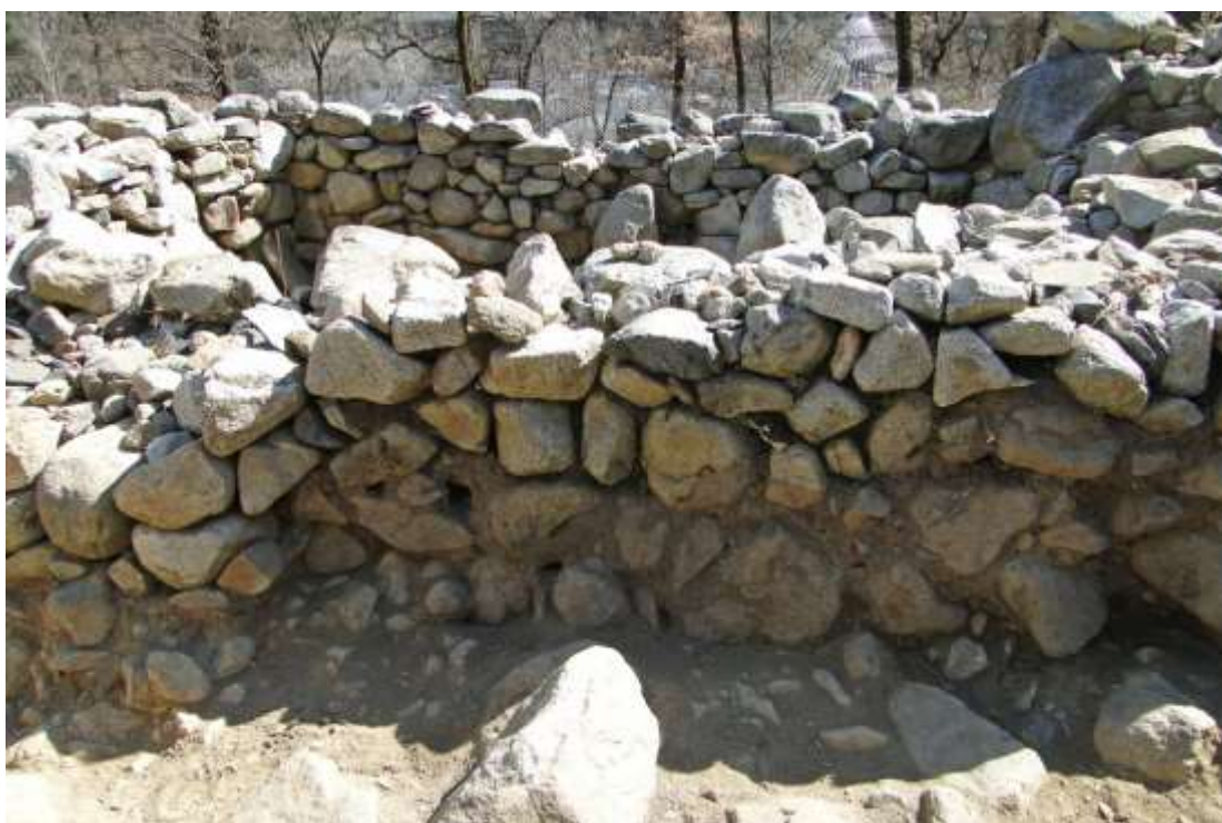
Imatge de detall del mur MR 8 per la banda sud oest.
