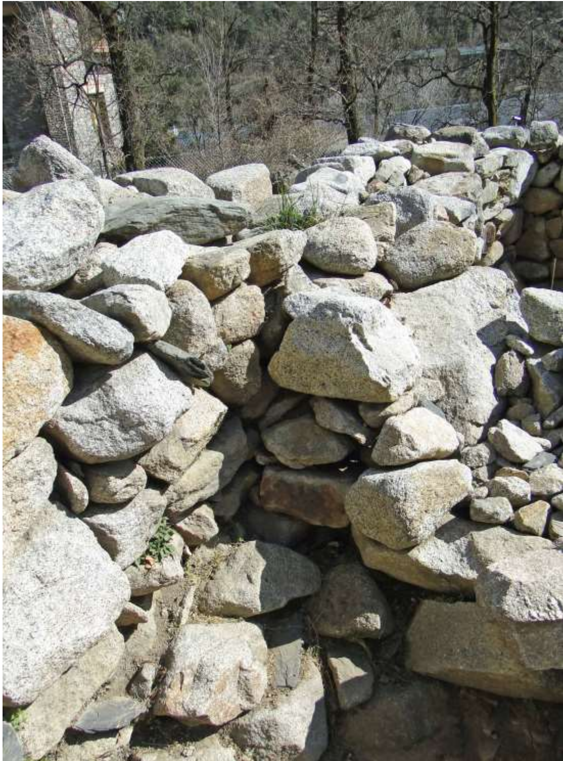
Relació dels murs MR8 adossant-se al mur MR4.
