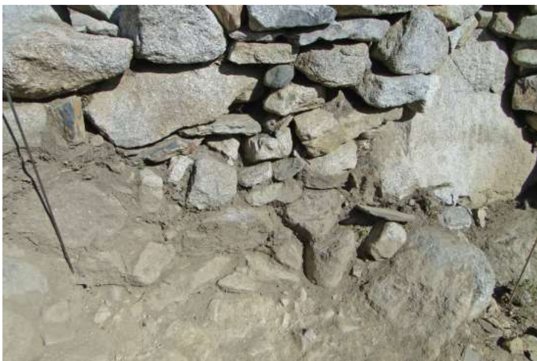
Imatge de detall del mur MR 8 per la banda oriental.
