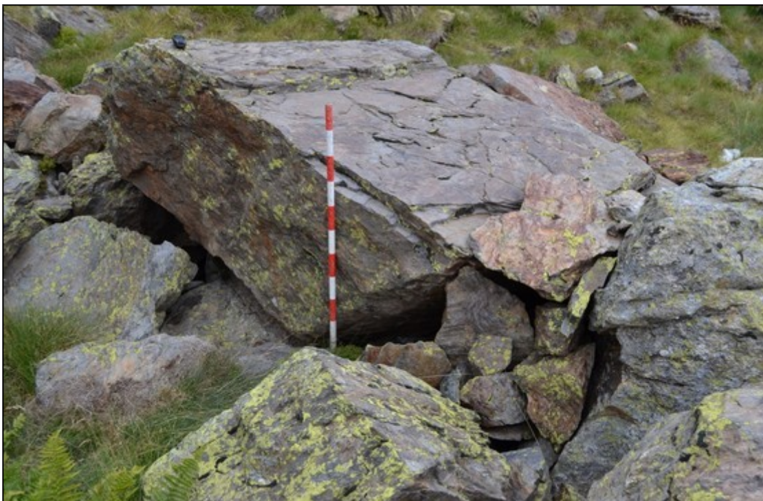
Fig. 112. Vista des de l'oest del parament de la CV2.
