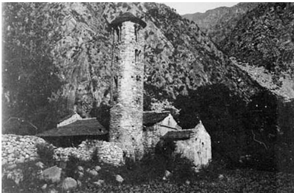
Figura 90: Església de Santa Coloma al 1918 on es pot apreciar el mur del cementiri bastit en pedra seca i que presenta un tram ensorrat (Autor: Eduard Royo Crespo, 1918) (Font: Arxiu Nacional d'Andorra, CEC_0216).
