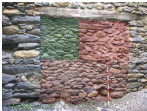
Fig. 53. Porta de prop de 2,5 m d'amplada situada al nord-oest de l'era, el tapiat de la qual presenta un mínim de dos horitzons cronològics diferents (vermell i verd)
