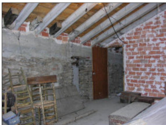
Fig. 41. Angle nord de l'àmbit H.
