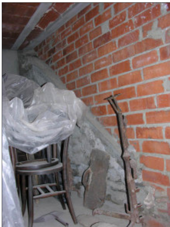
Fig. 15. Detall del tancament de migdia de l'àmbit C1, fet amb totxana, que recolza sobre l'escala de pedra que mena al pis superior.
