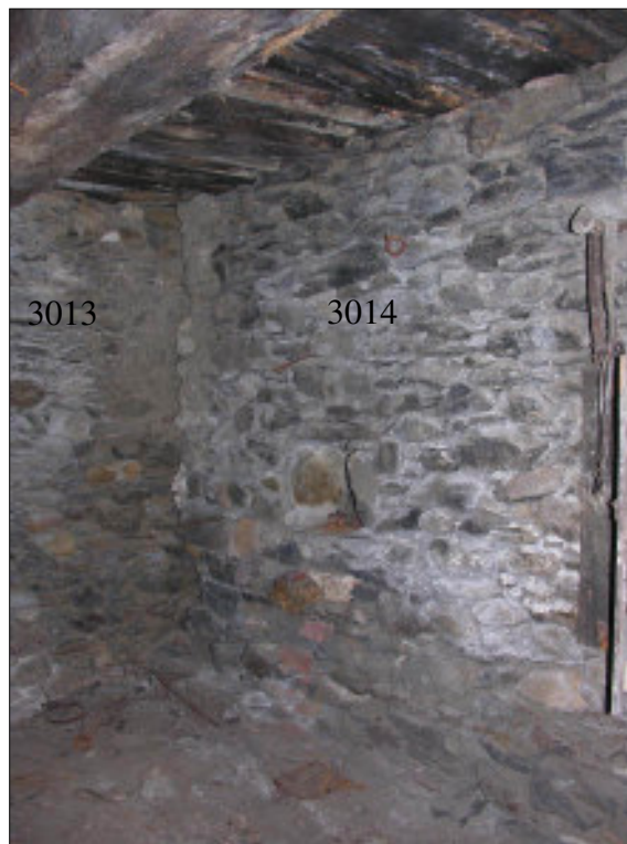
Fig. 20. Detall de l'angle sud de l'àmbit E1, on s'observa que el mur 3014 s'adossa a 3013.
