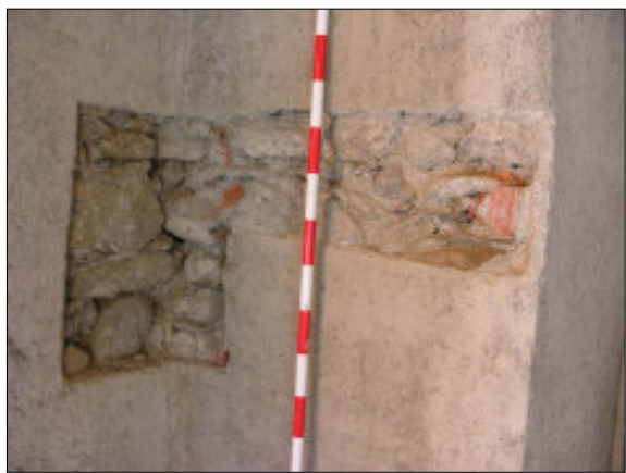
Fig. 127. Detall de l'extrem de migdia de la cala 28, on s'observa la relació entre els murs 3001 i 3052.
