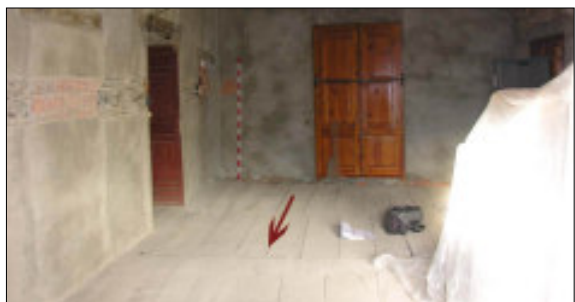
Fig. 137. Cos de llevant del segon pis on, assenyalada amb la sageta, es troba la superfície d'arrassament del mur que l'hauria subdividit en dos espais.
