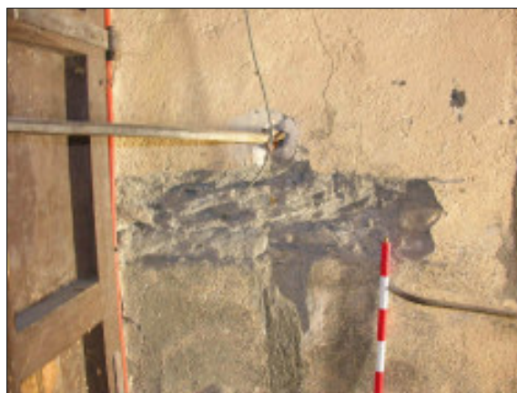
Fig. 129. Vista frontal de la cala 30, oberta a la façana de ponent de la casa.
