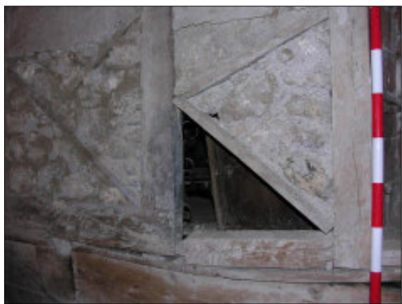
Fig. 123. Vista des de llevant de la cala 26, que va deixar al descobert un nou entramat de pedra i fusta.
