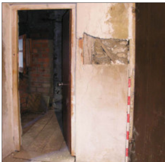
Fig. 115. Vista de la cala 20, efectuada a llevant del vestíbul o àmbit E2.
