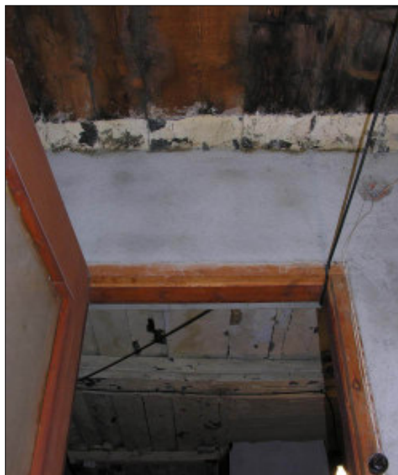
Fig. 14. detall de l'embigat dels àmbits A1 i B1.
