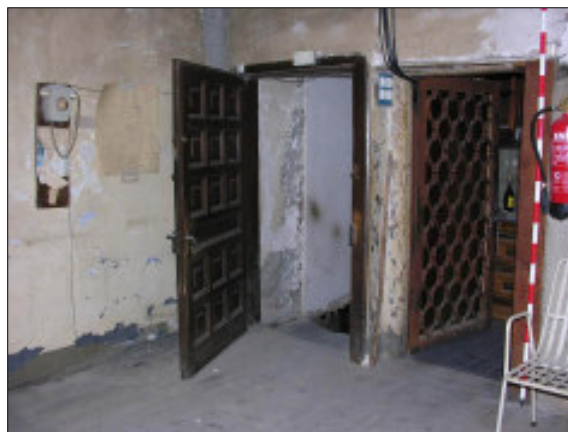
Fig. 27. Cantonada de ponent de l'àmbit E2. En primer terme, la porta 4033 que permet accedir a la planta baixa per l'escala 3021.
