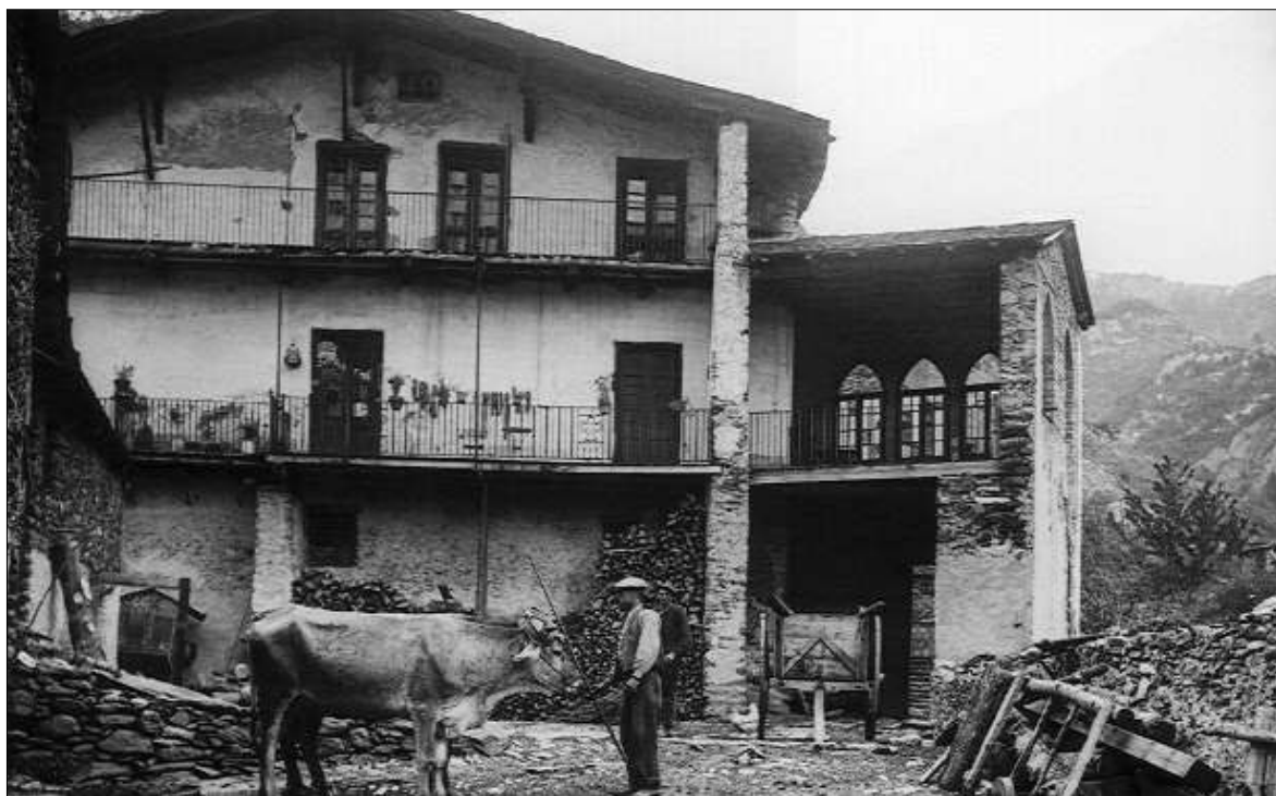
Fig. 62. Façana de migdia de la casa Rossell l'any 1930. Fotografia: Institut d'estudi Fotogràfics de catalunya. Extreta de www.andorraantiga.com/ordino .
