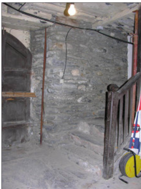
Fig. 13. Angle nord-oest de l'àmbit B1 o rebedor. S'observa el paviment enllosat, els tres primers graons de l'escala que mena a la planta noble i el sostre embigat.
