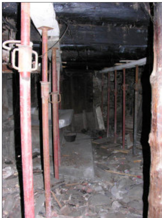
Fig. 49. Aspecte de la planta baixa de la casa del masover, des de la porta situada al sud-est.
