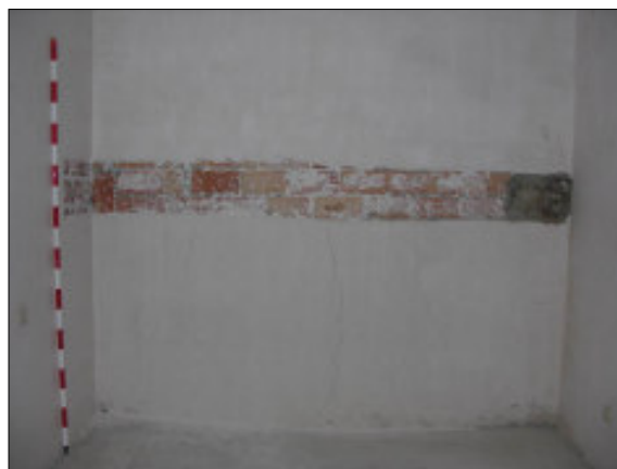
Fig. 109. Cala 14, oberta al mur de llevant de l'àmbit B2.
