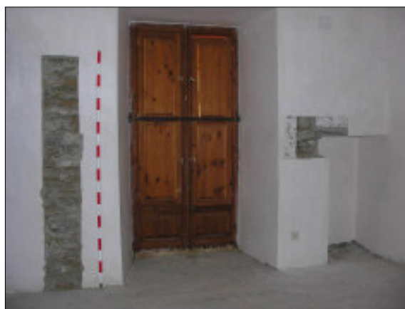
Fig. 105. Vista des del nord del tancament sud-oest de l'àmbit A2 (3001), on es van obrir les cales 10 i 11.
