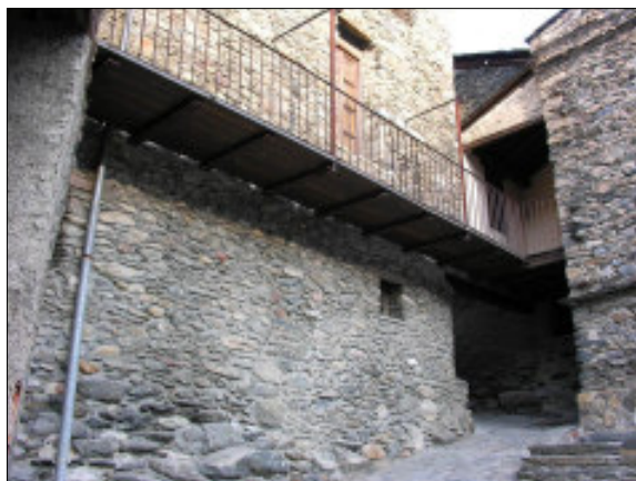
Fig. 12. Part inferior de la façana sud-est, on s'observa que és bastida sobre la roca natural.
