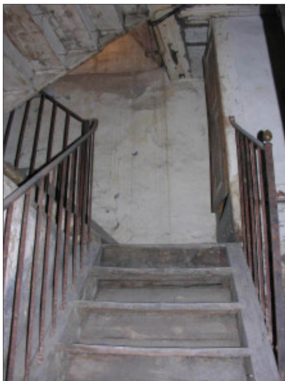
Fig. 35. primer tram de l'escala de fusta que mena a la segona planta de l'edifici.
