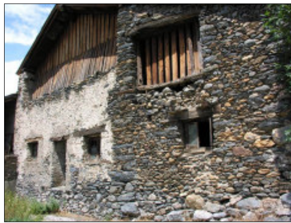
Fig. 44. Façana de migdia de l'edifici que allotja les corts i el paller.
