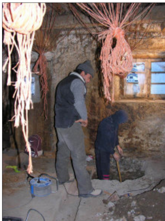
Fig. 64. Excavació d'un dels sondeigs oberts a les corts.
