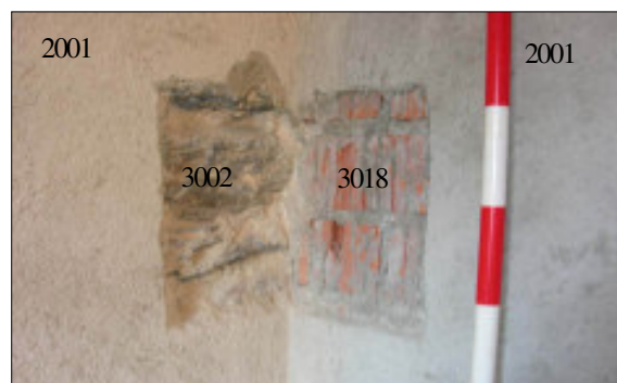
Fig. 94. Detall de la cala 1, oberta a l'àmbit A1.
