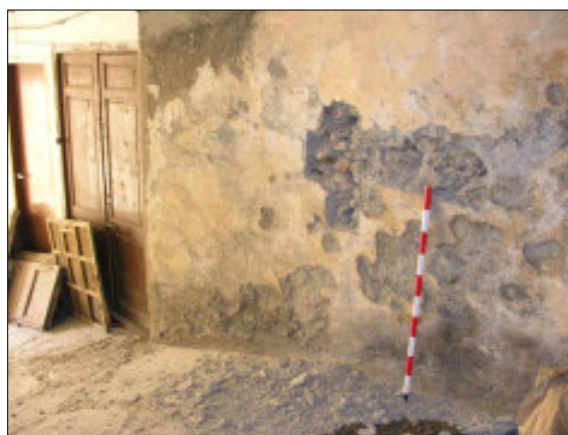
Fig. 131. Vista des del nord-est de la cala 32, oberta a ponent del passatge S.
