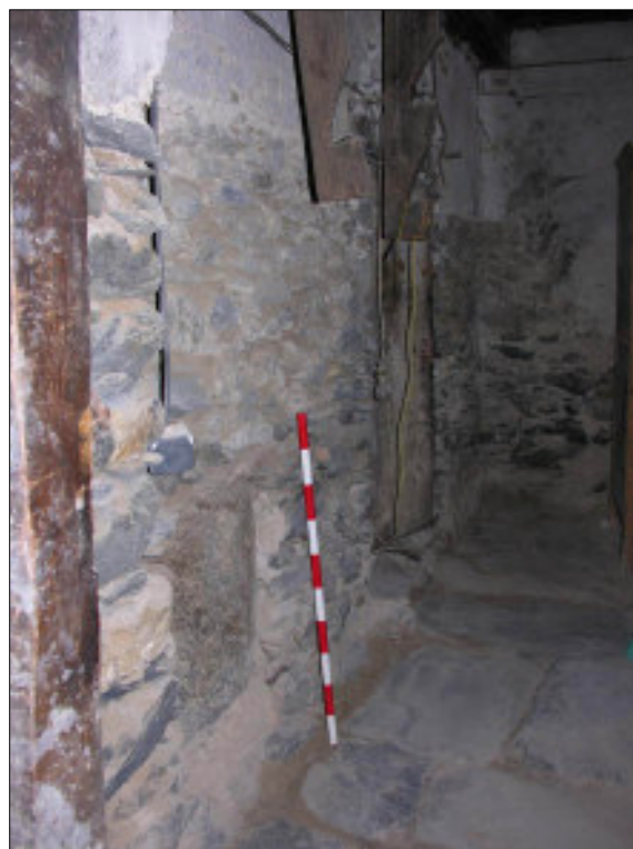
Fig. 100. Vista des de ponent, de l'angle de llevant de l'àmbit F1, on es va obrir la cala 7.
