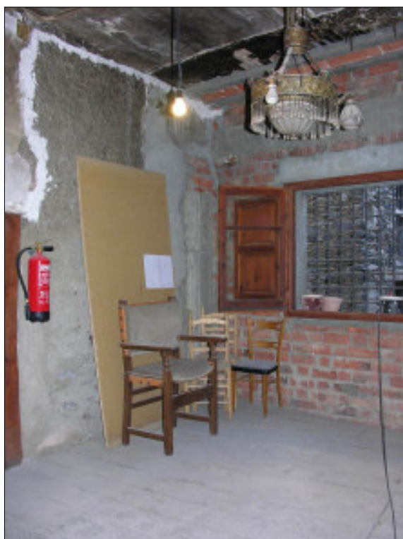
Fig. 28. Vista de l'angle nord de l'àmbit E2.
