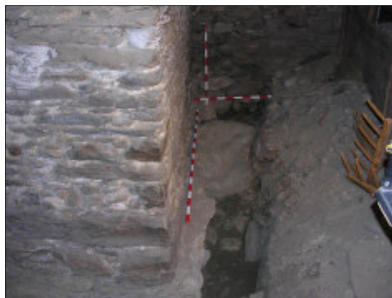
Fig. 66. Detall de l'angle sud-est de l'era, on es va netejar la rasa existent. Foto de Patxi Ozcoz.
