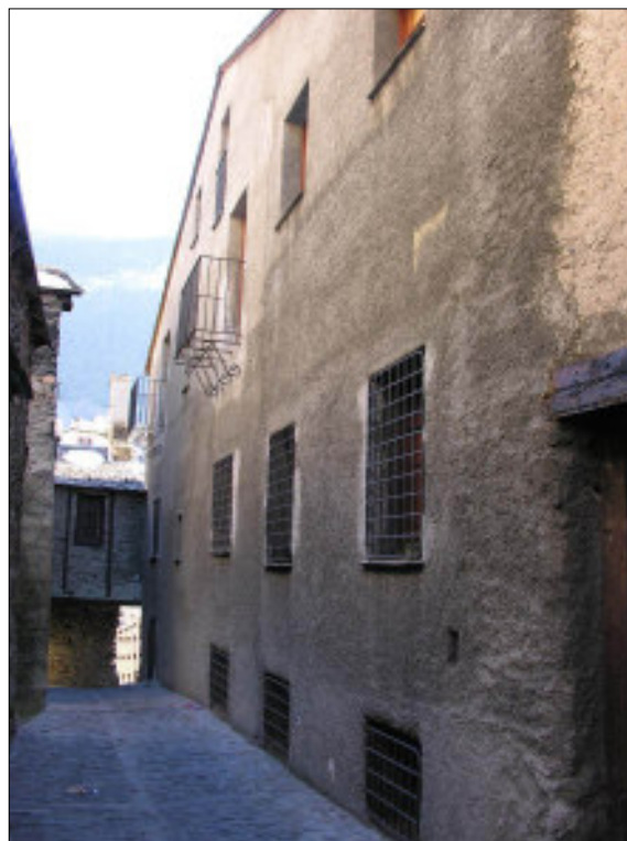
Fig. 10. Vista des del nord del carrer dels Portals.
