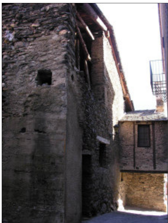
Fig. 52. Façana sud-oest de l'era. En aquesta façana s'obra l'única porta d'accés des de l'exterior i el gaial del primer pis.
