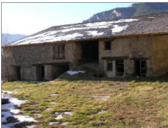
Fig. 43. Vista de l'era des del balcó de la façana principal.
