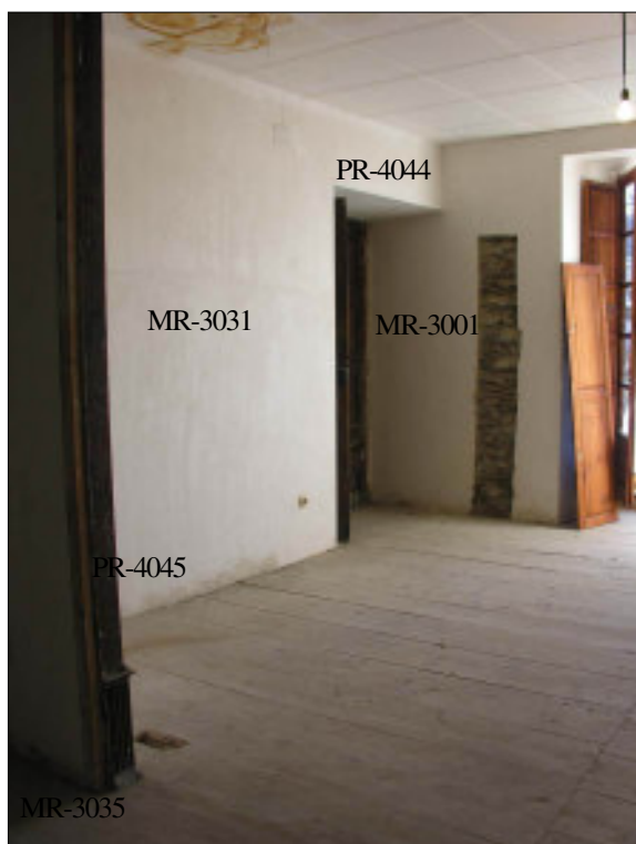
Fig. 33. Vista de l'àmbit A2 des del B2.
