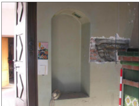
Fig. 110. Cala 15, oberta al tancament nord-oest de l'àmbit D2.
