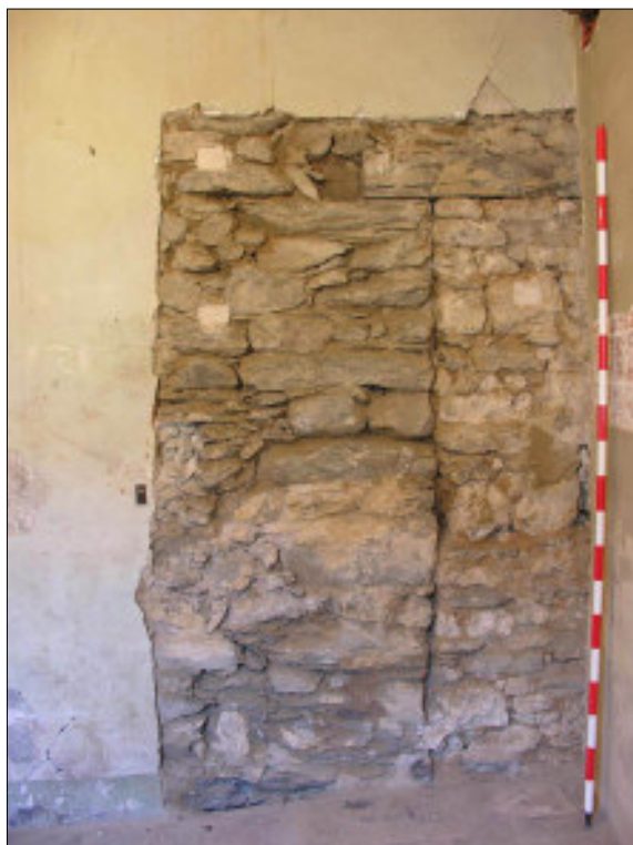
Fig. 117. Cala 23 oberta al mur nord-oest de l'àmbit G1.
