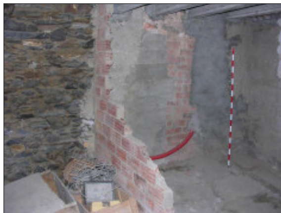
Fig. 18. Angle nord de l'àmbit E1, on es pot veure com part del tancament nord-oest era de pedra i l'extrem de tramuntana de totxana.
