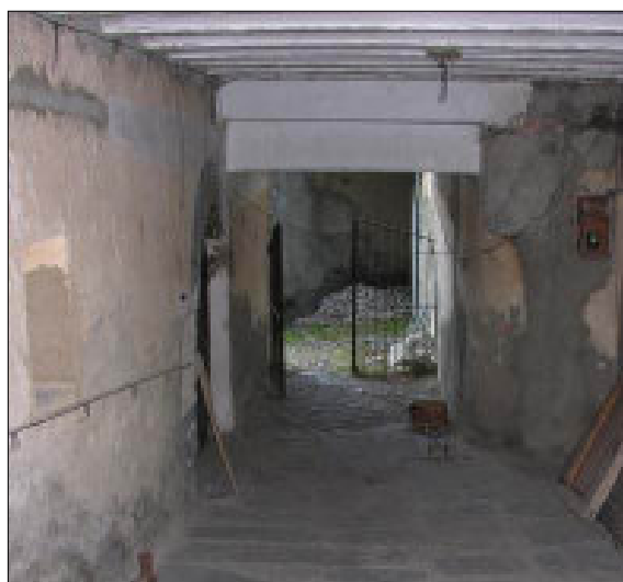
Fig. 7. Vista des del nord-est del passadís S, que posa en contacte el carrer dels portals amb el pati de la casa. a mà esquerra s'obra el portal principal d'accés a l'edifici.
