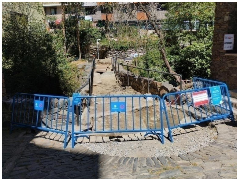
Zona d'excavació amb les tanques i senyalitzacions. Vist des del sud
