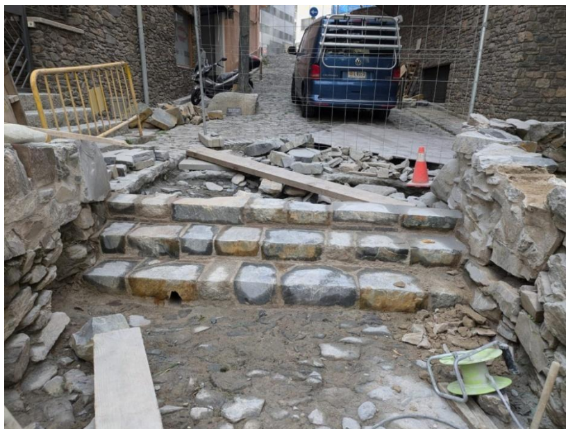
Realització dels esglaons de l'escala
