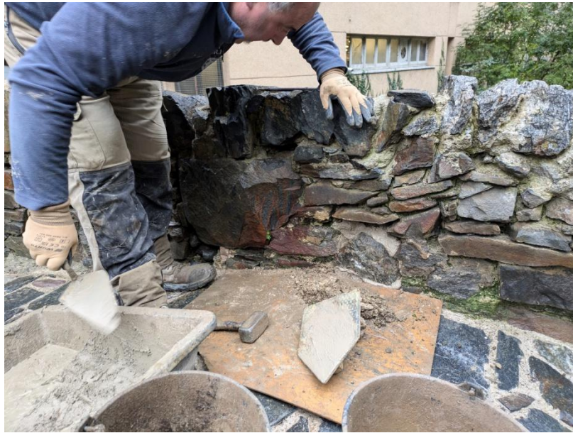
Col·locació de morter i pedres en els grans forats
