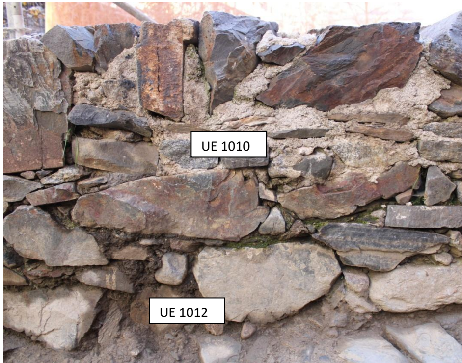
Vista de detall dels murs UE 1010 i 1012. Vist des de l'oest
