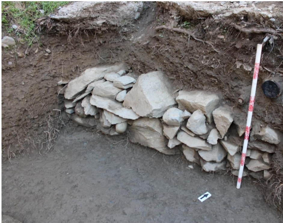
Vista general de la canalització UE 1014. Vist des del sud-est
