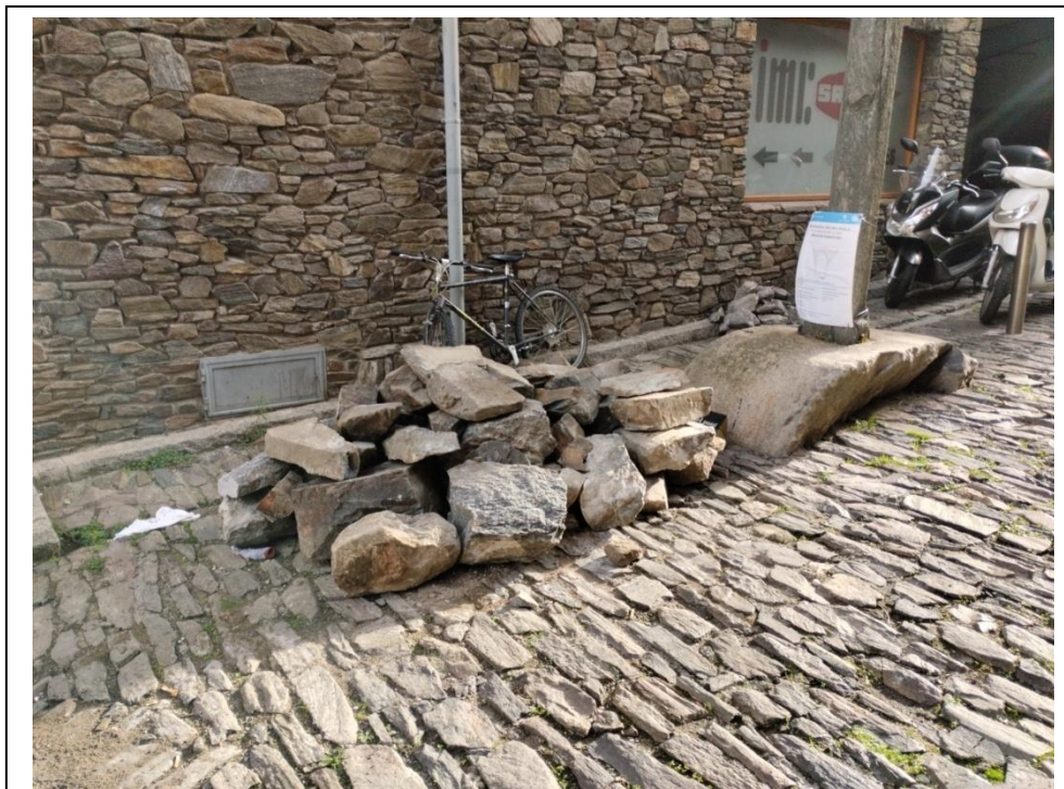
Acopi de part de les pedres desmuntades. Vist des de l'oest
