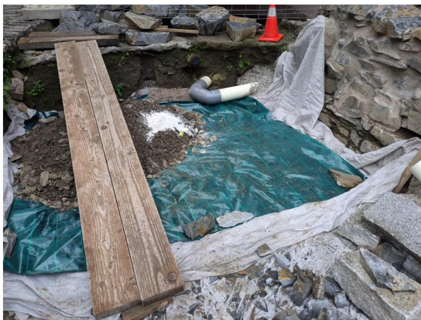
Cobriments del paviment amb plàstic
