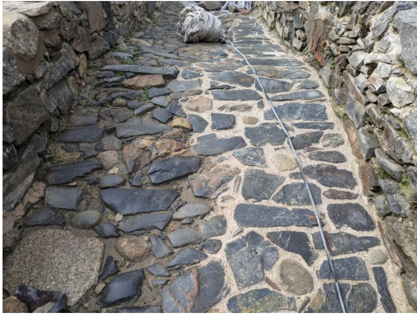
Detall de part del paviment original restaurat
