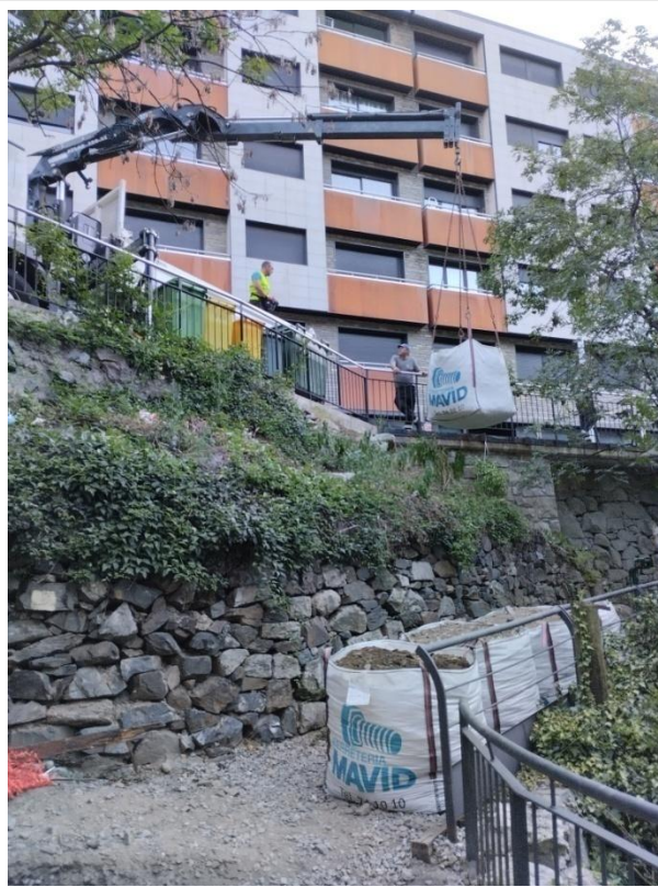
Retirada dels sacs d'obra. Vist des del sud-oest
