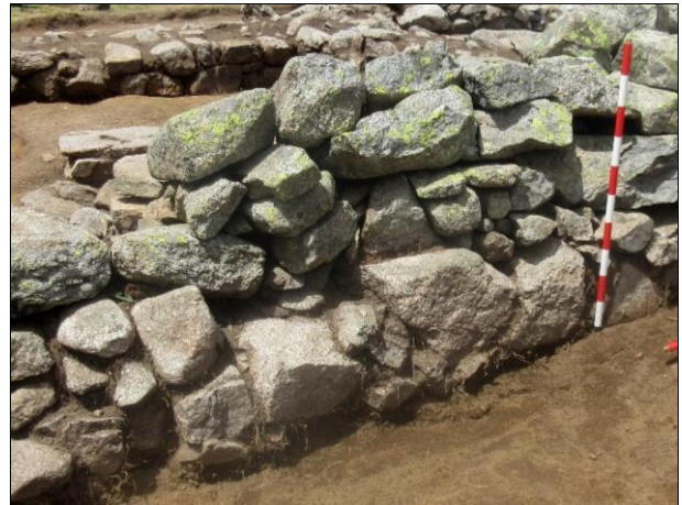
F. 54. Tècnica constructiva: parament exterior façana est.
