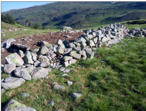
F. 158. Estat inicial de la pleta, prèvia excavació.
