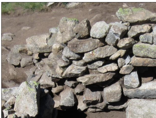
F.265. Aspecte inicial de la cara interna de la façana oest.
