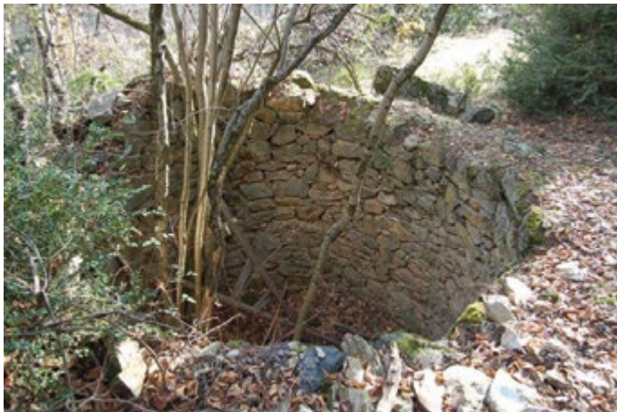
Forn de calç de la Margineda, amb el coronament intacte.
