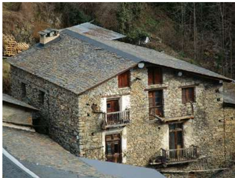
Cal Toni de Pere, on encara es poden veure els forats de les bastides (Fotografia PC)
