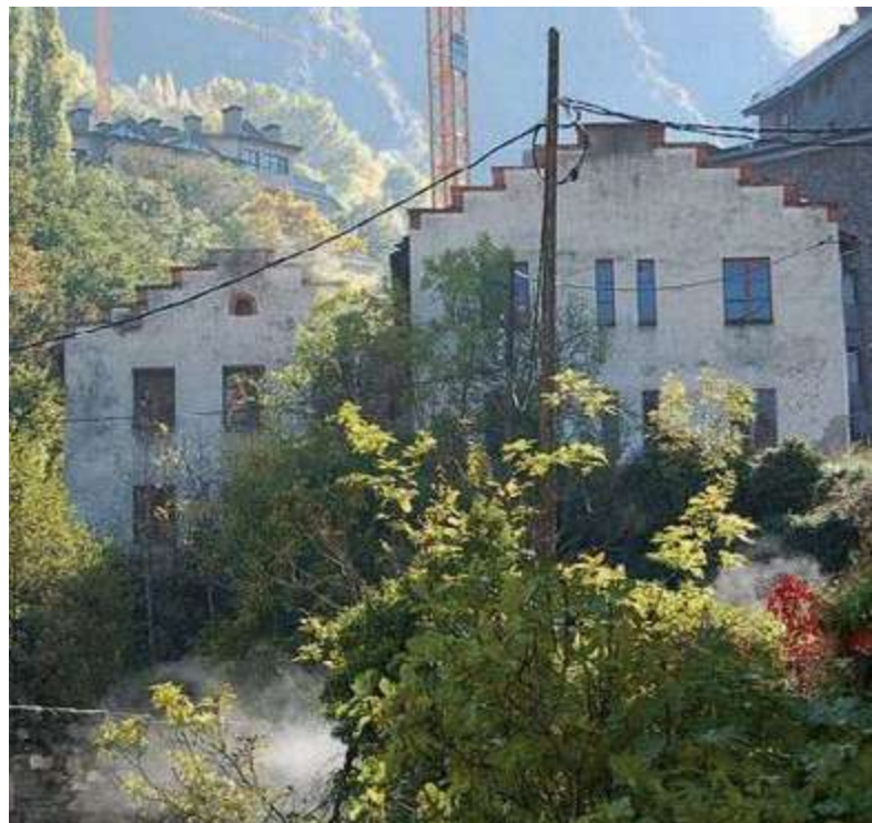
La fàbrica de mantes arran del pont de la Tosca (Fotografia PC)
