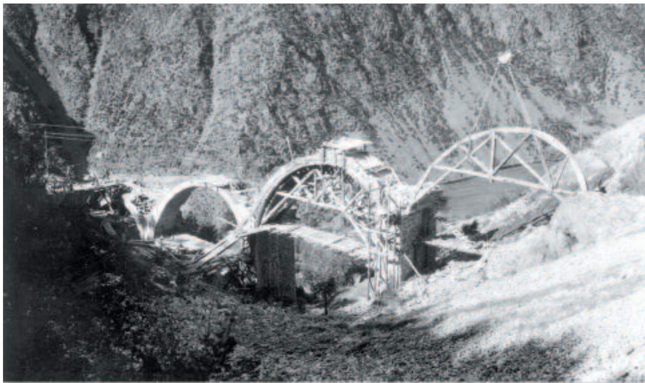
Construcció dels ponts pel pas del conducte forçat i el funicular a les Tresoles. Cintrats, formigó armat i carreus de granit (Fons Joan Vehils, ANA)
