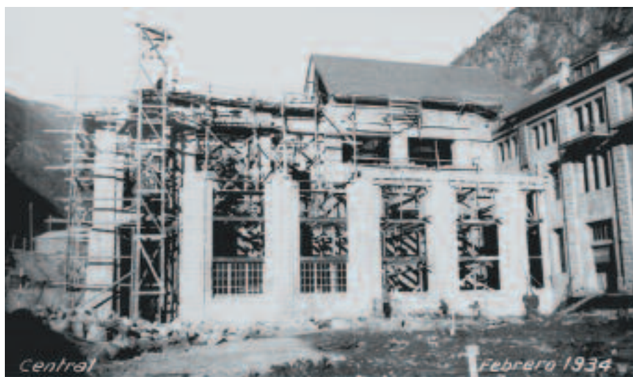
Construcció de la nau nord o sala de màquines, amb la torre de l'ascensor a l'esquerra (Fons FEDA, ANA)
