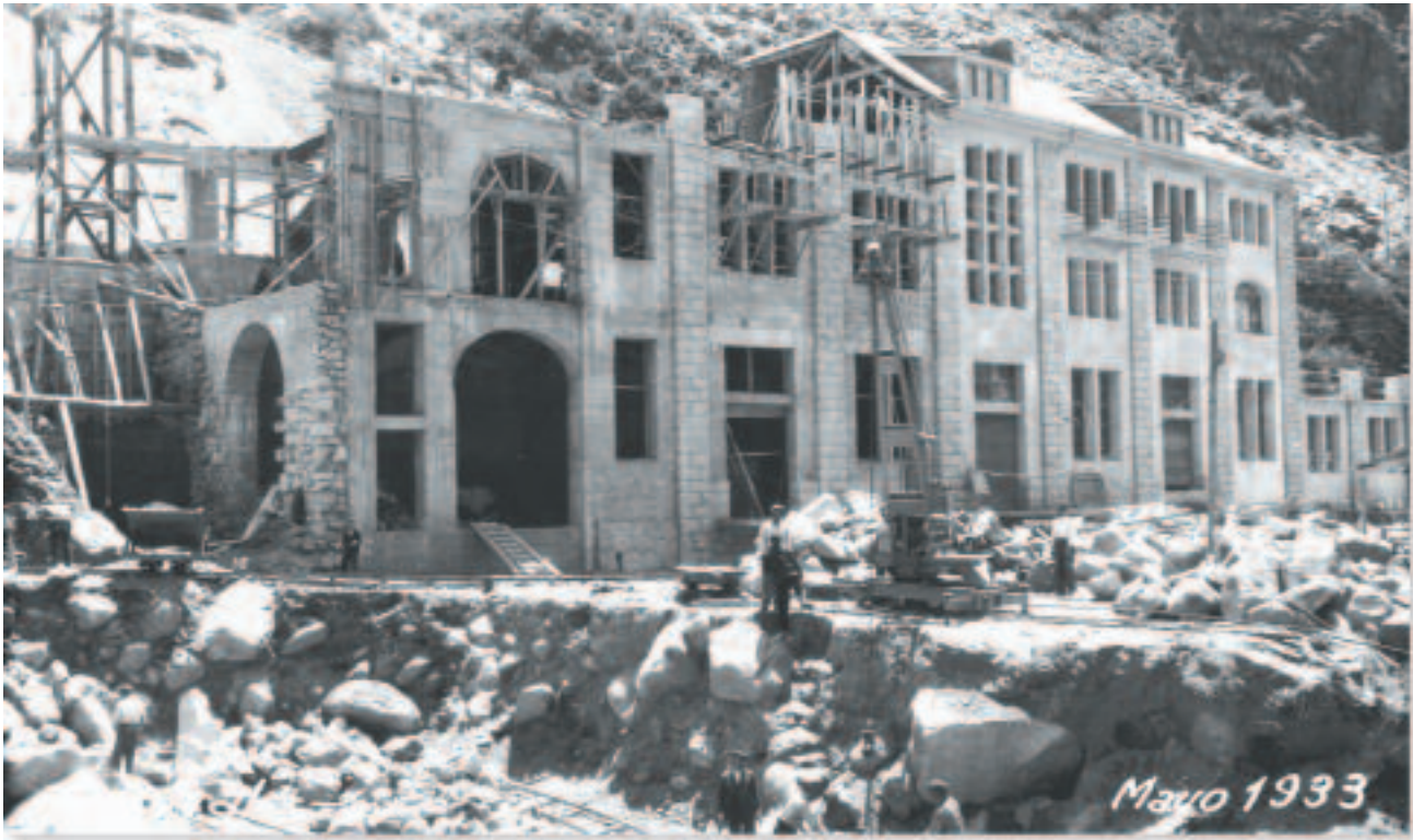
Construcció de la nau est. Observi's la presència de grues i l'ús de cintrats verticals i en arc (Fons FEDA, ANA)
