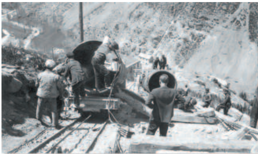
Col·locació dels trams del conducte forçat que baixa a la central des d'Engolasters utilitzant el funicular (Fons Joan Vehils, ANA)
