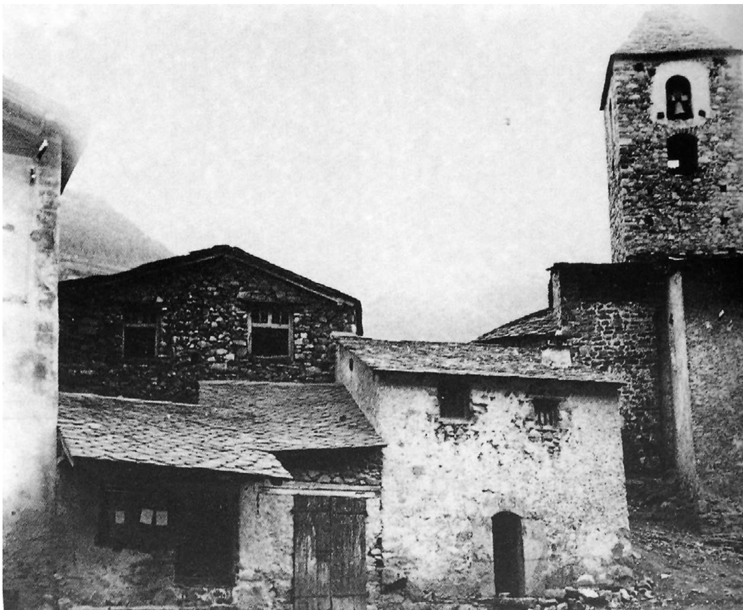
Imatge de l'any 1916 que correspon a l'angle sud-oest de la plaça, on entre la rectoria i l'església es pot veure una casa pairal amb les característiques constructives dels edificis que daten d'entre la baixa edat mitjana i l'alta edat moderna (a l'origen, la Casa de la Vall tenia les finestres del mateix tipus) (Fons J. Salvany 22-FSA).
