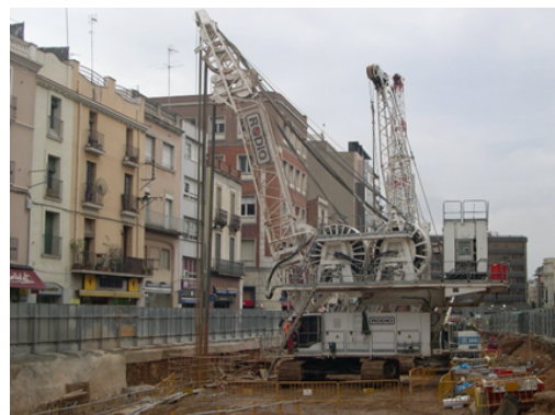
Figura 1. Obres amb maquinària pesant, que hauran d'elaborar un EIA
