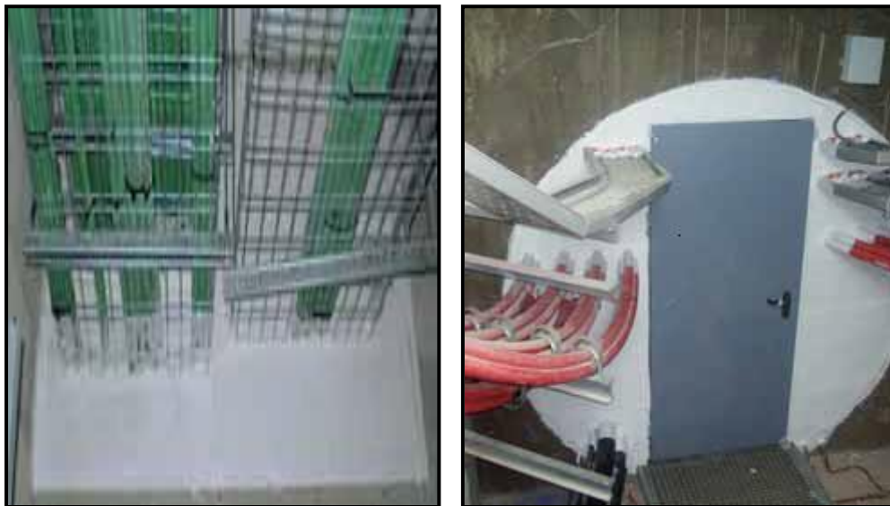
Segellat dels forats d'instal·lació elèctrica (horitzontalment) coixí intumescent, morters
