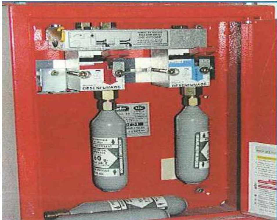
Comandament manual d'extracció de fums per aire comprimit
