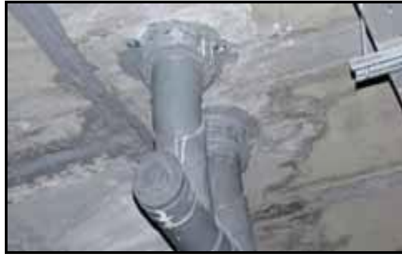
Segellat dels forats de galeries de serveis (verticalment) coixí intumescent, morters
