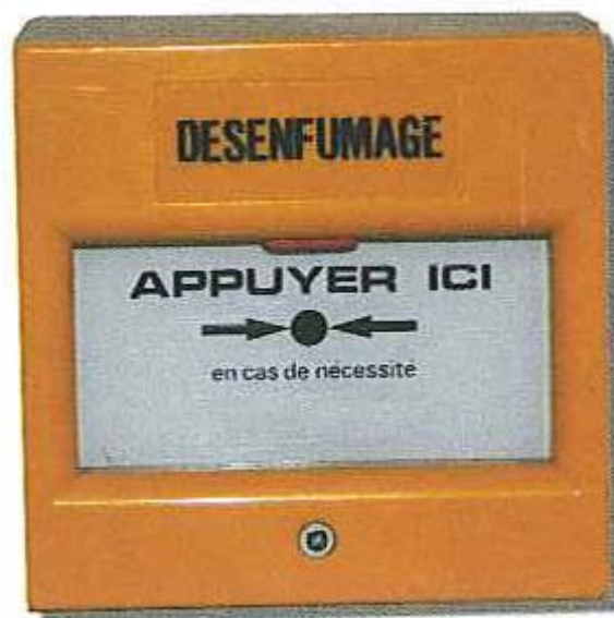
Comandament elèctric d'extracció de fum
