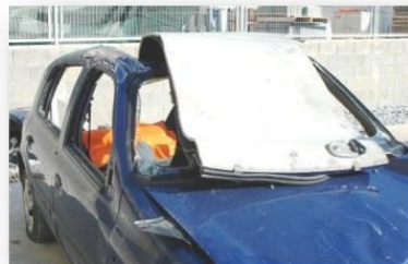
Talls del sostre amb serra de sable
