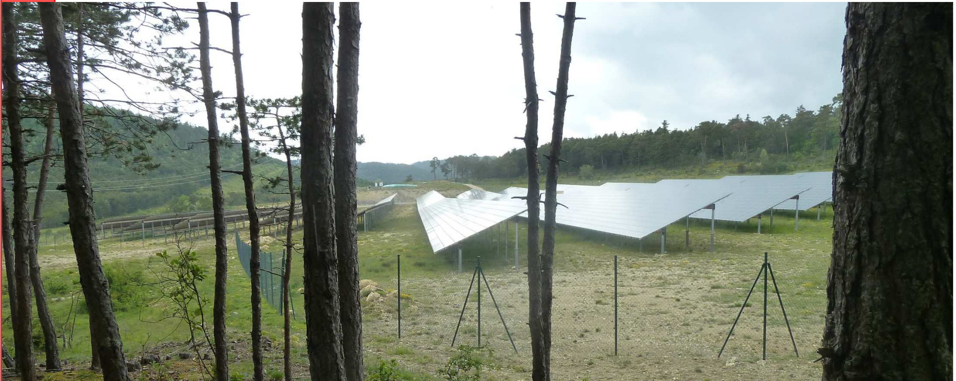
La centrale photovoltaïque de Valderoure. PNR des Préalpes d'Azur, juin 2016 – Workshop ENSP
