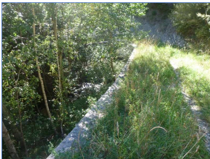
Fotografia 47.- Tram final, parcialment canalitzat
