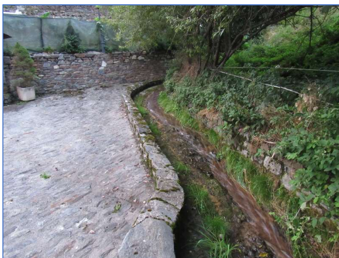
Fotografia 5.- Tram final del riu de Sornàs, del tot canalitzat
