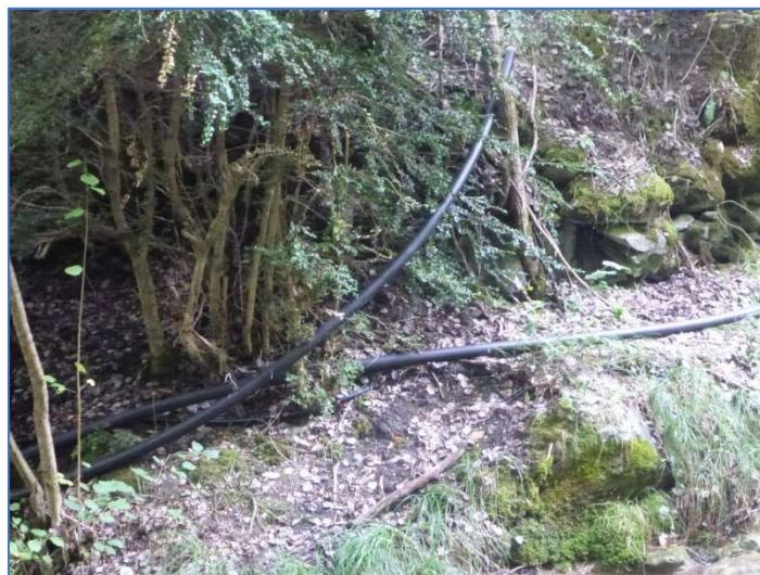
Fotografia 17.- Captacions al tram final del riu de Casamanya
