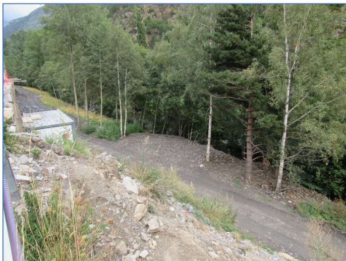
Fotografia 72.- Obres d'eixample de la carretera sota Llorts
