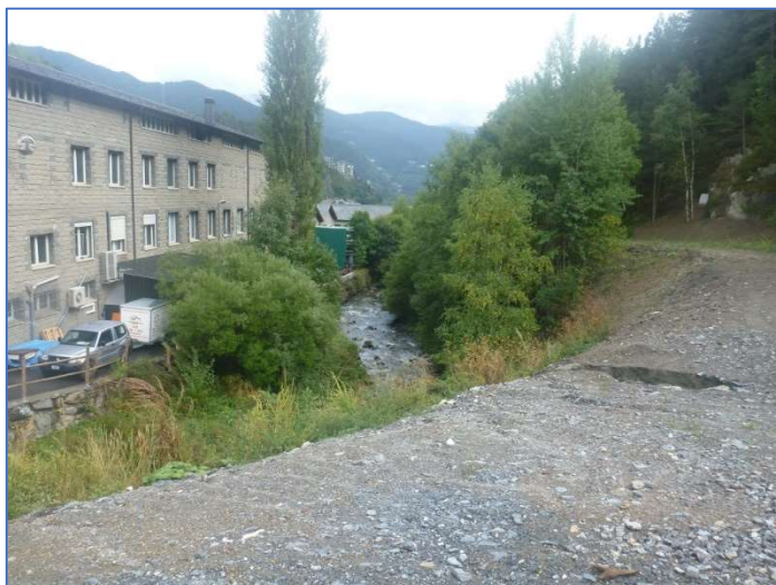
Fotografia 27.- Moviments de terres als accessos al nou camp de futbol de la Massana
