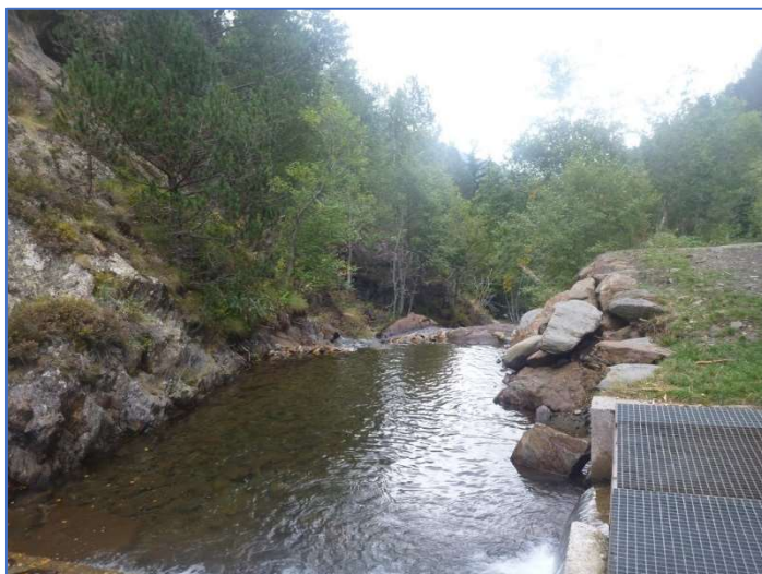
Fotografia 21.- Captació del riu Pollós
