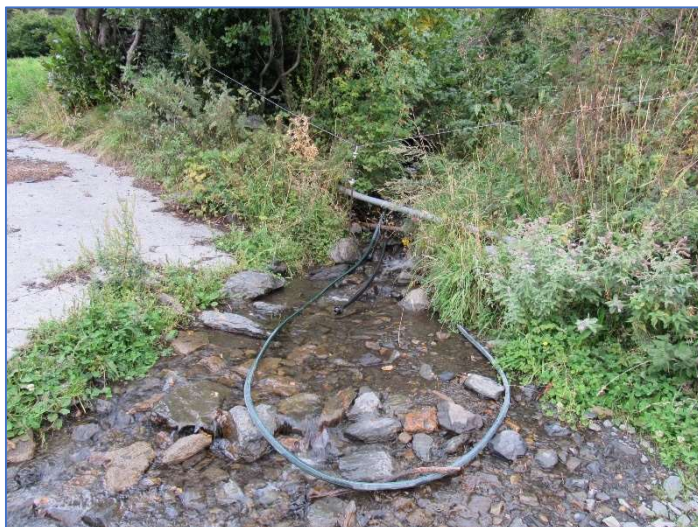
Fotografia 3.- Captacions puntuals a la canal del Tabanell
