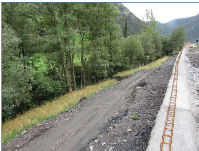
Fotografia 71.- Obres d'eixample de la carretera sota Llorts
