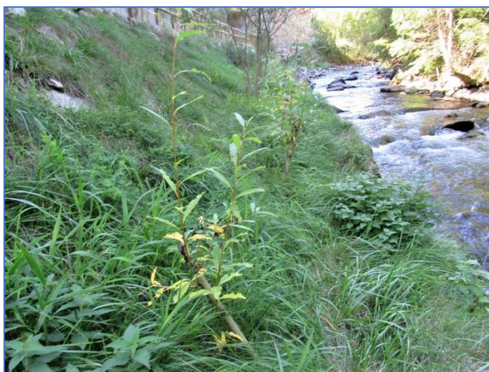
Fotografia 82.- Revegetació entre el camí i la llera al túnel dels Dos Valires
