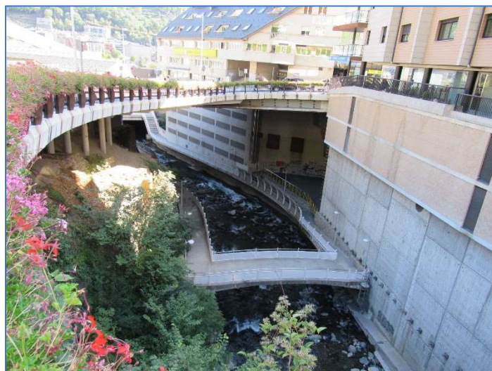
Fotografia 85.- Tram final del Valira del Nord
