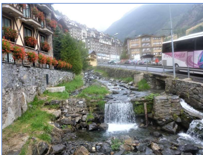
Fotografia 23.- Tram d'Arinsal, canalitzat, amb resclosa i amb col·lectors als marges
