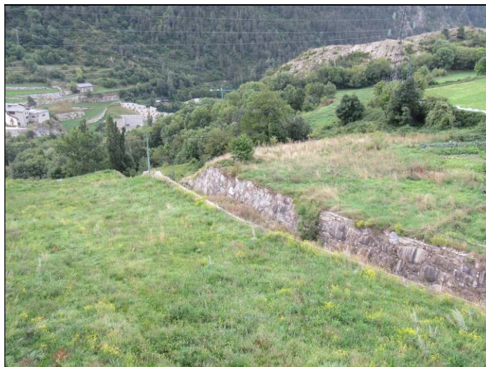
Fotografia 11.- Tram sota Vila, canalitzat fa anys, i on abunda Senecio inaequidens
