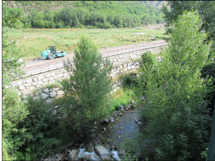
Fotografia 81.- Recrescut de la canalització del marge dret a Cabeca
