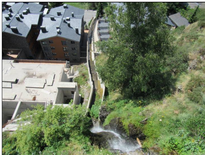
Fotografia 39.- Canalització extrema en el tram del nucli urbà del Tarter
