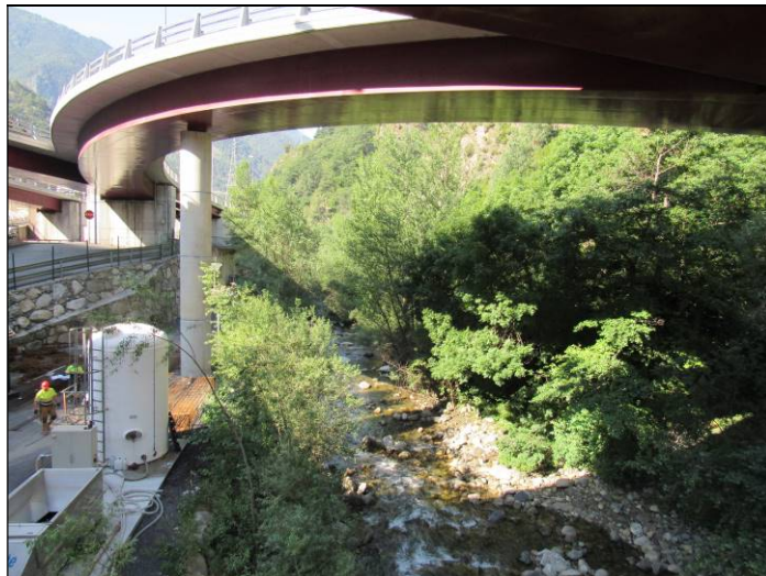
Fotografia 82.- Sota el túnel dels Dos Valires al marge dret hi ha el darrer bosc de ribera
