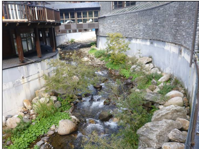
Fotografia 47.- Tram urbanitzat al Palinqueró
