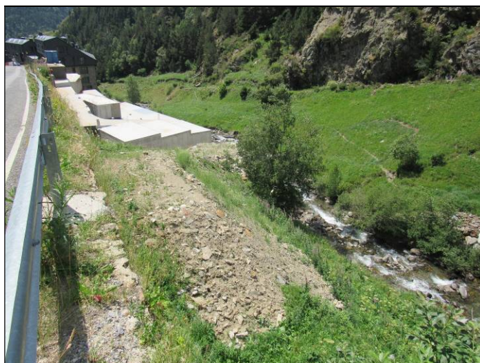
Fotografia 34.- Abocaments de terres i ocupacions a la part alta de Ransol
