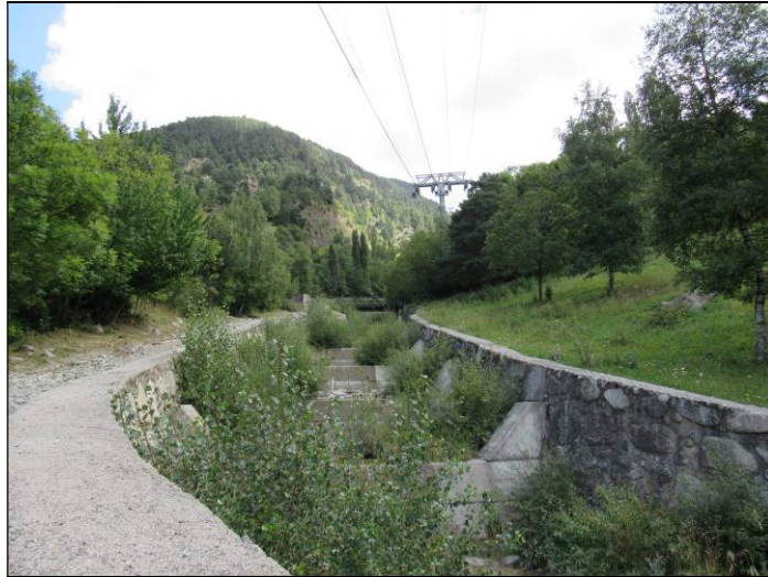
Fotografia 13.- Tram canalitzat sota el Funicamp
