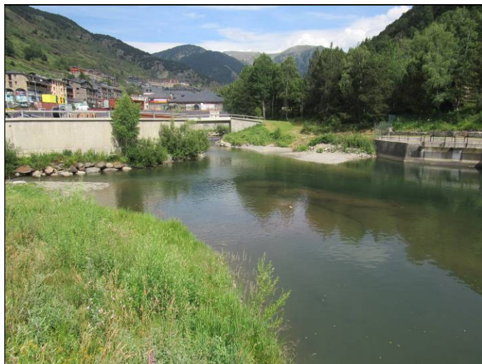
Fotografia 66.- Presa de Ransol
