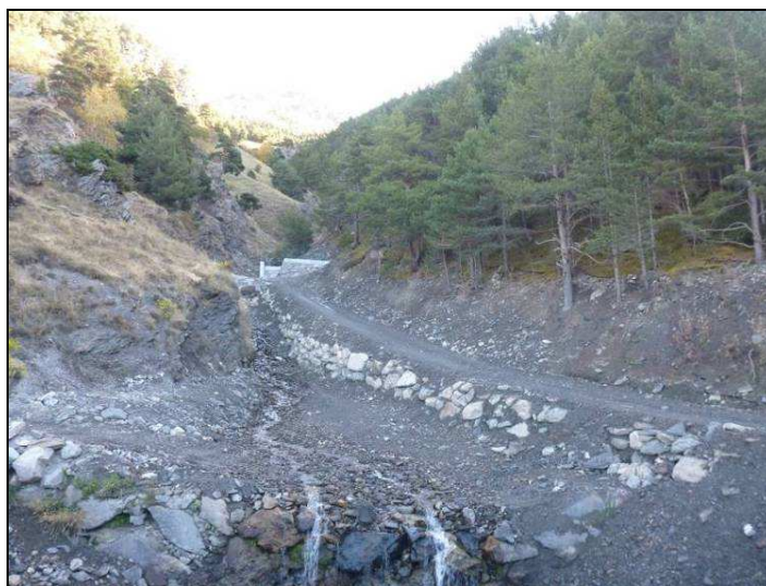
Fotografia 14.- Obres al riu de la Peguera, sobre la carretera de la Peguera
