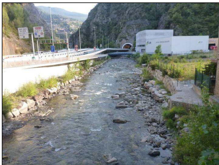
Fotografia 62.- Tram canalitzat recentment prop del túnel de la Tàpia
