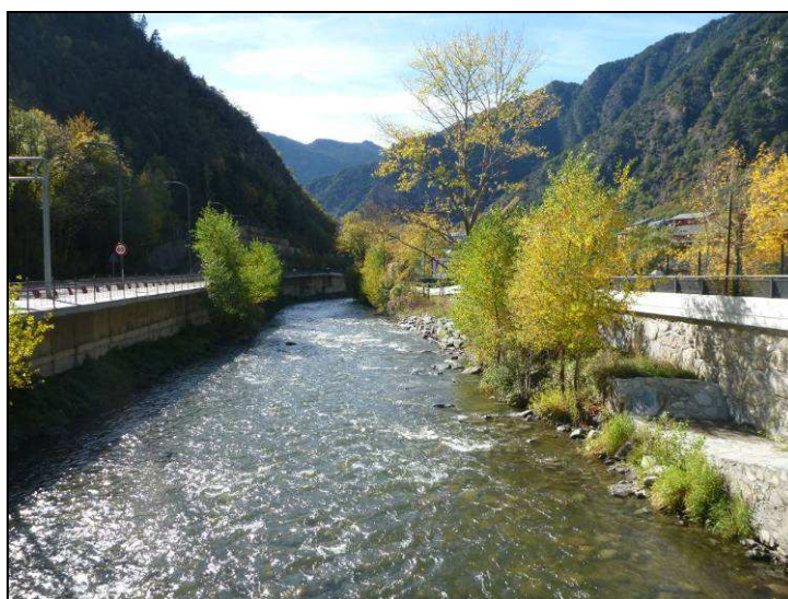
Fotografia 58.- Col·lector mal vegetat sota la caserna de bombers
