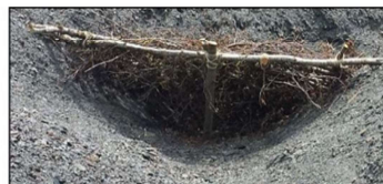
Microdic recentment construït vist des de dalt.
