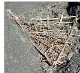
El mateix microdic vist frontalment des de sota. Ja ple de sediment en la cara d'aigües amunt.
