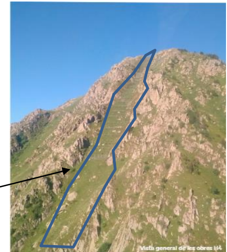
Obra del Corredor H4 acabada
