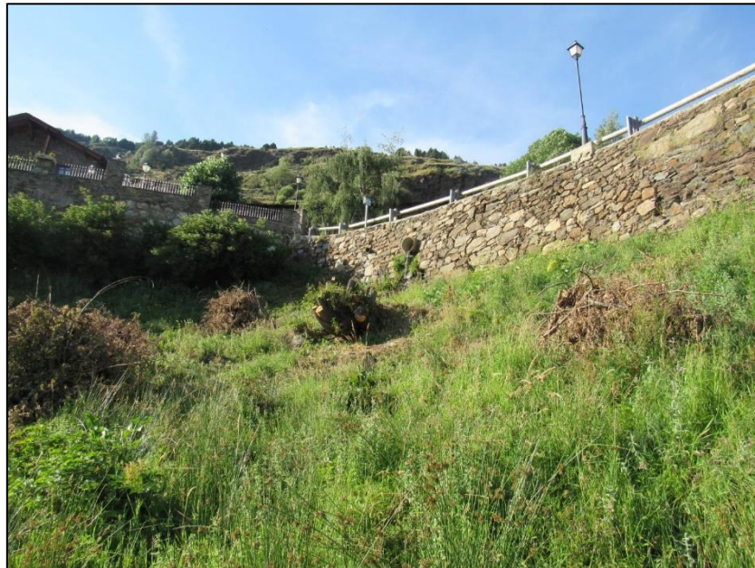
ZH 02074017: Els prats abandonats del Tarter, a tocar de la carretera
