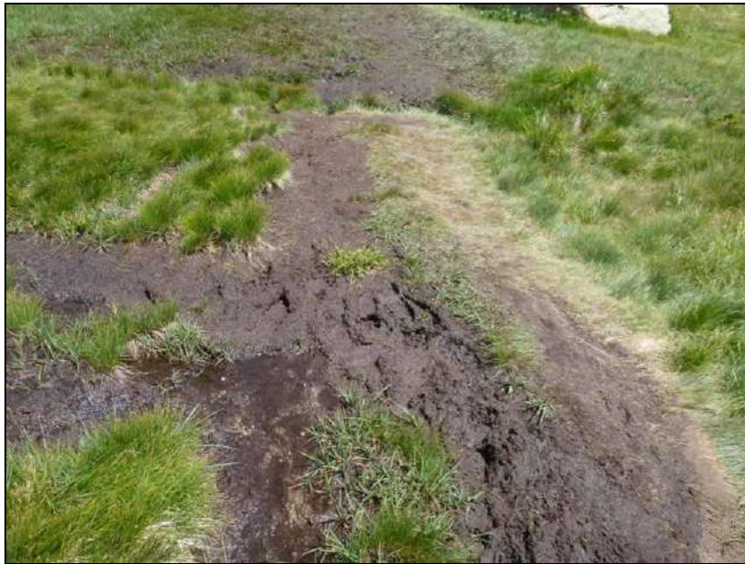
ZH 02152033: Tram que cal protegir amb una passera de fusta
