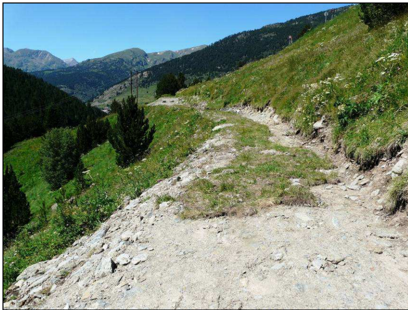
Restitució parcial de la coberta vegetal dins la traça afectada pel pas del col·lector (mollera 03112045)
