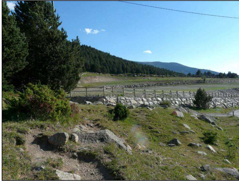
Reblert de milers de metres cúbics de terres pocs metres per sobre de la mollera 02113009
