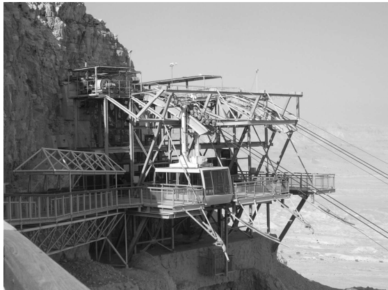
Transport turístic a Masada (Israel). Estació d'arribada poc integrada paisatgísticament (localització, formes, materials, colors inadequats). La localització estava limitada (no es podia arribar al cim per qüestions arqueològiques)
