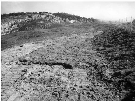
Recuperació i posterior estesa de glevs d'herba en pistes d'esquí de fons al Valle del Roncal (Navarra)
