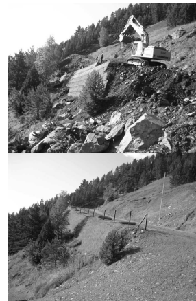
Mur de terra armada (Arinsal)
