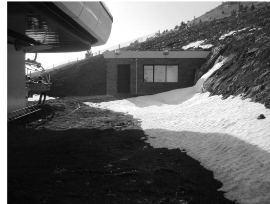
Caseta de control semi-soterrada a l'estació d'arribada del Telecadira La Pia (Masella)
