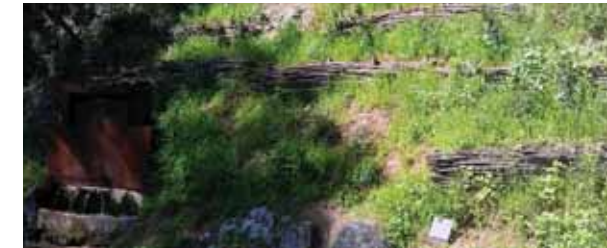
Estabilització amb feixines de branques. www.naturalea.eu
