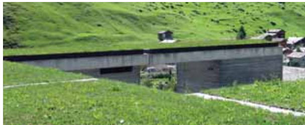
Banys termals de Vals, amb coberta vegetal. Arquitecte: Peter Zumthor.
