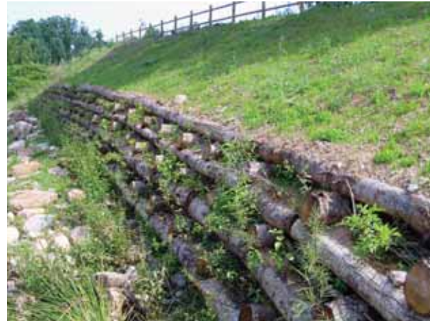
Mur de contenció fet amb entramat viu de tronc que poden provenir de la mateixa intervenció. Autors: Naturalea, www.naturalea.eu
