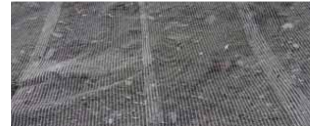
Estabilització amb geomalla.
