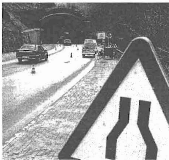
▶▶ Entrada als actuals túnels de la Massana.
